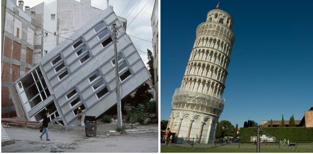
Şekil 2.7. Zeminde meydana gelen sıvılaşmadan dolayı temel göçmesi ve farklı oturma problemleri
