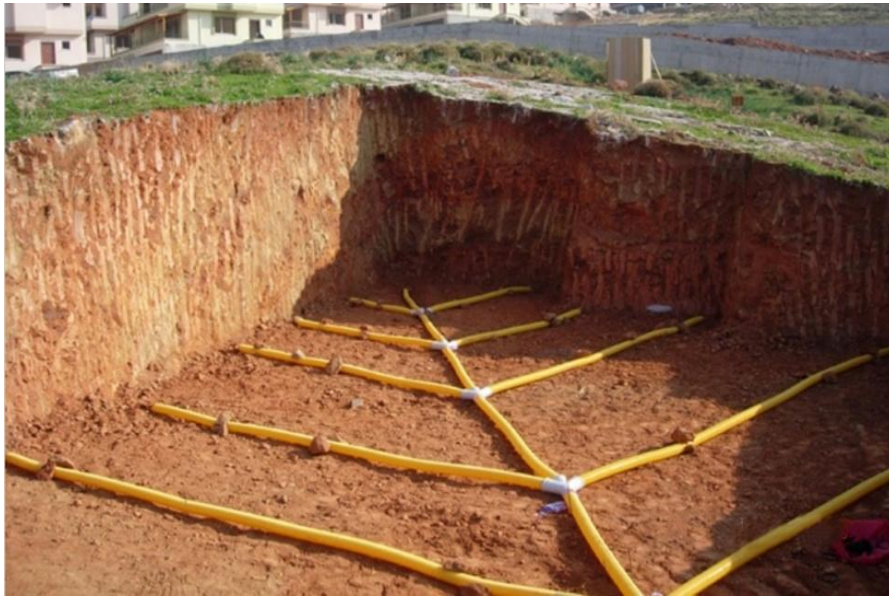
Şekil 2.10. Yüzeysel drenaj
