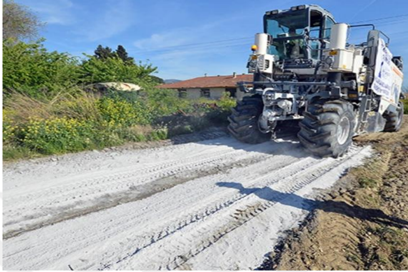
Şekil 2.12. Kireç stabilizasyonu
