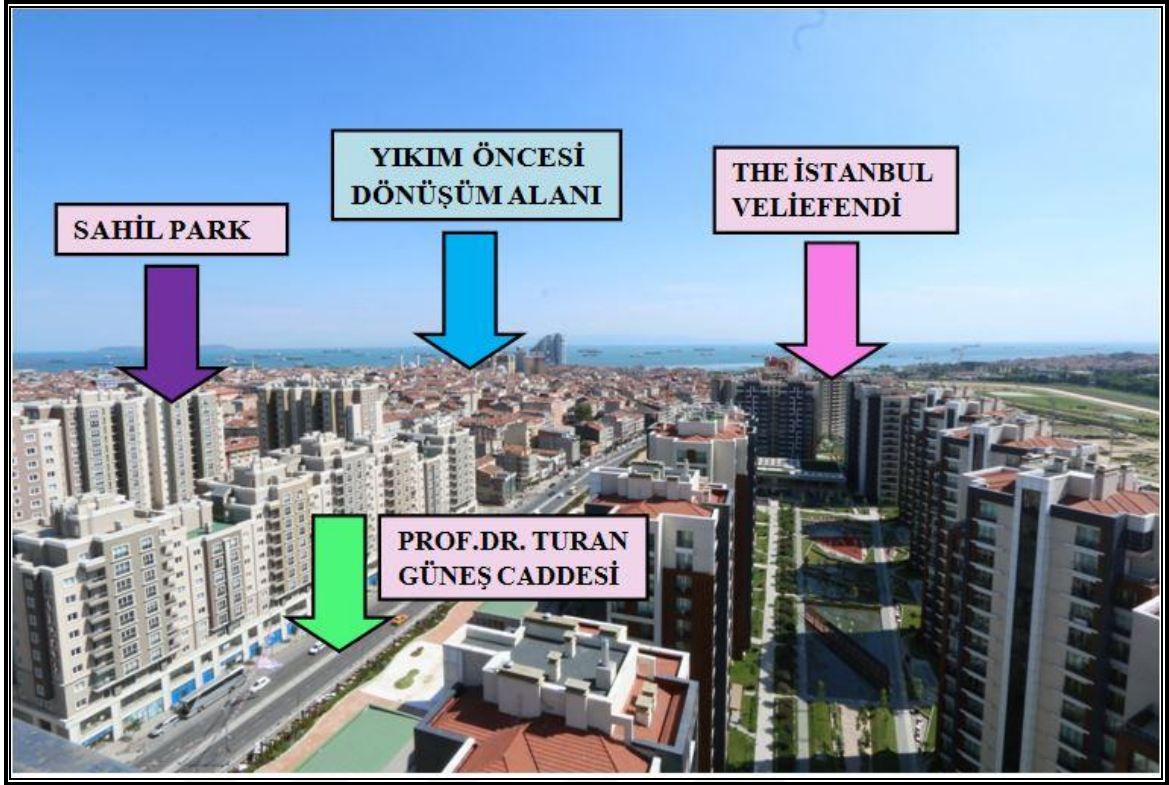
Şekil 4.14. Dönüşüm alanının yıkım öncesi görünümü (KIPTAŞ, 2019)
