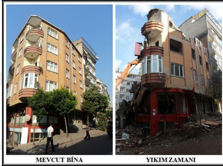
Şekil 4.18. Dönüşüm alanındaki binanın mevcut hali ve yıkım zamanı görüntüsü (KİPTAŞ arşivi, 2018)
