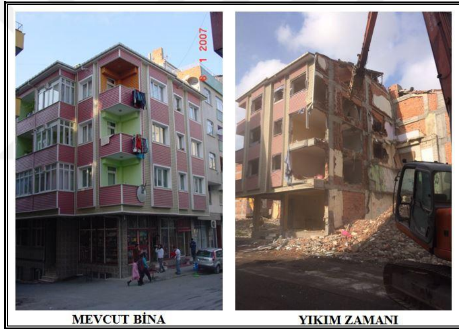
Şekil 4.19. Dönüşüm alanındaki binanın mevcut hali ve yıkım zamanı görüntüsü (KİPTAŞ arşivi, 2018)
