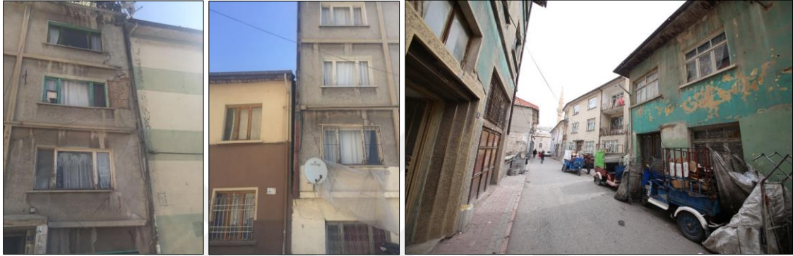
Şekil 4.12. Şükran Mahallesi'ndeki mevcut yapı stoğu (Kişisel arşiv, 2018)
