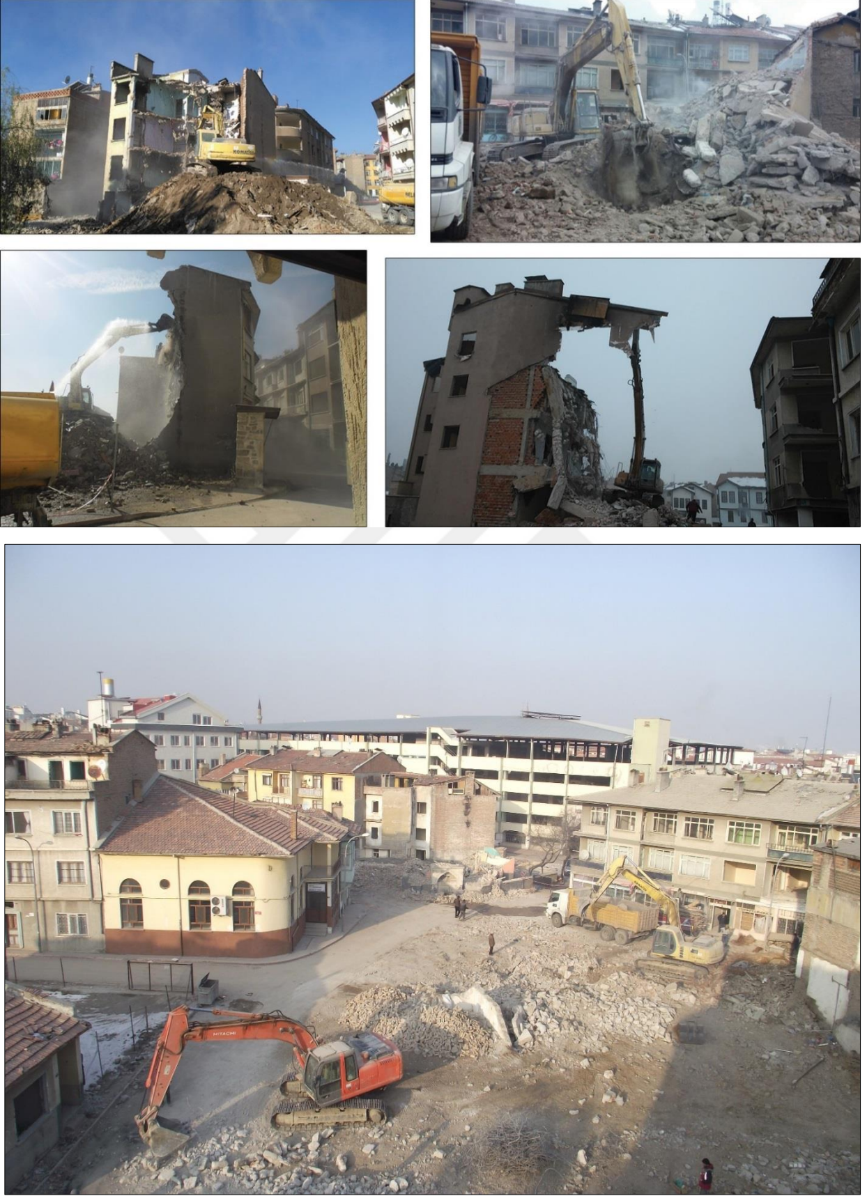
Şekil 4.32. Proje alanındaki yıkım işlemlerine ilişkin fotoğraflar (Meram Belediyesi, 2016)
