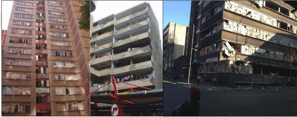
Şekil 2.21. Proje alanındaki terk edilmiş yapılar (Bethlehem, 2014)
