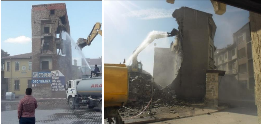
Şekil 4.15. Yıkım işlemleri (Kişisel arşiv, 2018)
