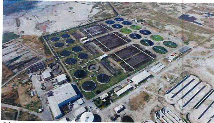
Şekil 2.14 Arıtma prosesi 5 kademeli Bardenpho prosesi olan bir AAT'nin görüntüsü
