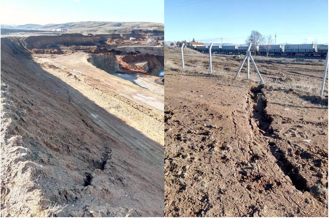
Şekil 3.10. Sahada görülen çekme çatlakları ile kısmi kaymaların gözleendiği ve muhtemel duraysızlıkların oluşması beklenen şevler
