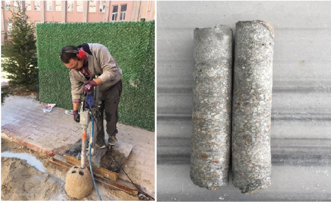
Şekil 3.17. JG kolonlarından karot numunelerinin alınması
