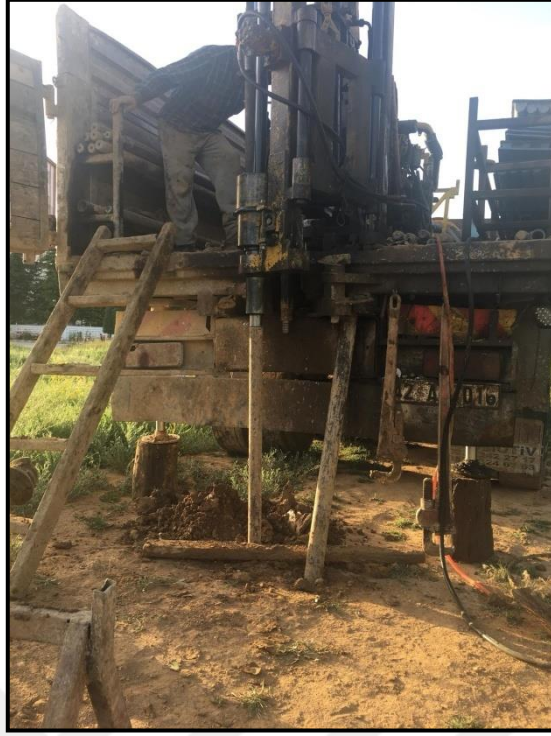
Şekil 6.3. SK-4 numaralı jeoteknik sondaj kuyusunda SPT deneyi yapılışı
