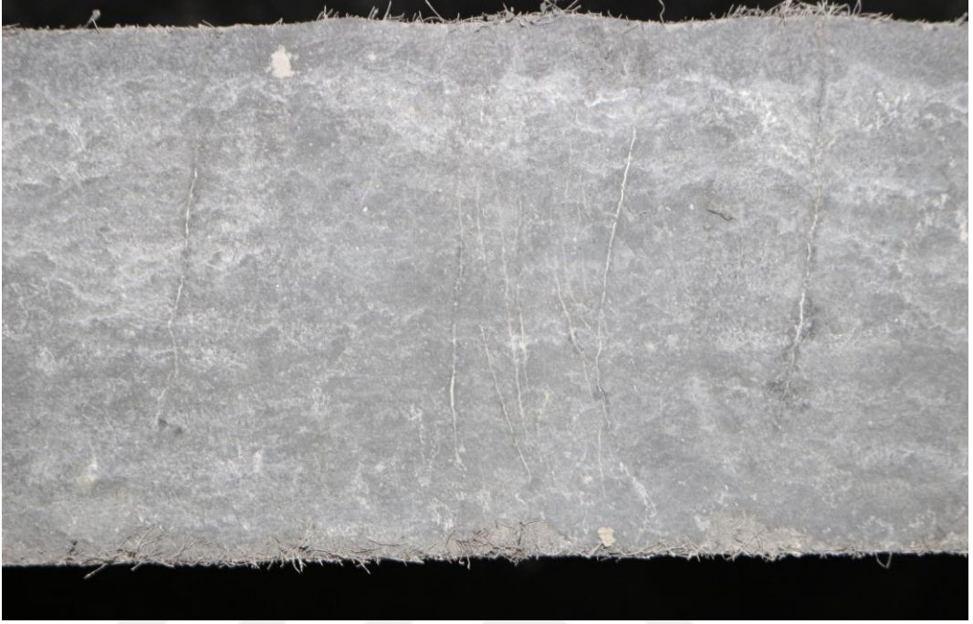
Şekil 4.64 Hasarlı ECC-KNT/NS kiriş numunelerinin bütöün çatlaklarının tam olarak (%100) kendiliğinden iyileşmesi
