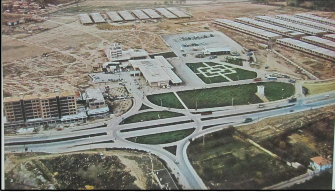
Şekil 5.3.3. Otogar Alanının Havadan Görünümü (Konya Belediyesi, 1972)
