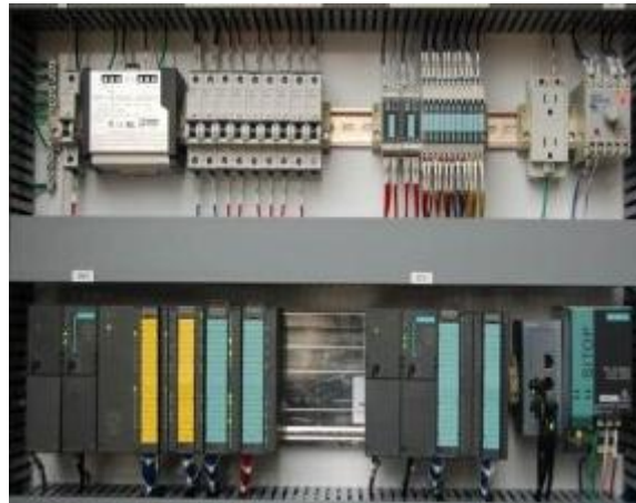
Şekil 2. Otomasyon panosu iç yapısı
