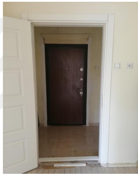
Şekil 4.135. Lojman Kuzeyde Dış Cepheden Kapatılan Kapı
