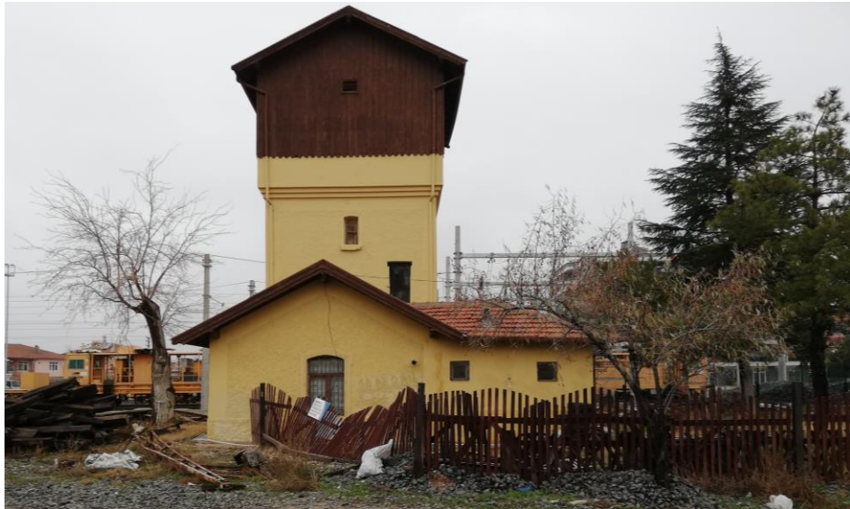
Şekil 4.83. Su Deposu Güney Cephesi
