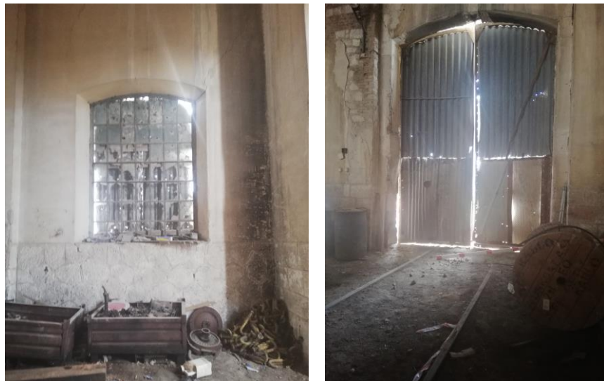
Şekil 4.103. Lokomotif Deposu İç Mekân Kapı ve Pencereleri
