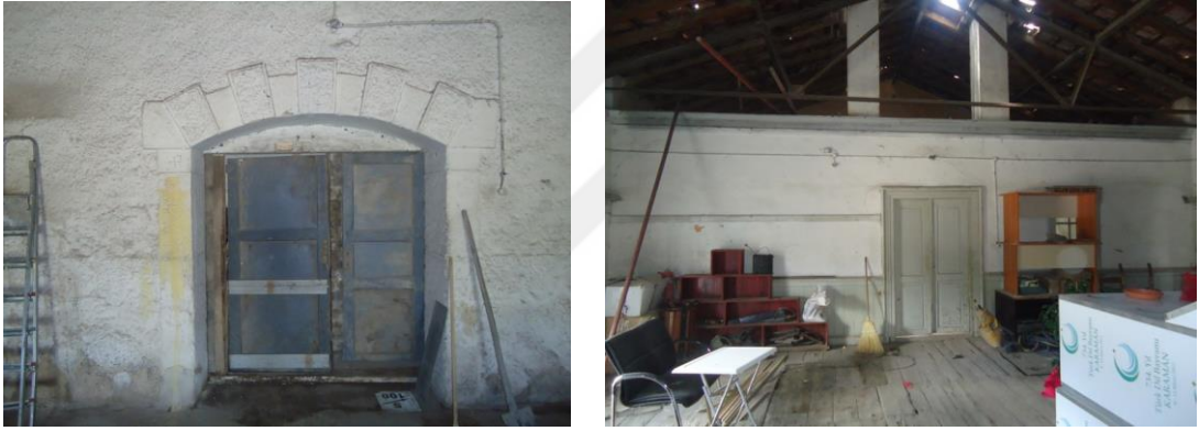
Şekil 4.38. Ambar Binası Eski İç Mekân Kapıları (TCDD arşiv)
