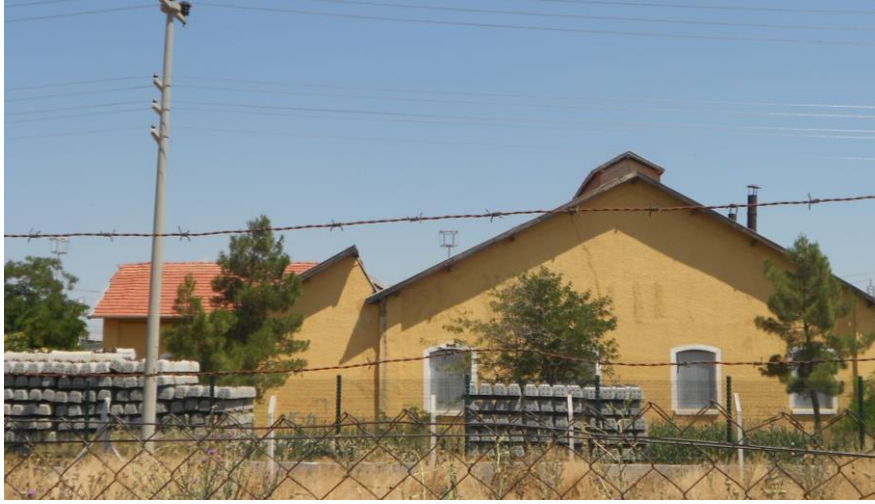
Şekil 4.117. Lokomotif Deposu Güney Cephesi
