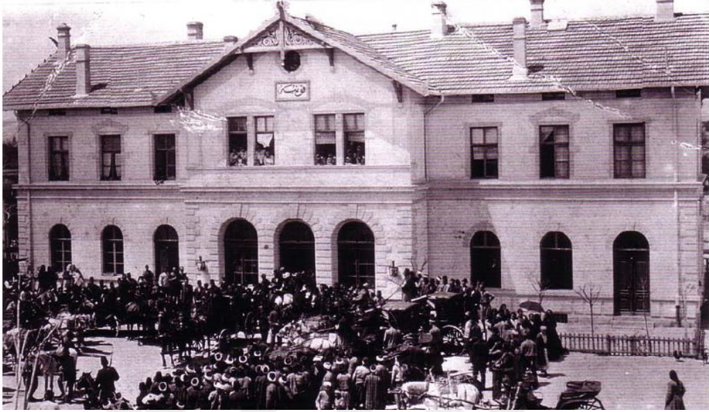
Şekil 3.15. Eski Konya Garı Giriş Cephesi 1994 (M.Yavuz,2005)
