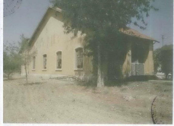
Şekil 4.111. Lokomotif Deposu Güney Cephesi (Konya Koruma Kurulu Arşiv 2019)
