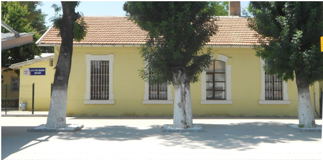
Şekil 4.97. Lojman Kuzey Cephesi
