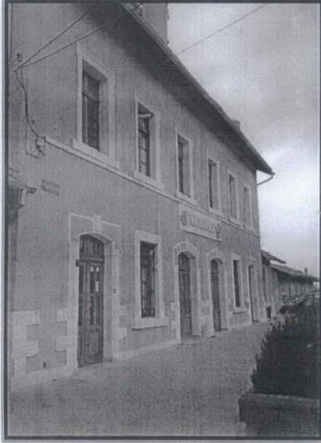
Foto.1. Karaman Gar Binası
