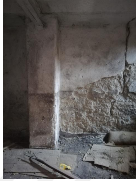
Şekil 4.58. Lojman Bodrum Duvarları
