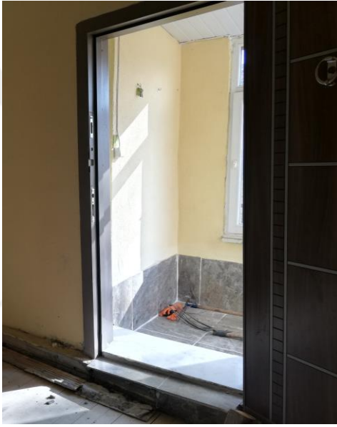
Şekil 4.134. Lojman Güney Kapısı
