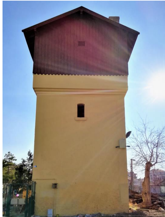
Şekil 4.87. Su Deposu Kuzey Cephesi
