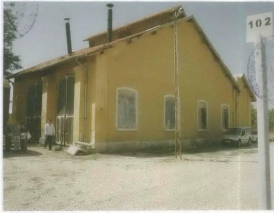
Şekil 4.110. Lokomotif Deposu Kuzey Cephesi (Konya Koruma Kurulu Arşiv 2019)
