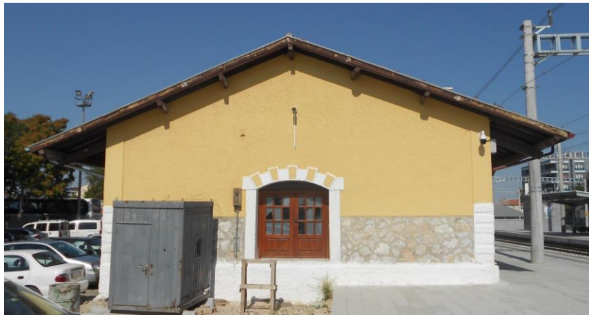
Şekil 4.54. Ambar Binası Doğu Cephesi (TCDD arşiv)
