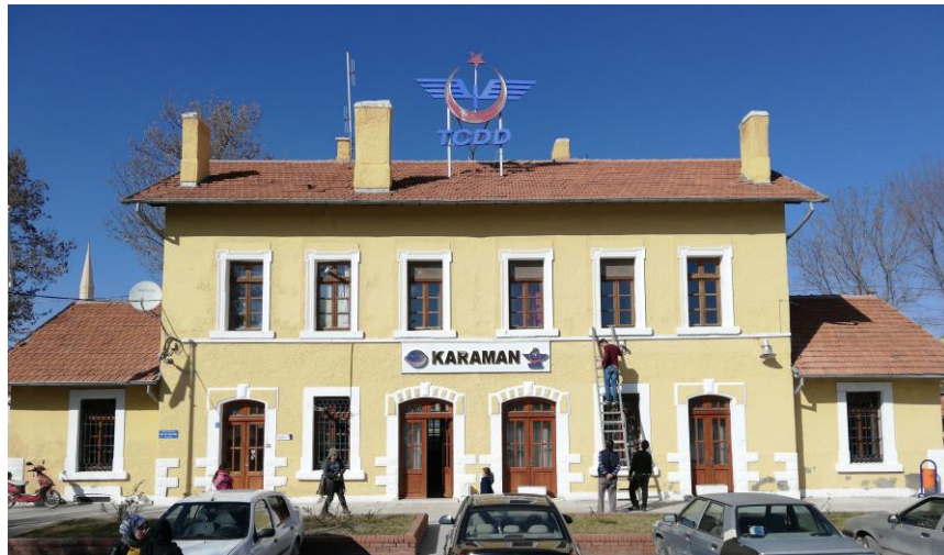
Şekil 4.28. Karaman Gar Binası Güney Cephesi
