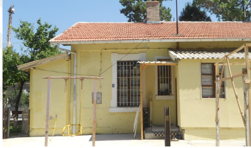
Şekil 4.93. Lojman Güney Cephesi Giriş Kapısı
