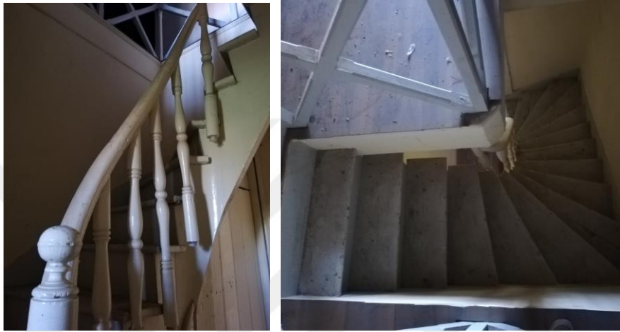
Şekil 4.60. Lojman Çatı Arası Merdiven
