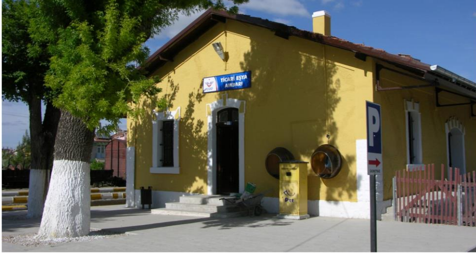
Şekil 4.45. Ambar Binası Batı Cephesi (TCDD arşiv)
