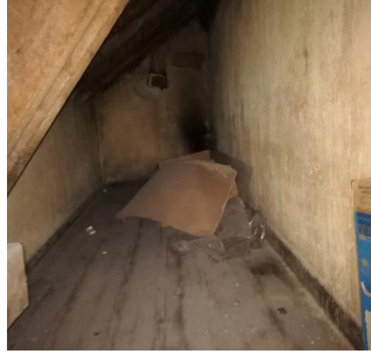
Şekil 4.24. Gar Binası Çatı Arası
