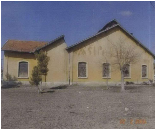
Şekil 4.112. Lokomotif Deposu Güney Cephesi (Konya Koruma Kurulu Arşiv 2019)
