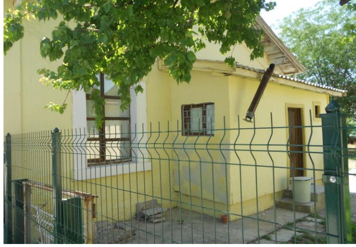
Şekil 4.95. Lojman Batı Cephesi Giriş Kapısı
