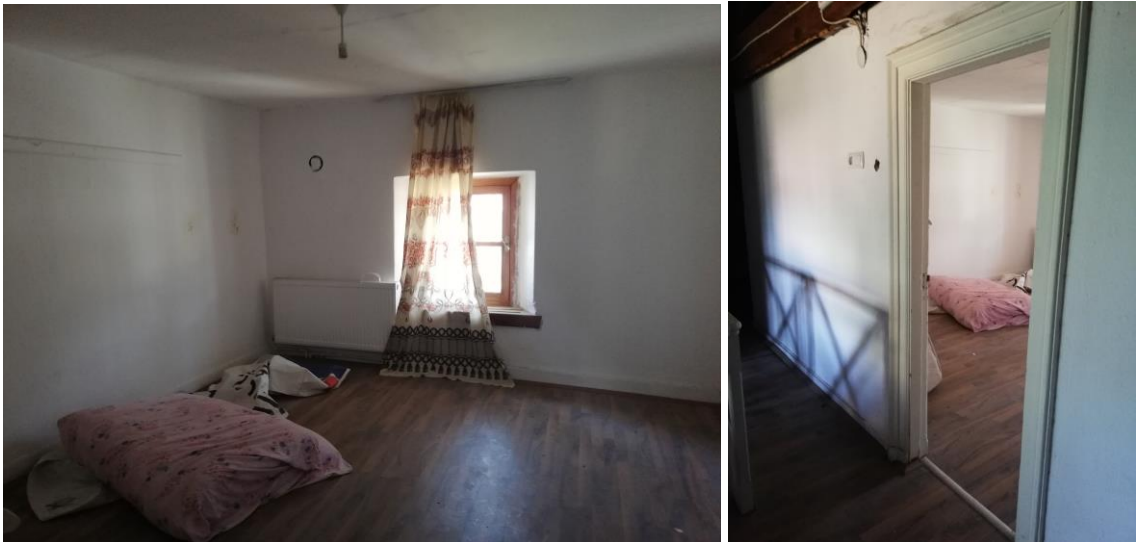
Şekil 4.62. Lojman Çatı Arası Mekân
