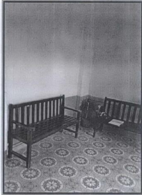
Foto.4. Bakım Yapılacak Duvarlar
