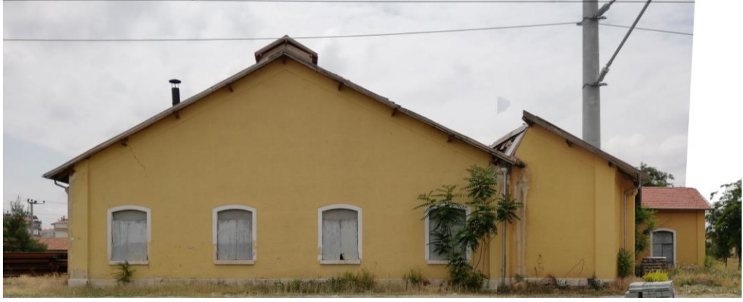
Şekil 4.115.Lokomotif Deposu Kuzey Cephesi
