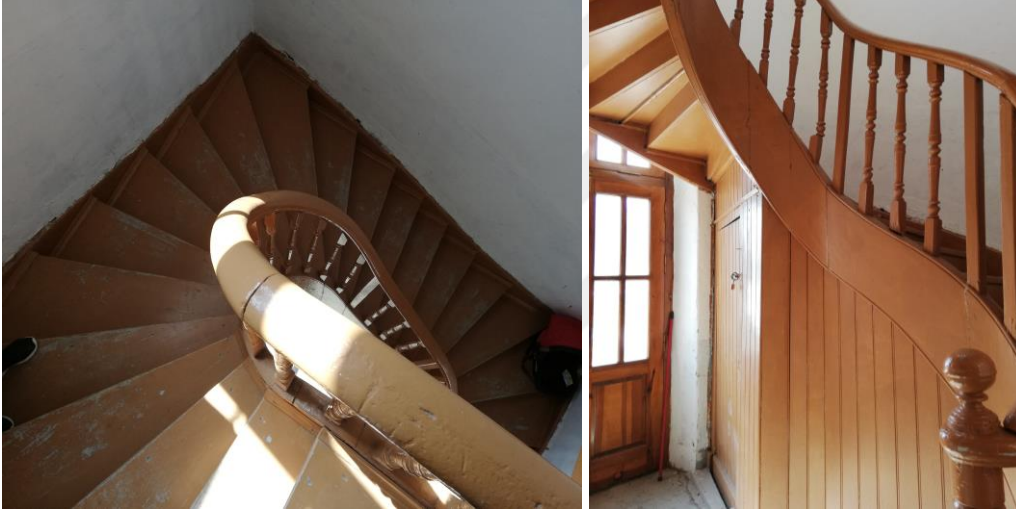
Şekil 4.13. Karaman Gar Binası Lojman Merdiveni
