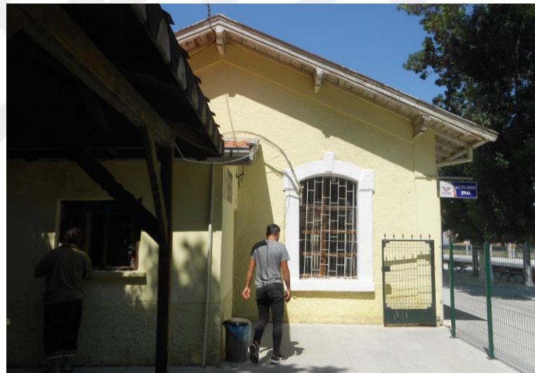
Şekil 4.99. Lojman Doğu Cephesi (İdari Kısım) Giriş Kapısı
