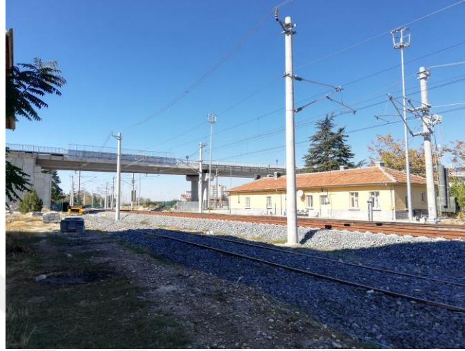
Şekil 4.145. Amele Barakası Güney Cephesi
