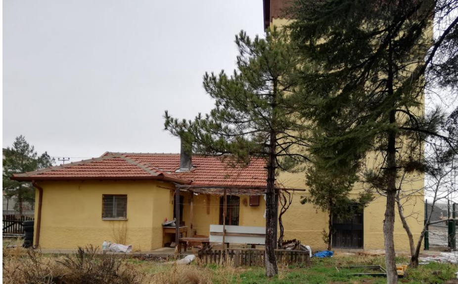
Şekil 4.85. Su Deposu Doğu Cephesi
