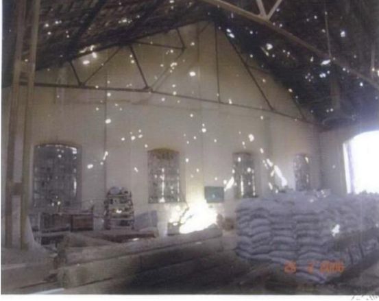
Şekil 4.108. Lokomotif Deposu İç Kısmı (Konya Koruma Kurulu Arşiv 2019)
