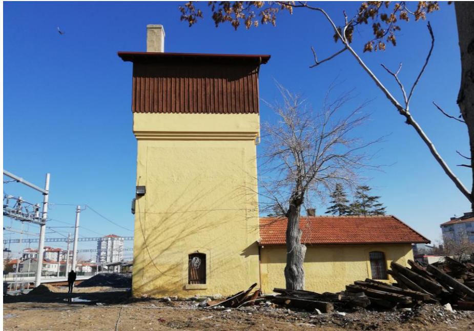
Şekil 4.81. Su Deposu Batı Cephesi
