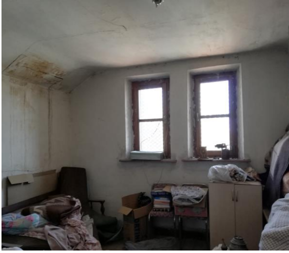
Şekil 4.23. Gar Binası Çatı Arası Oda Penceresi
