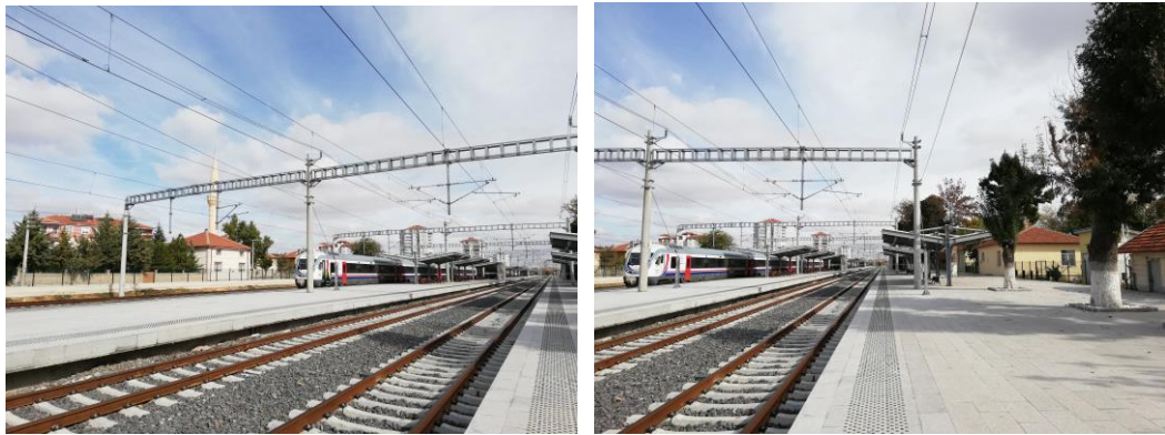
Şekil 4.5. 5 no'lu Resim Karaman Garı Tren Hattı Doğu Tarafı ve İstasyon Camii
