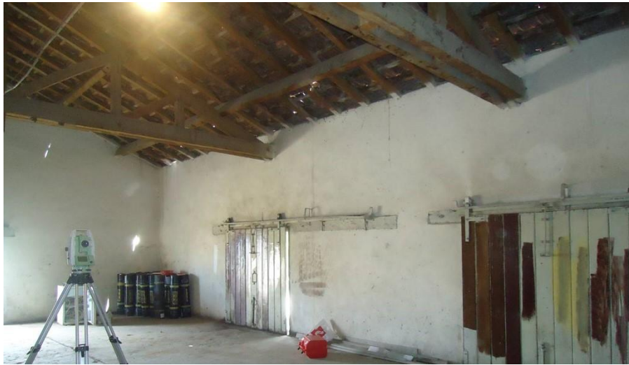
Şekil 4.42. Ambar Binasi Restorasyon Öncesi İç Mekân (TCDD arşiv)
