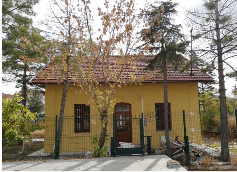
Şekil 4.71 Lojman Kuzey Cephesi (2019)
