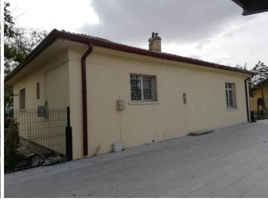
Şekil 4.140. Lojman Kuzey Cephesi
