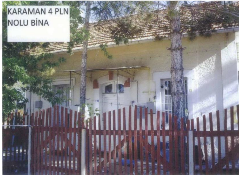
Şekil 4.65. Lojman Kuzey Cephesi (Konya Vakıflar Bölge Müdürlüğü Arşiv)
