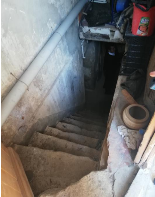
Şekil 4.25. Gar Binası Bodrum Merdiveni
