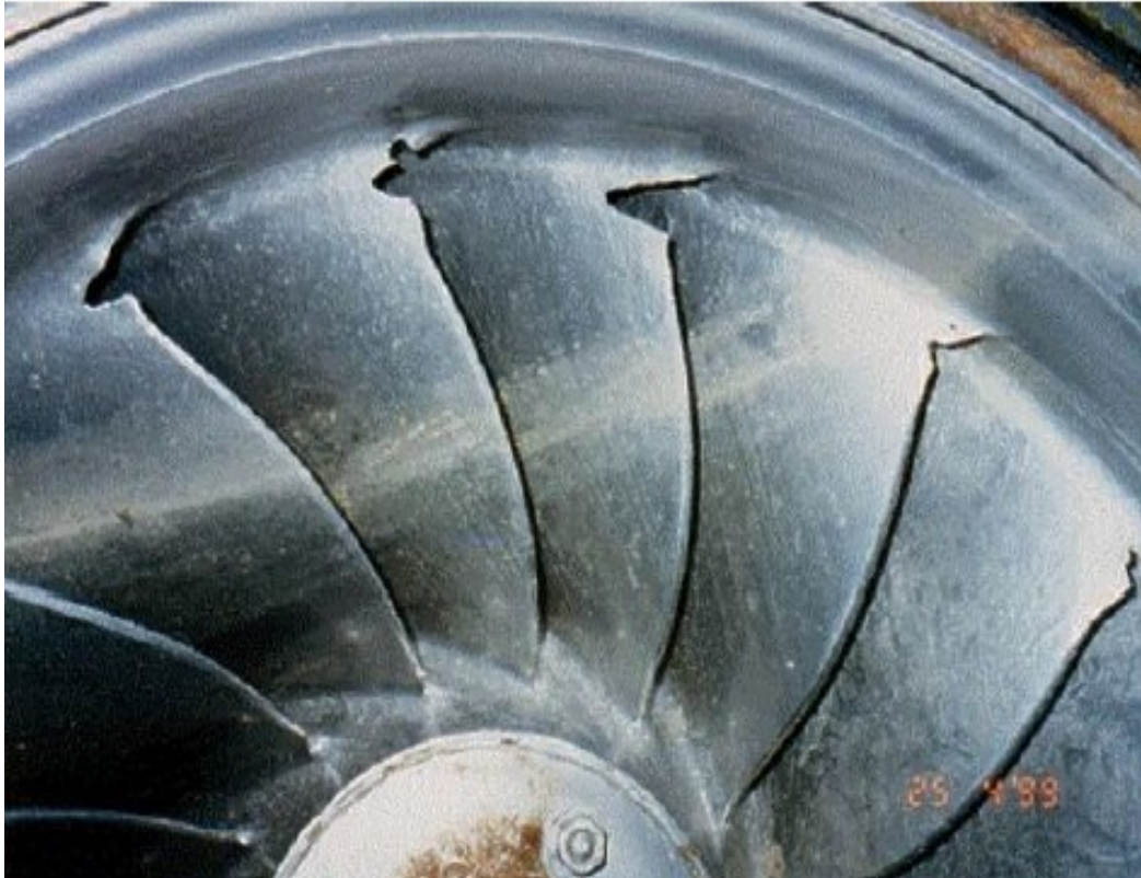
Şekil 3.6. Jhimruk hidroelekrik santrali türbin aşınması (Randle ve ark, 2017)
