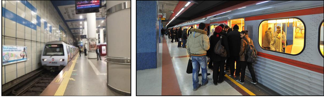
Resim 4. Metro Hattı ve İstasyonu/ Ankara ve İstanbul Metro İstasyonu (URL4).
