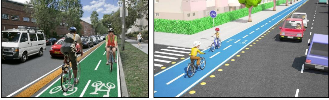
Resim 8. Ayırıcısız Bisiklet Yol Tasarımı, Tek Tarafta Çift Şeritli (URL7).
