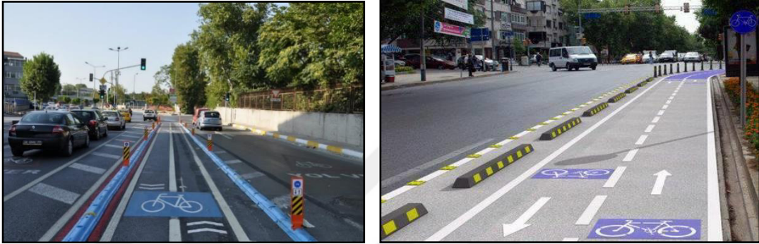
Resim 9. Refüj Olarak Kullanılan Çift Şeritli Levhalı Koruma Bandı, İstanbul.
