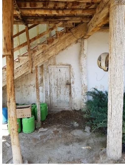
Şekil 3.72. Ahşap depo kapısı ve merdivenler (E.AKMAN Arşivi, 2018)
