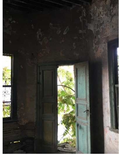
Şekil 3.104. Kuzeydoğudaki balkon kapısı (E.AKMAN Arşivi, 2018)
