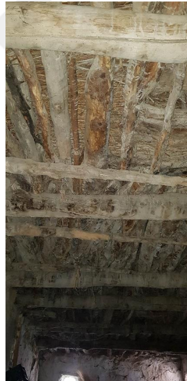
Şekil 3.288. Ahşap kirişli tavan detayı (E.AKMAN Arşivi, 2018)
