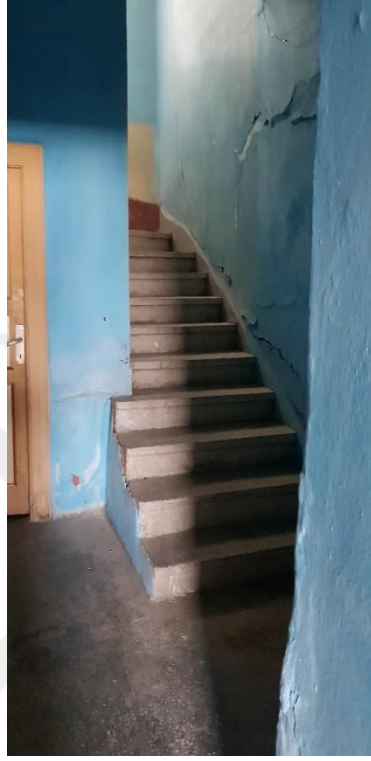
Şekil 3.143. Beton mozaik merdivenler (E.AKMAN Arşivi, 2018)
