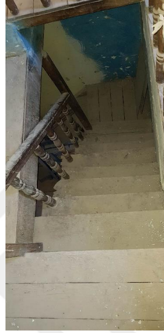
Şekil 3.188. Merdivenin üst kattan görünüşü (E.AKMAN Arşivi, 2018)
