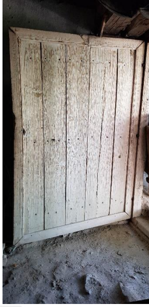
Şekil 3.232. Ahır kapısı (dıştan) (E.AKMAN Arşivi, 2018)
