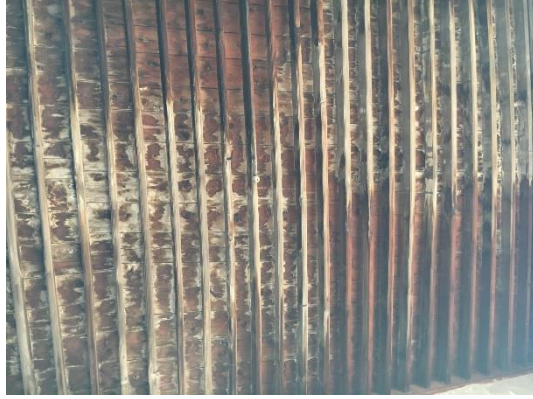
Şekil 3.100. Tavan döşemesi (E.AKMAN Arşivi, 2018)
