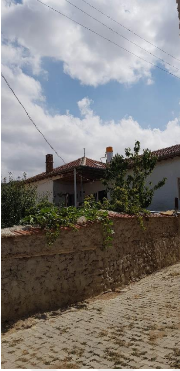
Şekil 3.280. Kuzey cephesi (E.AKMAN Arşivi, 2018)
