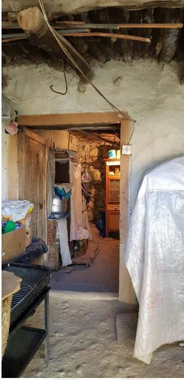
Şekil 3.215. Ahşap depo kapısı (E.AKMAN Arşivi, 2018)
