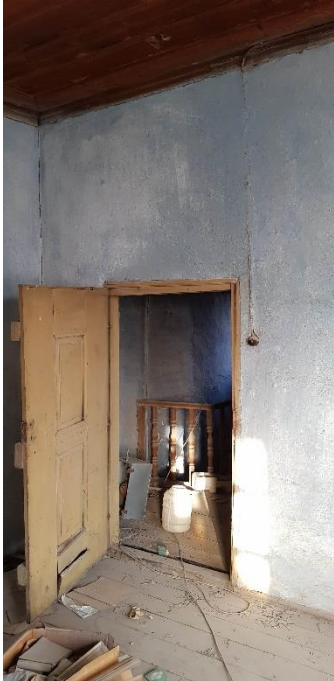
Şekil 3.174. Odanın ahşap kapısı (E.AKMAN Arşivi, 2018)
