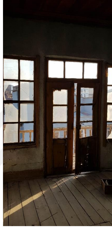
Şekil 3.177. Balkon kapısı ve pencereleri (E.AKMAN Arşivi, 2018)
