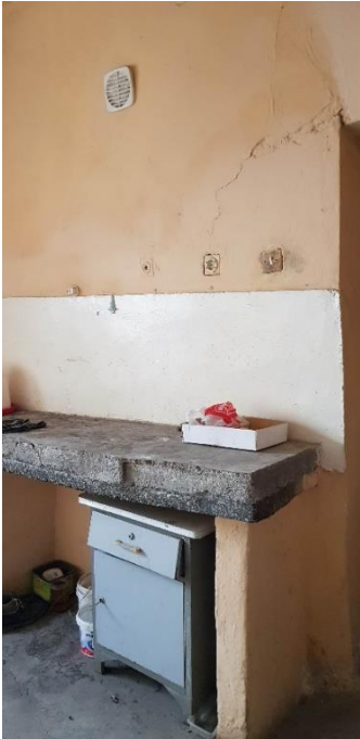
Şekil 3.141. Beton mutfak tezgâhı (E.AKMAN Arşivi, 2018)
