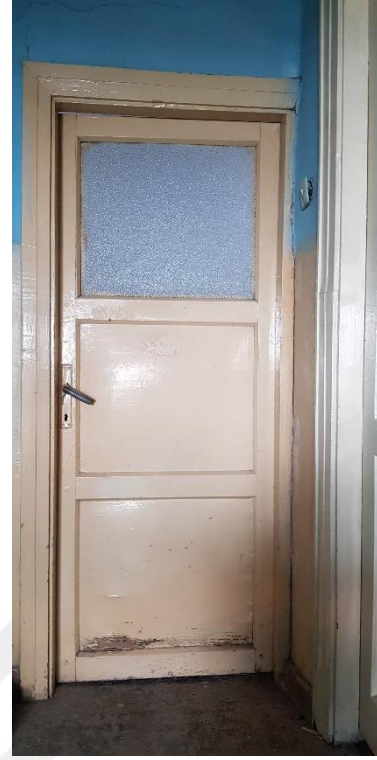
Şekil 3.146. Tuvaletin ahşap kapısı (E.AKMAN Arşivi, 2018)
