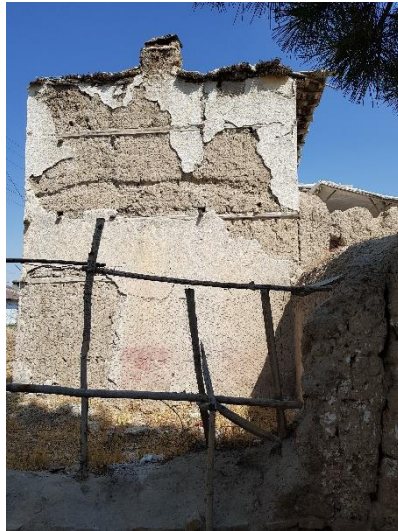
Şekil 3.75. Cumbanın ahşap iskeleti (E.AKMAN Arşivi, 2018)
