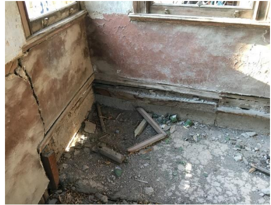
Şekil 3.99. Tahrip edilmiş seki detayı (E.AKMAN Arşivi, 2018)
