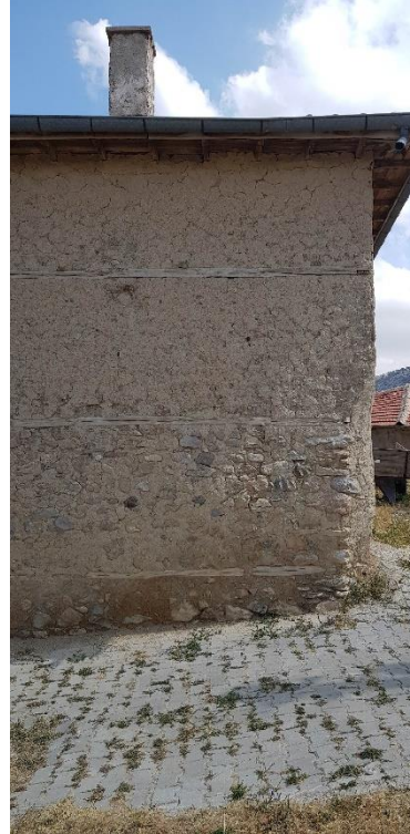
Şekil 3.279. Batı cephesi (E.AKMAN Arşivi, 2018)
