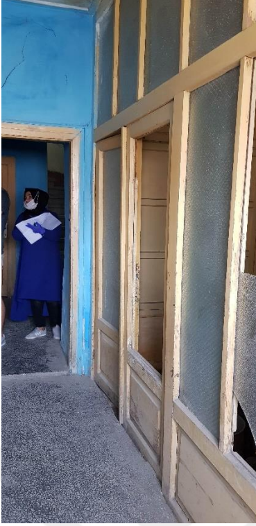
Şekil 3.123. Ahşap doğrama camekân (E.AKMAN Arşivi, 2018)
