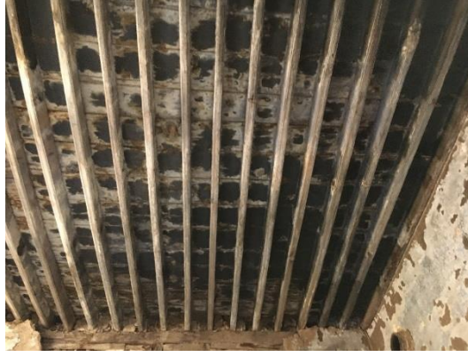
Şekil 3.107. Tavan döşemesi (E.AKMAN Arşivi, 2018)
