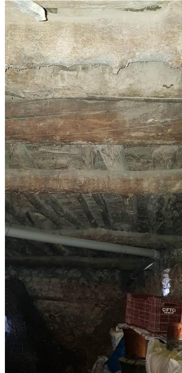
Şekil 3.220. Ahşap kirişli tavan detayı (E.AKMAN Arşivi, 2018)
