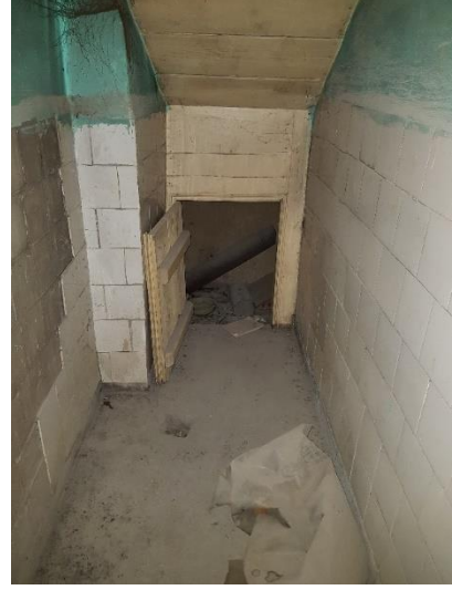
Şekil 3.21. Banyo iç mekân kömürlük (E.AKMAN Arşivi, 2018)
