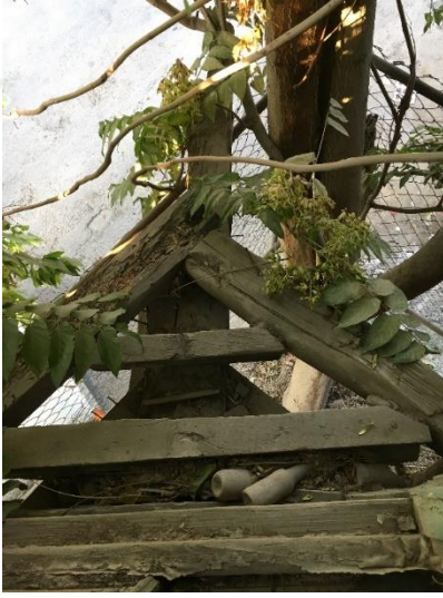
Şekil 3.105. Balkonun döşemesi (E.AKMAN Arşivi, 2018)
