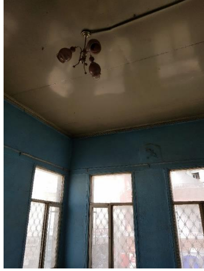
Şekil 3.31. Ahşap kaplama tavan (E.AKMAN Arşivi, 2018)
