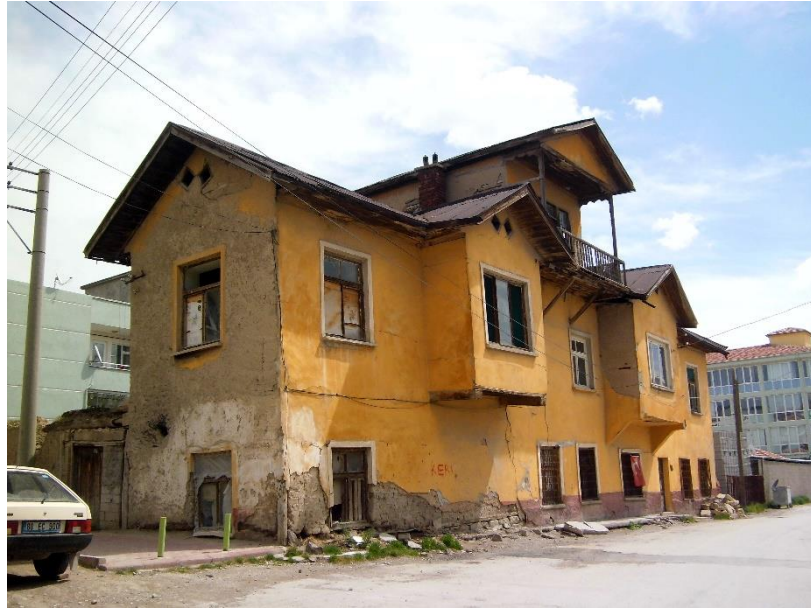
Şekil 3.201. Binanın kuzeybatı cephesi ve eski yapının sokak giriş kapısı (E.AKMAN Arşivi, 2016)
