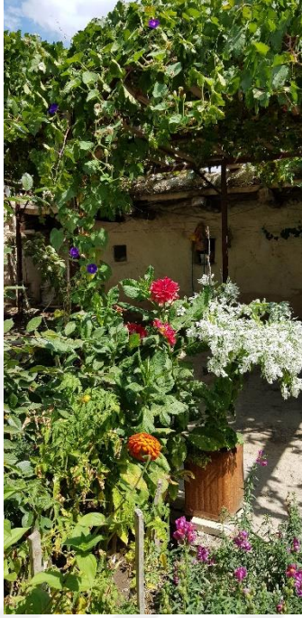
Şekil 3.213. Ahırın bahçeye bakan cephesi (E.AKMAN Arşivi, 2018)
