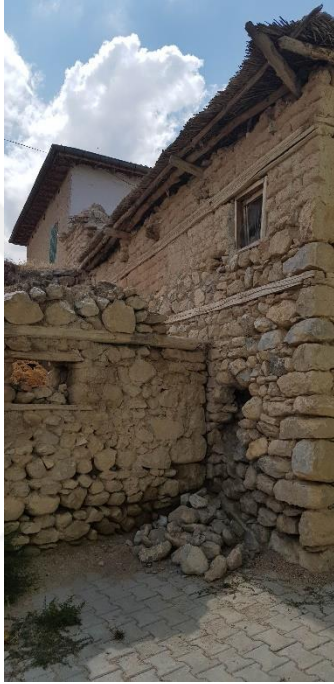
Şekil 3.207. M. Doğan Evi doğu cephe (E.AKMAN Arşivi, 2018)
