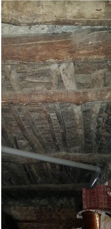
Şekil 3.219. Ahşap kirişli tavan detayı (E.AKMAN Arşivi, 2018)
