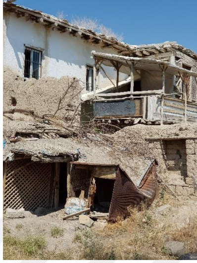
Şekil 3.74. Çatı saçağı ve toprak dam (E.AKMAN Arşivi, 2018)
