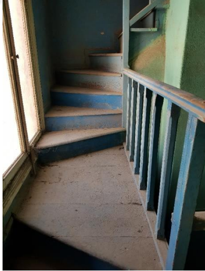
Şekil 3.32. Çatıya çıkan merdiven (E.AKMAN Arşivi, 2018)
