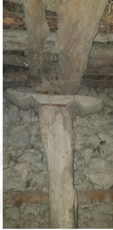
Şekil 3.231. Dikmenin ahşap başlığı (2018)
