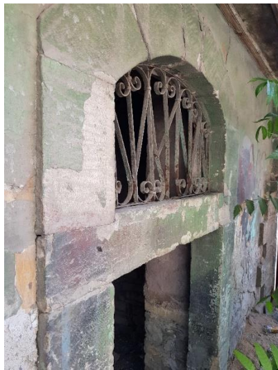
Şekil 3.84. Zemin kat girişi sağ kapı (E.AKMAN Arşivi, 2018)
