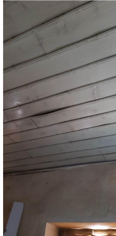
Şekil 3.126. Ahşap kaplama tavan (E.AKMAN Arşivi, 2018)
