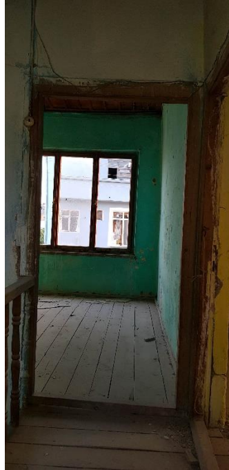
Şekil 3.192. Güneybatıdaki odanın kapı boşluğu (E.AKMAN Arşivi, 2018)
