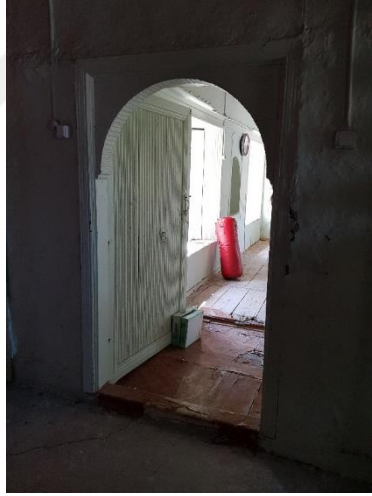
Şekil 3.66. Selamlık ahşap kemerli kapı girişi (E.AKMAN Arşivi, 2018)
