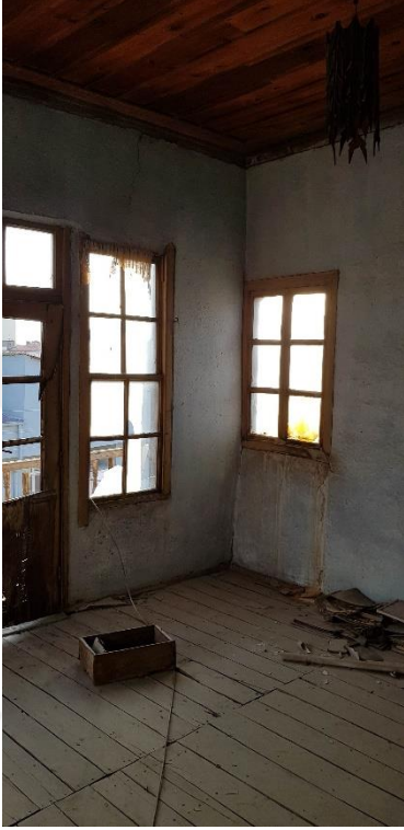
Şekil 3.176. Kuzeybatı cephesi penceresi (E.AKMAN Arşivi, 2018)
