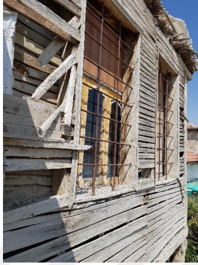
Şekil 3.76. Cumbanın ahşap çıtaları (E.AKMAN Arşivi, 2018)
