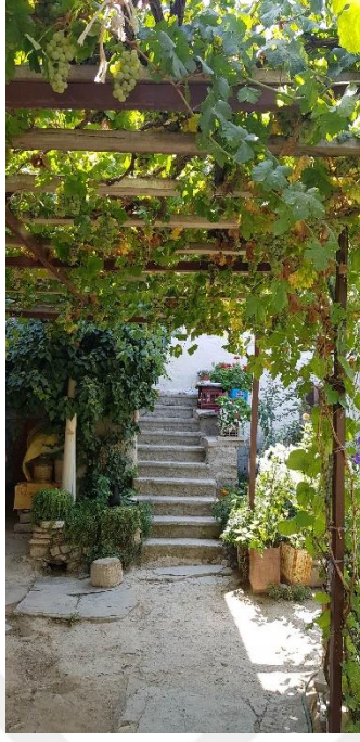
Şekil 3.241. Üst kata çıkılan beton merdivenler (E.AKMAN Arşivi, 2018)
