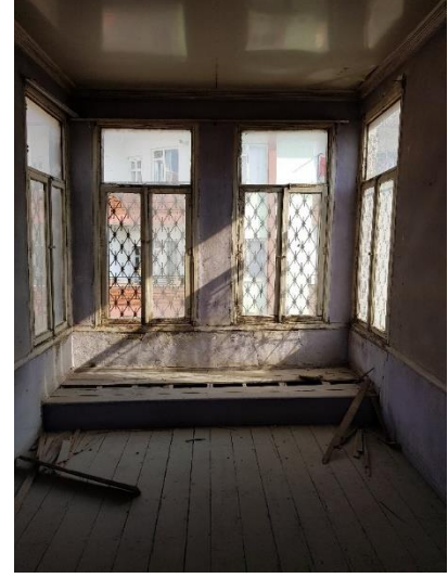
Şekil 3.35. Çatı arasındaki mekân (E.AKMAN Arşivi, 2018)
