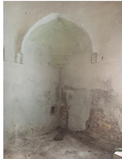
Şekil 3.8. Tarihi kalıntı köşe trompu (E.AKMAN Arşivi, 2018)
