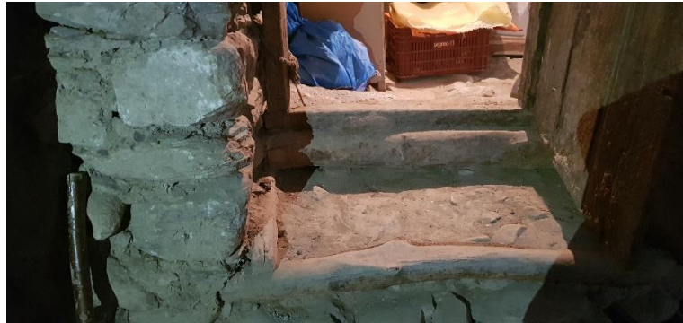
Şekil 3.223. Oda kapısı eşik detayı (E.AKMAN Arşivi, 2018)
