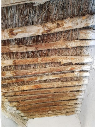
Şekil 3.78. Tavan döşemesi ahşap kirişler (E.AKMAN Arşivi, 2018)
