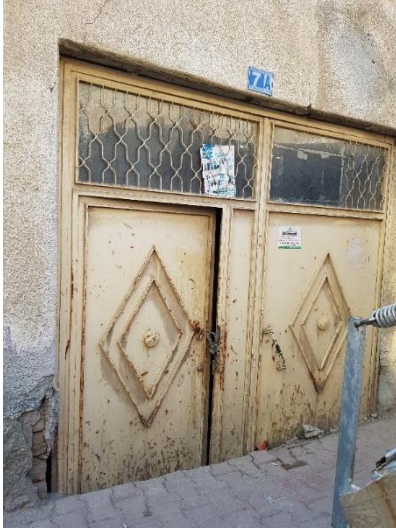
Şekil 3.5. Depo giriş kapısı yol cephesi (E.AKMAN Arşivi, 2018)
