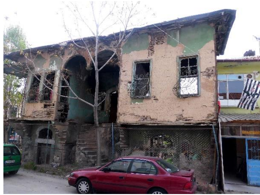
Şekil 3.112. Kuzey cephedeki ahşap kemerler (E.AKMAN Arşivi, 2016)
