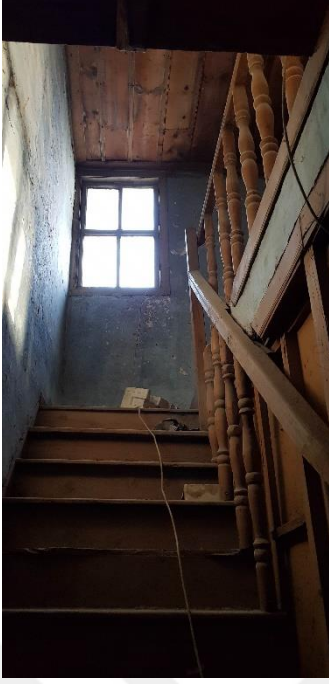
Şekil 3.172. Çatıya çıkan merdiven ve pencere (E.AKMAN Arşivi, 2018)
