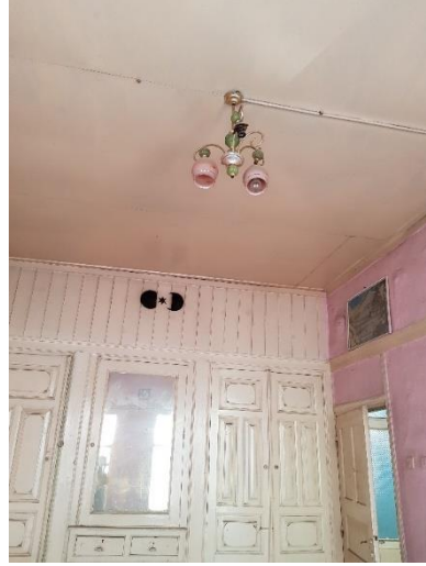
Şekil 3.28. Ahşap kaplama tavan (E.AKMAN Arşivi, 2018)
