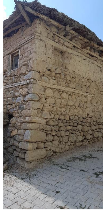
Şekil 3.208. M. Doğan Evi kuzey cephesi (E.AKMAN Arşivi, 2018)
