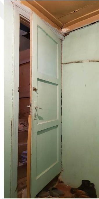
Şekil 3.156. Çatıya çıkan merdiven kapısı (E.AKMAN Arşivi, 2018)
