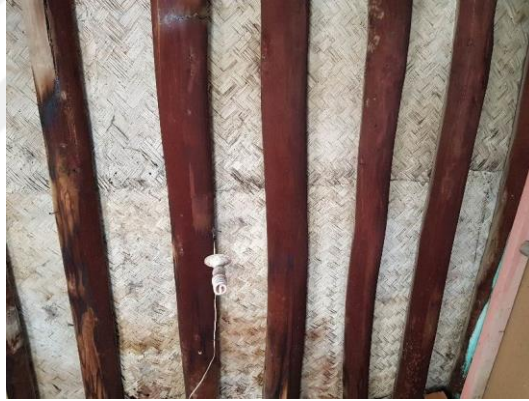
Şekil 3.56. Sofanın ahşap kiriş üzeri hasır kaplama tavanı (E.AKMAN Arşivi, 2018)
