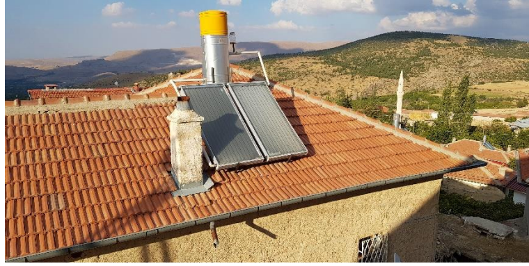
Şekil 3.286. Çatı güney görünüşü (E.AKMAN Arşivi, 2018)
