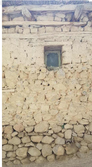
Őekil 4.5. M. Dođan Evi tař duvar ve ahřap hatıllı (E.AKMAN Arřivi, 2018)
