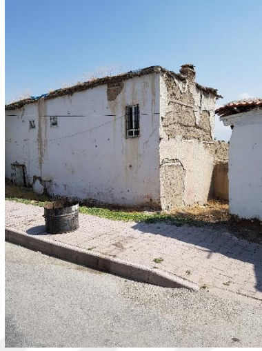
Şekil 3.73. Kuzey cephe (E.AKMAN Arşivi, 2018)
