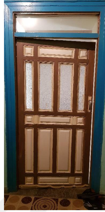
Şekil 3.154. Mutfak kapısı (E.AKMAN Arşivi, 2018)
