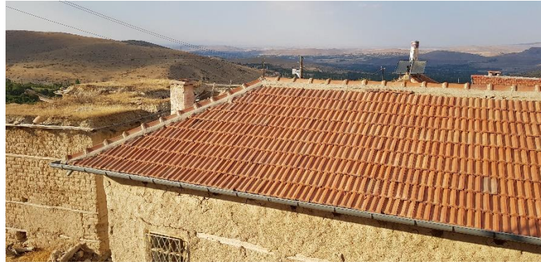
Şekil 3.285. Çatı güney görünüşü (E.AKMAN Arşivi, 2018)
