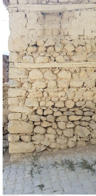
Şekil 3.210. Taş duvar ve ahşap hatıl detayları (E.AKMAN Arşivi, 2018)
