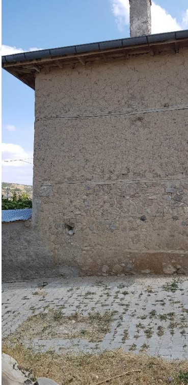
Şekil 3.278. Batı cephesi (E.AKMAN Arşivi, 2018)
