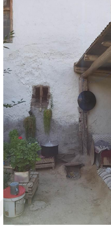
Şekil 3.216. Deponun bahçeye bakan cephesi (E.AKMAN Arşivi, 2018)
