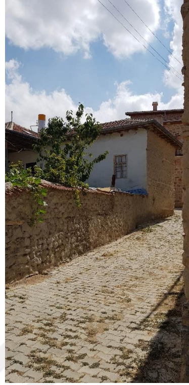
Şekil 3.281. Kuzey cephesi (E.AKMAN Arşivi, 2018)
