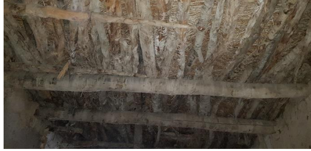
Şekil 4.6. M. Doğan Evi ahşap kirişler ve üzerindeki kamış örtü (E.AKMAN Arşivi, 2018)
