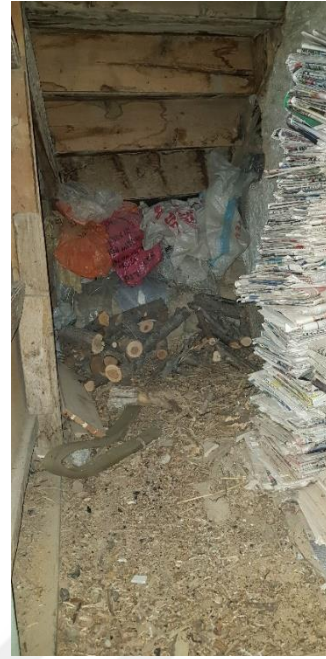
Şekil 3.164. Çatıya çıkan merdivenin altı (E.AKMAN Arşivi, 2018)
