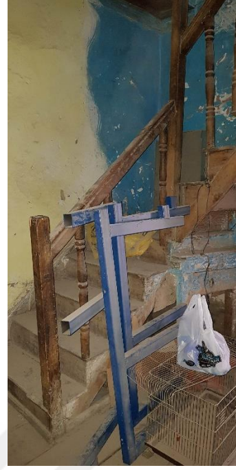
Şekil 3.181. Üst kata çıkan merdiven (E.AKMAN Arşivi, 2018)
