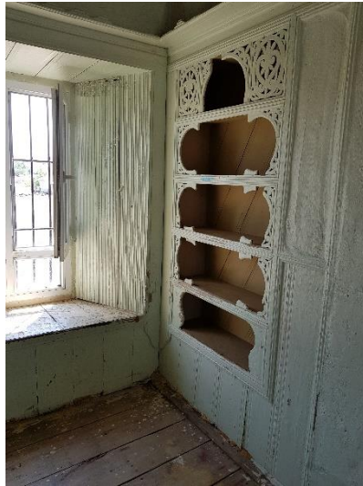
Şekil 3.77. Ahşap duvar kaplamaları, ağıztaçık ve zemin kaplaması (E.AKMAN Arşivi, 2018)
