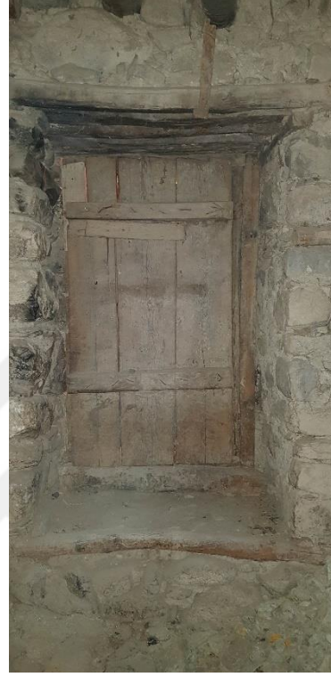
Şekil 3.222. Odanın ahşap kapısı (E.AKMAN Arşivi, 2018)
