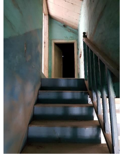
Şekil 3.33. Çatıya çıkan merdiven (E.AKMAN Arşivi, 2018)
