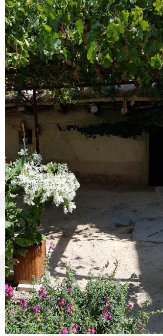
Şekil 3.214. Ahırın bahçeye bakan cephesi (E.AKMAN Arşivi, 2018)
