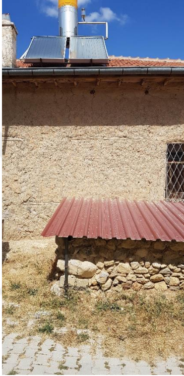
Şekil 3.289. Zemin kat güneydeki oda çatısı (E.AKMAN Arşivi, 2018)
