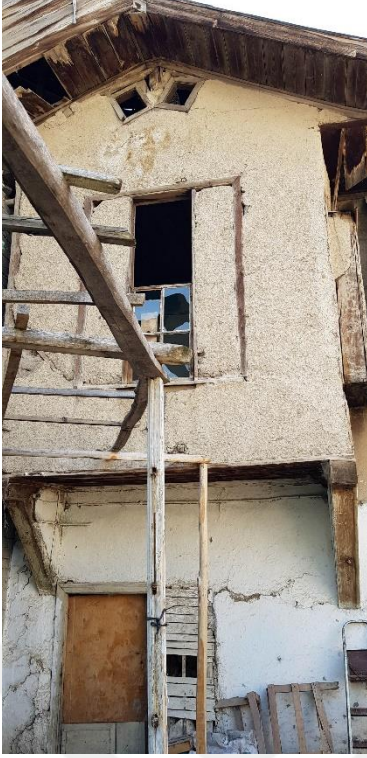
Şekil 3.204. Eski yapının cumbası (E.AKMAN Arşivi, 2018)
