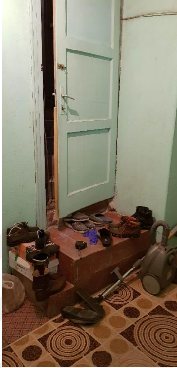
Şekil 3.162. Çatı katına çıkan merdiven kapısı (E.AKMAN Arşivi, 2018)
