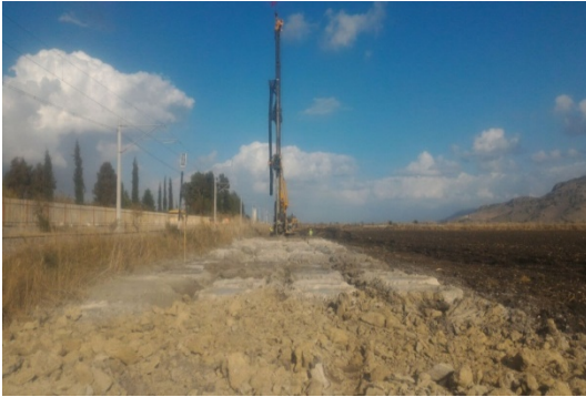
Şekil 5.22. AİT projesinde derin karıştırma uygulamasına ait çalışmadan bir resim
