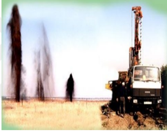
Şekil 4.6. Patlatma yerleştirme makinesi ve dren kuyularından fişkıran kum-su-hava karışımı (Çetin H.)
