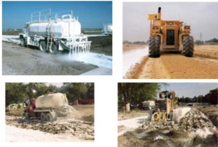
Şekil 4.4. Kireç ile stabilizasyon uygulaması (Bildik, 2017)
