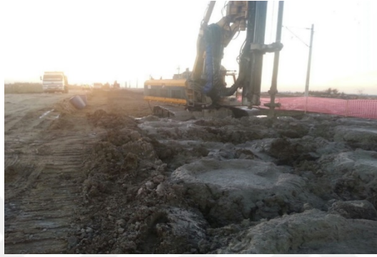
Şekil 5.24. AİT projesinde derin karıştırma uygulamasına ait çalışmadan bir resim
