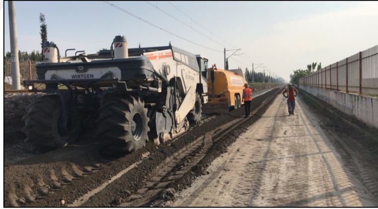
Şekil 5.7. Zemin stabilizatörü ile çimento ve kimyasal katkı karışımının su ile birlikte karıştırılması
