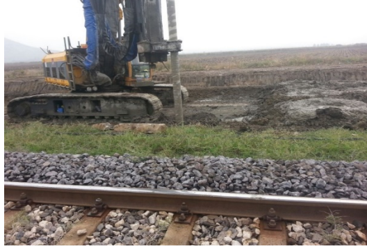
Şekil 5.23. AİT projesinde derin karıştırma uygulamasına ait çalışmadan bir resim
