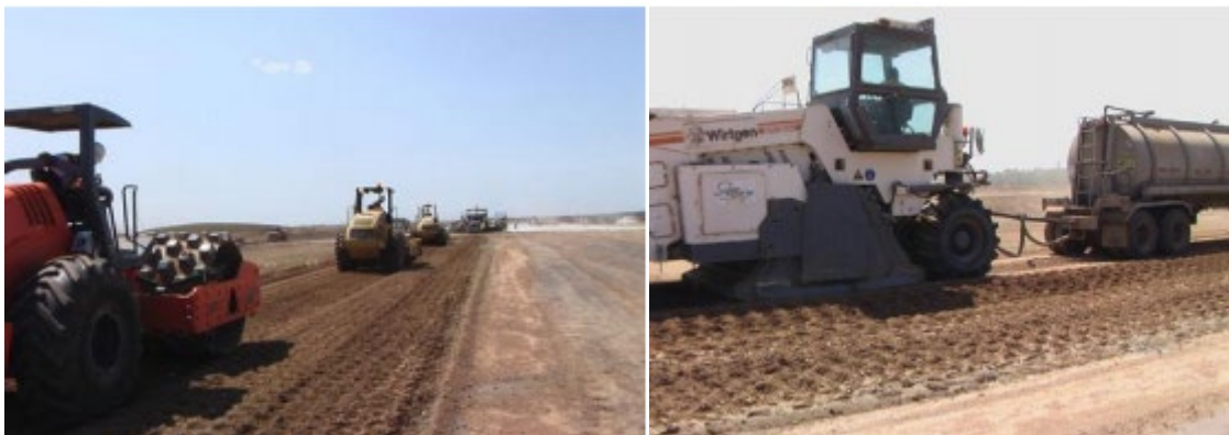
a) Zemin ile çimentonun su yardımı ile karıştırılması (Çimento oranı %6)
