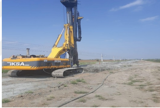
Şekil 5.21. AİT projesinde derin karıştırma uygulamasına ait çalışmadan bir resim
