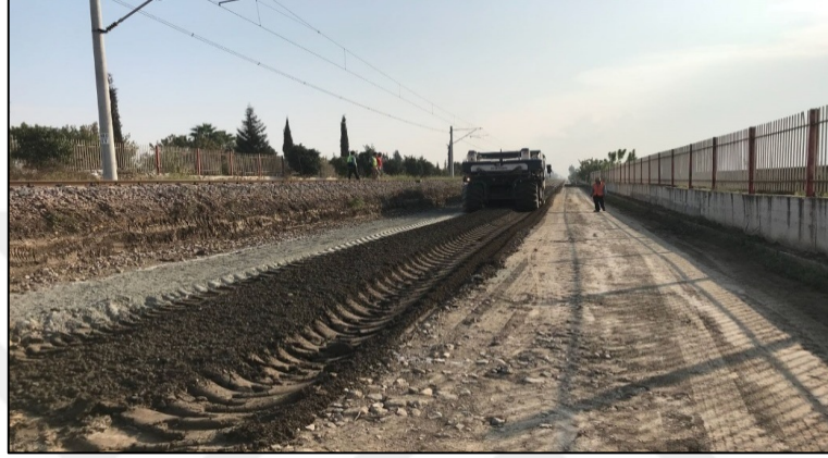
Şekil 5.6. Novocrete® ve çimentonun serilmesi
