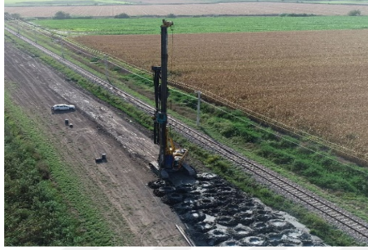
Şekil 5.20. AİT projesinde derin karıştırma uygulamasına ait çalışmadan bir resim
