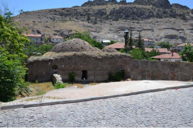
Şekil 4.97. Sille Subaşı Hamamının restorasyon öncesi kuzey görünüşü (Rölöve Raporu) (Turquoise Design Restoration Mimarlık, 2016b)
