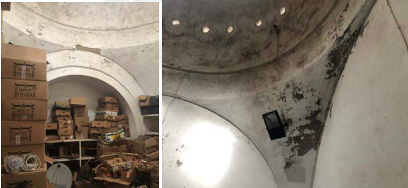
Şekil 4.80. Kadınlar soğukluk mekânındaki kemerli niş (Kişisel Arşiv). Şekil 4.81. Hamamın kadınlar soğukluk mekânındaki kubbeye geçişi sağlayan pandantif (Kişisel Arşiv).
