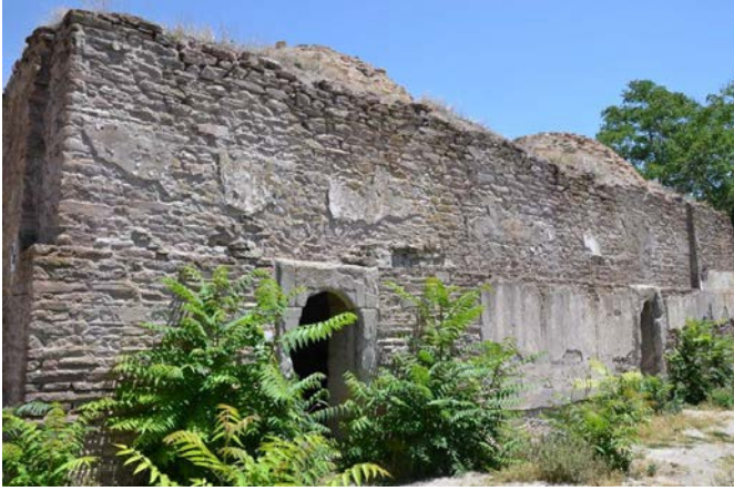
Şekil 4.105. Sille Subaşı Hamamı restorasyon öncesi Ilıklık mekanları batı giriş cephesi (Rölöve Raporu)(Turquoise Design Restoration Mimarlık, 2016b).
