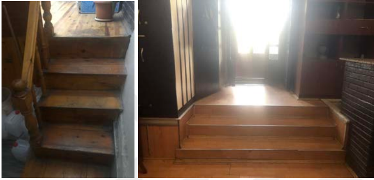
Şekil 4.47.-Şekil 4.48. Hasbeyoğlu Hamamı soyunmalık bölümlerine eklenen merdivenler (Kişisel Arşiv).
