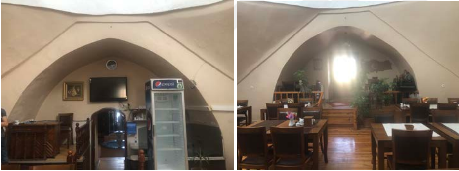
Şekil 4.27. Meram Hasbeyoğlu Hamamının kadınlar soyunmalık bölümü ile erkekler soyunmalık bölümünü bağlayan kemerli kapı açıklığı (Kişisel Arşiv).
