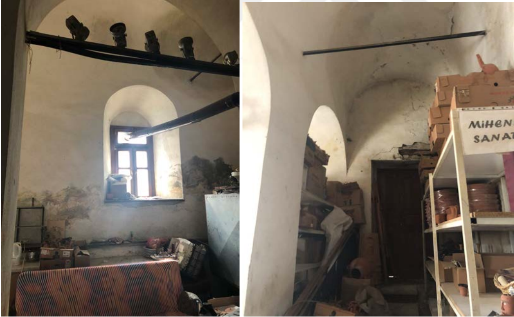
Şekil 4.76. Hamamın kadınlar soyunmalık mekânındaki pencerenin iç mekândan görünüşü (Kişisel Arşiv).
