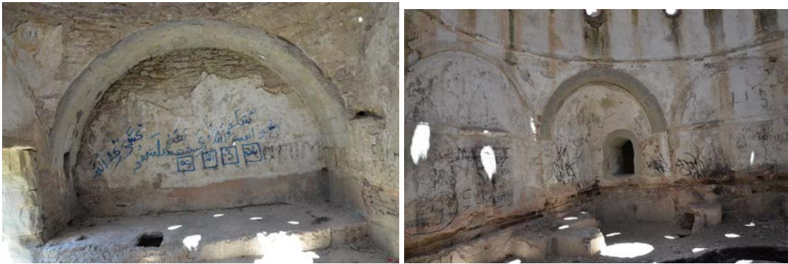
Şekil 4.98.-Şekil 4.99. Sille Subaşı Hamamının restorasyon öncesi sıcaklık bölümleri (Rölöve Raporu) (Turquoise Design Restoration Mimarlık, 2016b)
