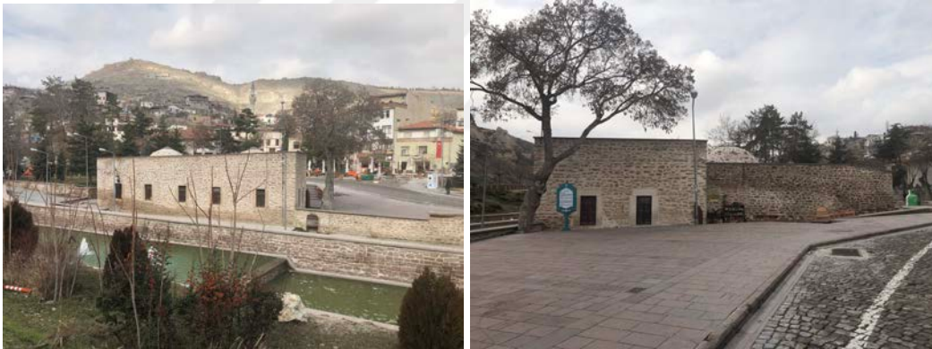
Şekil 4.87. Hacı Ali Ağa Hamamının güneydoğusundan hamamın güney cephesindeki erkekler soyunmalık mekânının pencereleri (Kişisel Arşiv).
