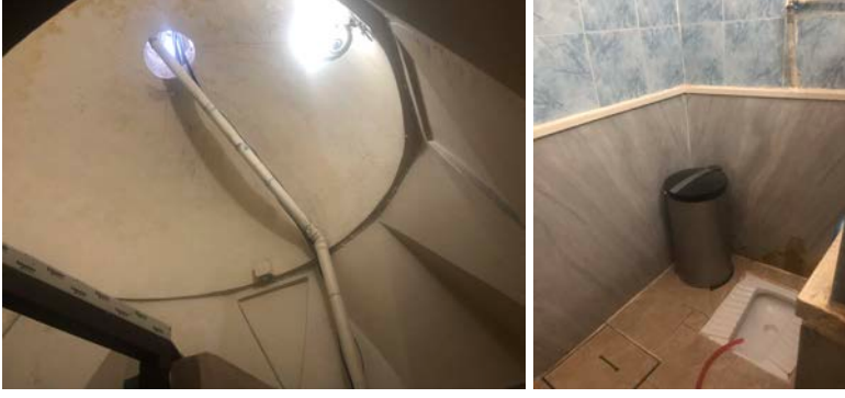
Şekil 4.29. Hasbeyoğlu Hamamı kadınlar bölümü aralık mekânı üst örtüsü olan kubbe (Kişisel Arşiv).
