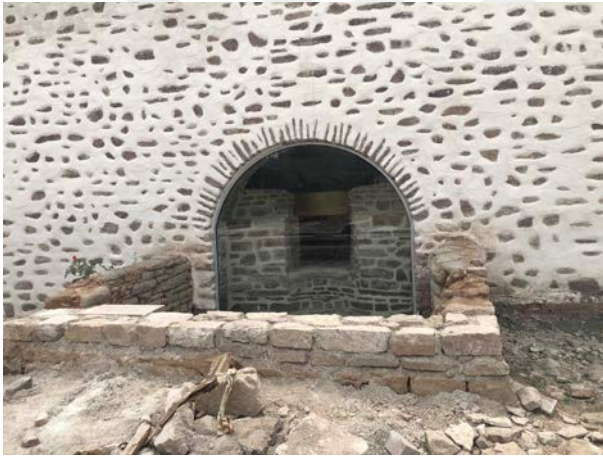
Şekil 4.119. Subaşı hamam su deposunu cam ile kapatılan bölümü (Kişisel Arşiv).
