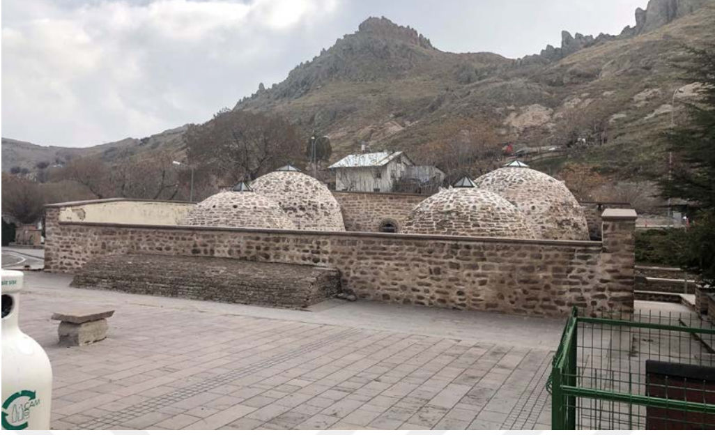
Şekil 4.94. Sille Hacı Ali Ağa Hamamı kuzeycephesi çevresi görünüşü (Kişisel Arşiv).
