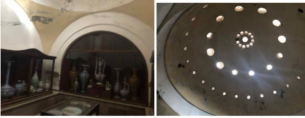
Şekil 4.78. Hamamda erkekler soğukluk bölümünde kapatılarak kullanılan kemerli çıkıntı (Kişisel Arşiv). Şekil 4.79. Hamam erkekler soğukluk mekânı kubbesi ve fil gözleri (Kişisel Arşiv).
