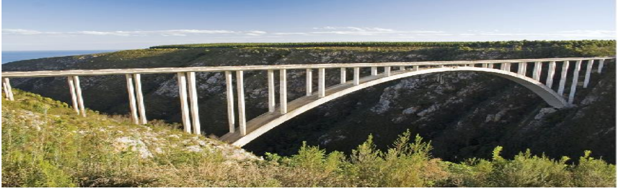
Şekil 3.4. Betonarme Köprü Örneği (Charles, 2015)
