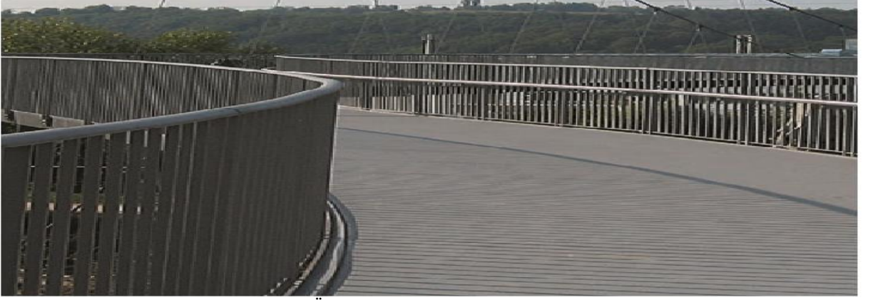
Şekil 3.26. Dar Aralıklı Çubuk Korkuluk Örneği (Keil,2013)
