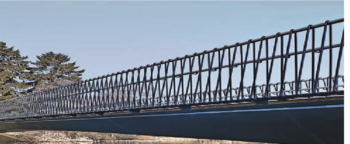
Şekil 3.28.Çelik Korkuluk Örneği (Keil,2013)
