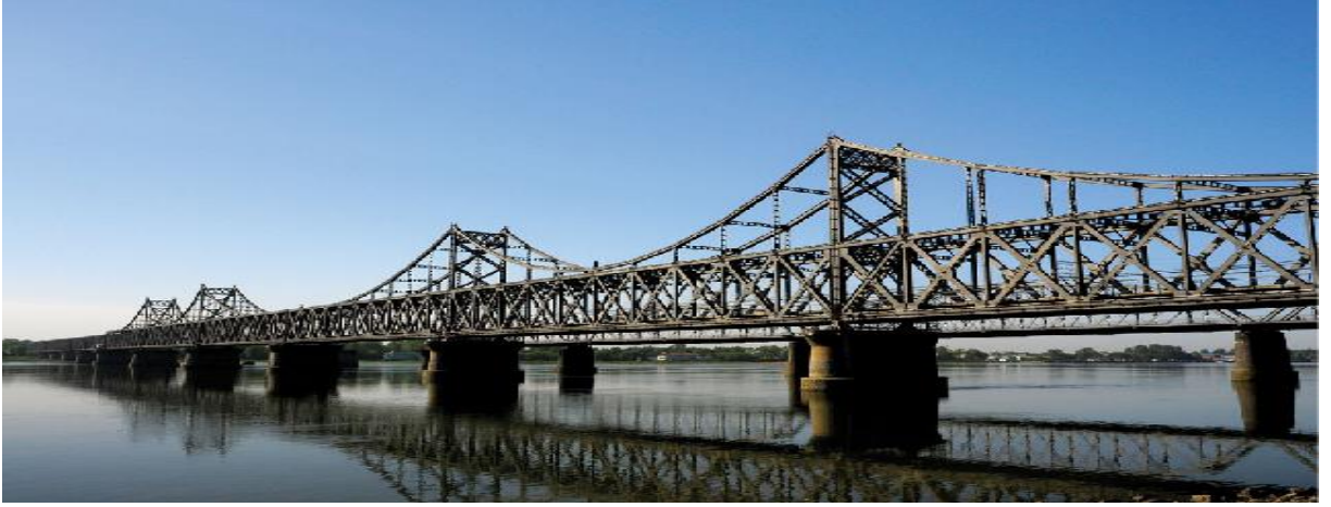
Şekil 3.5.Metal Köprü Örneği (Charles,2015)
