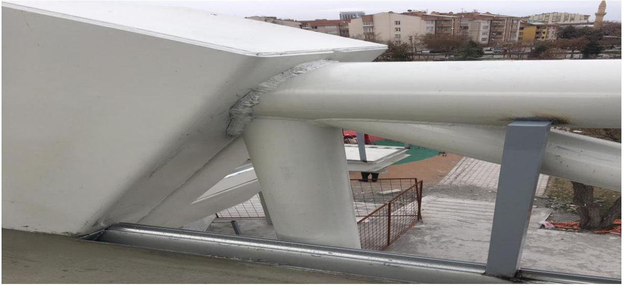
Şekil 3.7.Kolon kiriş kaynaklı birleşim (Selvi Arşivinden)
