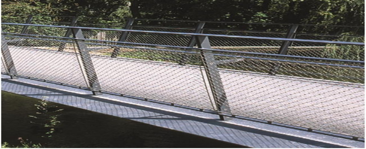
Şekil 3.29.Çelik Hasır Korkuluk (Keil,2013)
