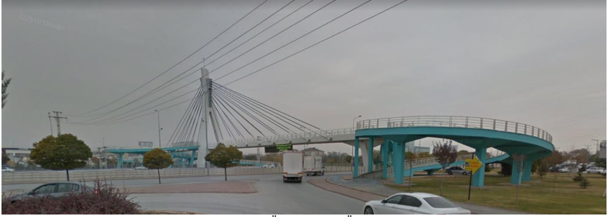
Şekil 4.63. Ankara Yolu Karatay Anadolu Lisesi Önü Rampalı Üst Geçidi (Google Maps)
