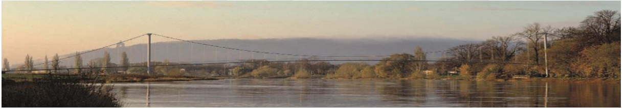
Şekil 3.16. Kendinden bağlantılı asma köprü, Glacis Köprüsü (Keil,2013)
