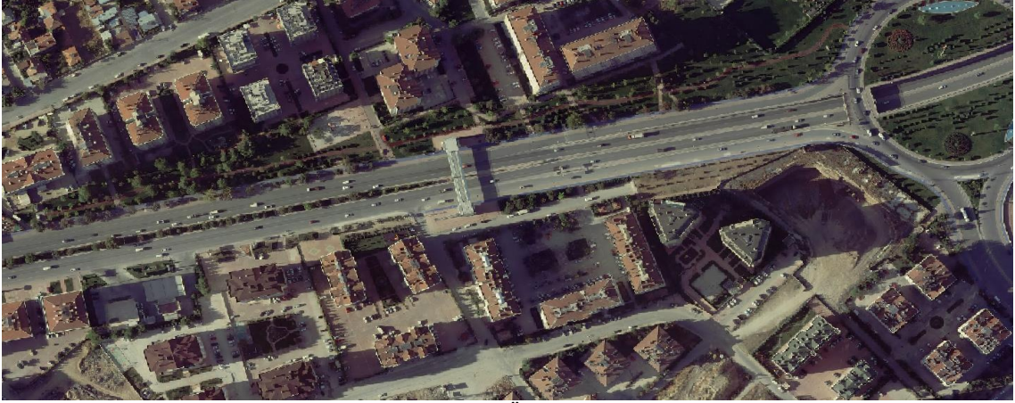
Şekil 4.54.Şehit Astsubay Mevlüt Pekdemir Yaya Üst Geçidi Çevre Bağlantısı (Konya Kent Rehberi, 2019)
