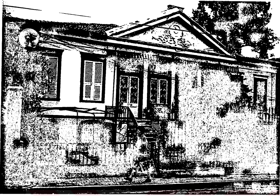
Resim-72: Simetrik cepheli üçgen alınlıklı yükseltilmiş bodrum katlı ev, Uğur Mumcu cad. no:25 iki ayrı konut olarak kullanılan mekanın giriş kapıları aynı üçgen alınlık altında toplanmıştır.
