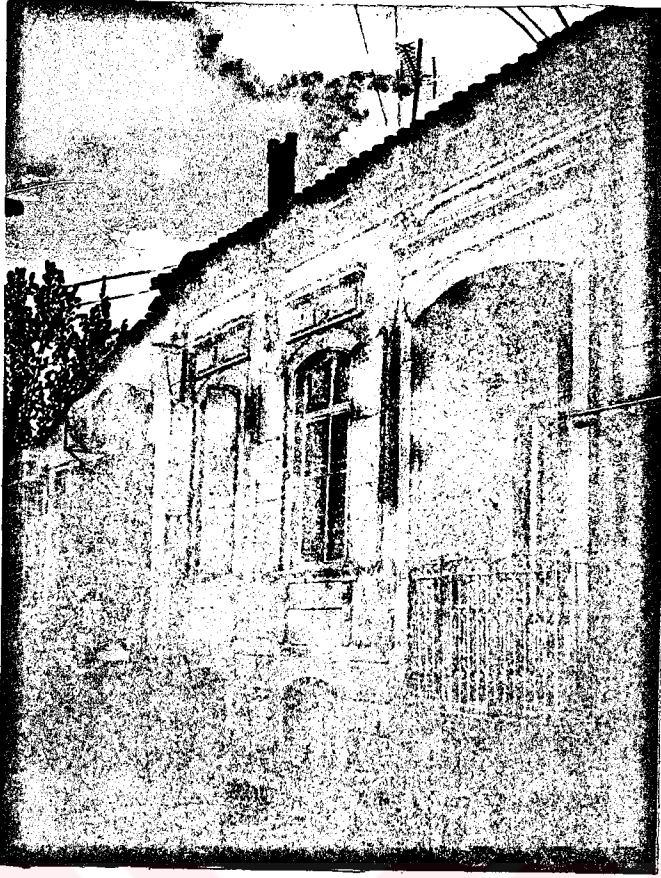
Resim-61: Asimetrik cephele yükseltilmiş bodrum katlı ev,
