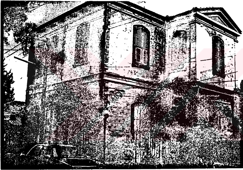
Resim-47: Simetrik cepheleli cumbalı iki katlı ev, 113 sok. no:4
