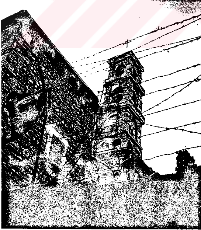
Resim-15: Katolik kilisesinin Çan kulesinden detay.
