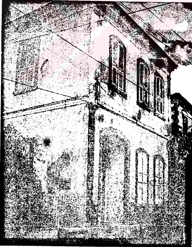
Resim-43: Asimetrik cepheli cumbasız iki katlı ev, 113 sok. no:13 Türünün genel özelliklerini taşıyan bu örnekte bakımsız bir durumdadır.
