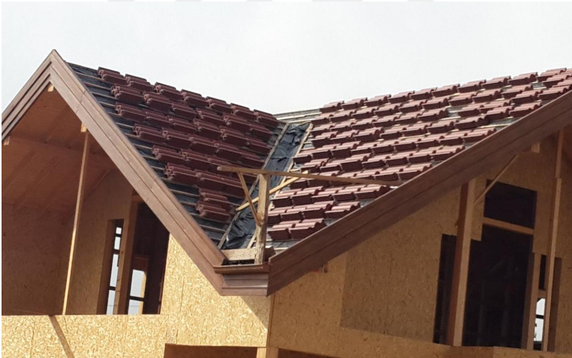
Şekil 3.19. Akyel Evi çatıya kiremit uygulaması (Koçkuzu, 2013)
