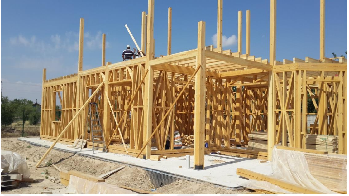
Şekil 3.10. Akyel Evi yapım aşaması (Koçkuzu, 2013)
