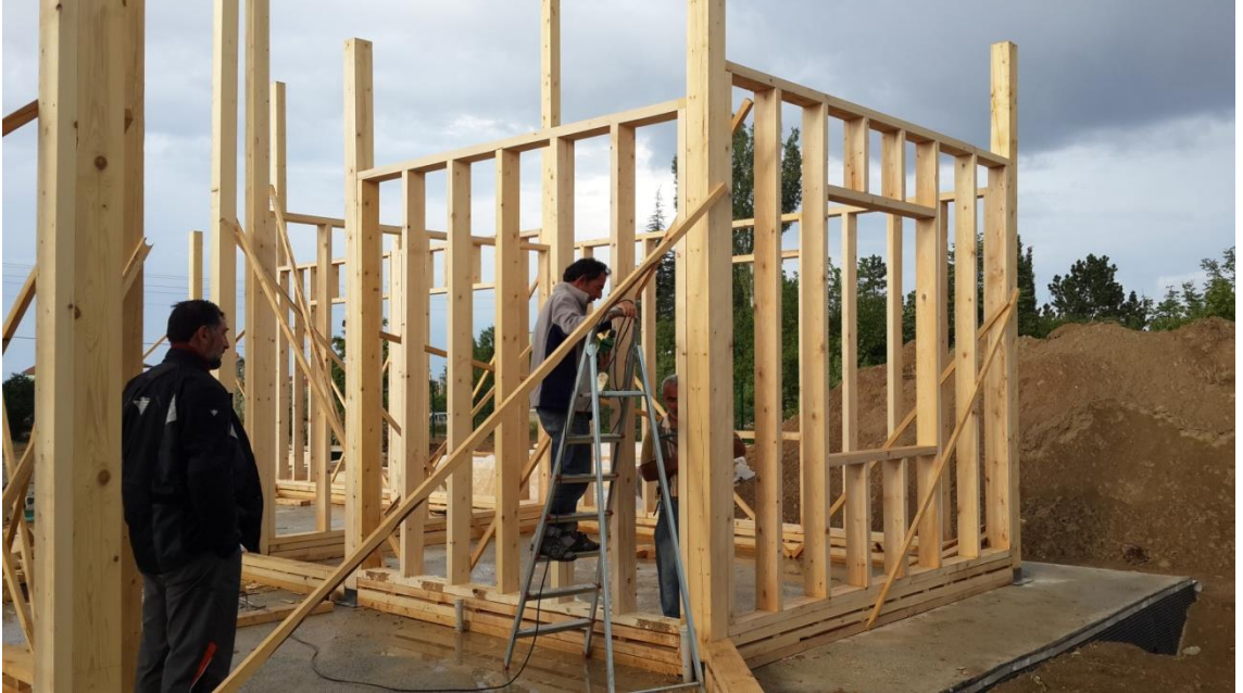
Şekil 3.11. Akyel Evi yapım aşaması (Koçkuzu, 2013)
