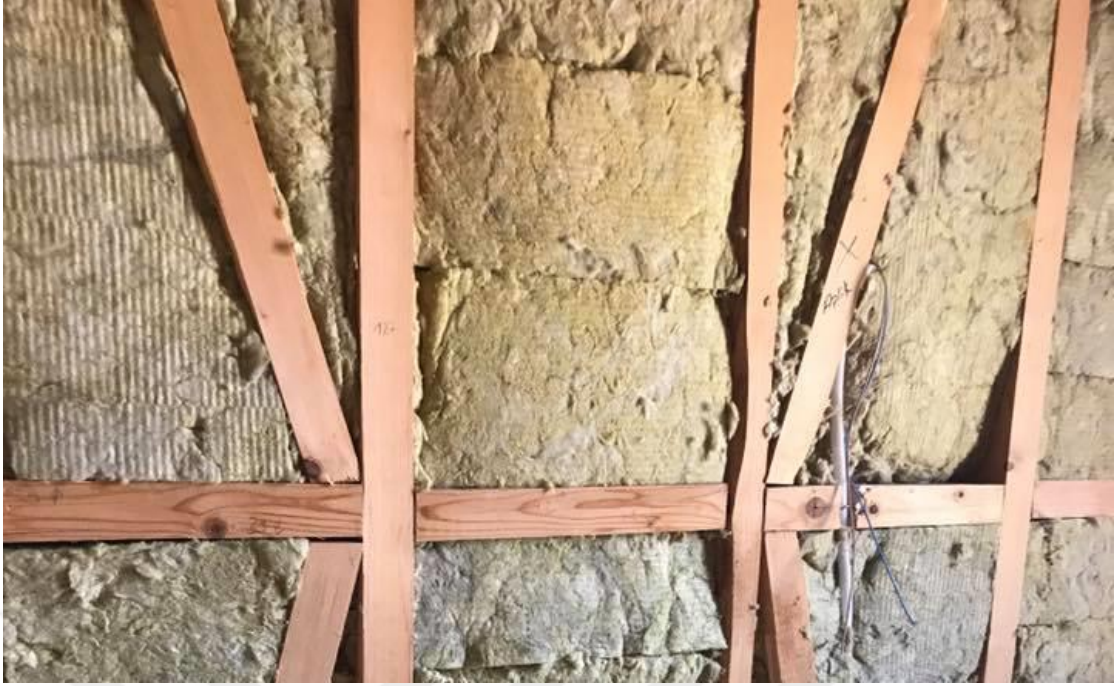
Şekil 3.18. Akyel Evi ısı yalıtımı uygulaması (Koçkuzu, 2013)
