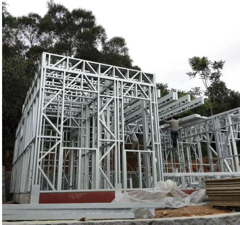
Şekil 3.3. Çelik çerçeve sistem ( https://tr.pinterest.com/horseabuildings/steel-construction-frame-house/ )
