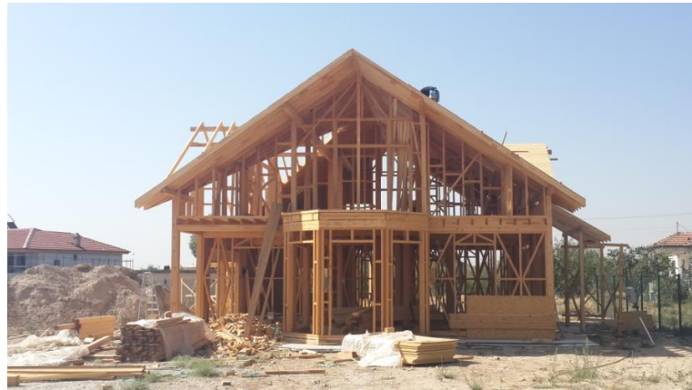
Şekil 3.16. Akyel Evi inşa aşaması (Koçkuzu, 2013)
