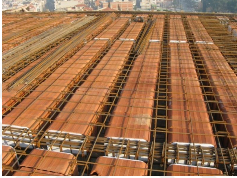
Şekil 3.27. Asmolen döşeme uygulaması ( http://bloksan.com.tr/uygulama )
