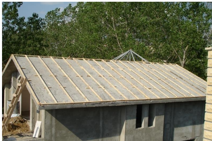
Şekil 3.40. Eğimli betonarme çatı ( http://www.kmyapi.com/hizmetlerimiz/20/beton-uzeri-ahsap-cati )
