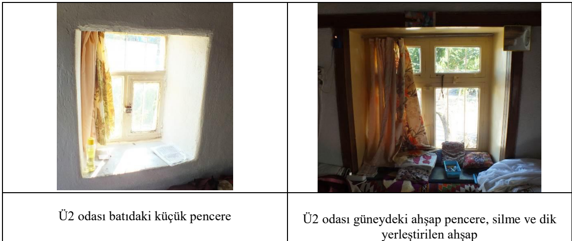
Şekil 4.97. Bekir Demirtaş evi Ü2 odası pencereleri, yatay silme ve dikine ahşap
