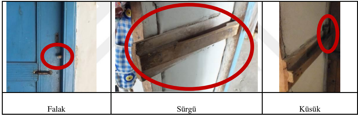
Şekil 4.22. Nuri Aktaş örnek çakma tekniği uygulanan kapı açma ve kilitleme mekanizması
