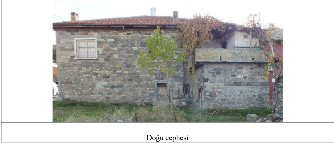
Şekil 4.104. Bekir Demirtaş evinin cephe fotoğrafları
