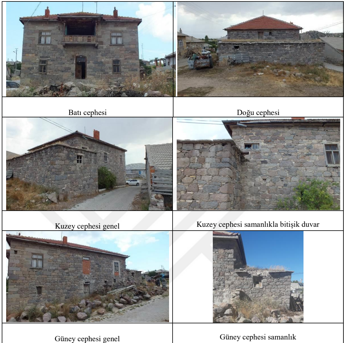
Şekil 4.18. Nuri Aktaş evi cephe fotoğrafları
