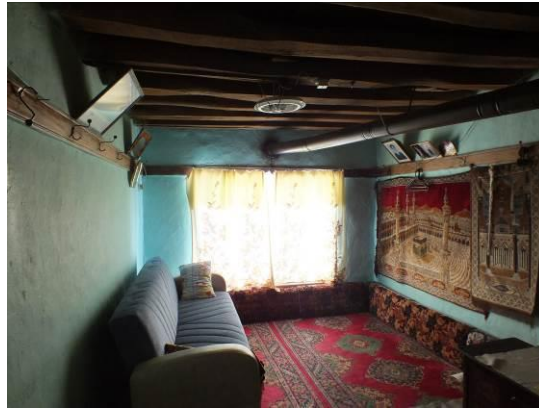
Şekil 4.143. Ü2 odası Ahşap silmeler ve pvc pencere
