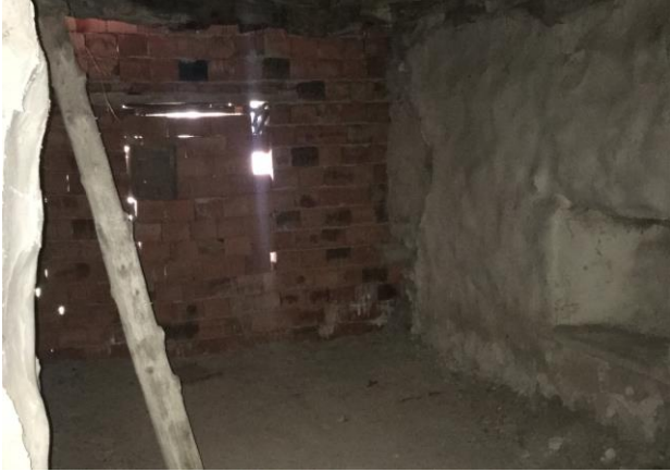
Şekil 4.118. Ü23 odasındaki tuğla duvar ve niş
