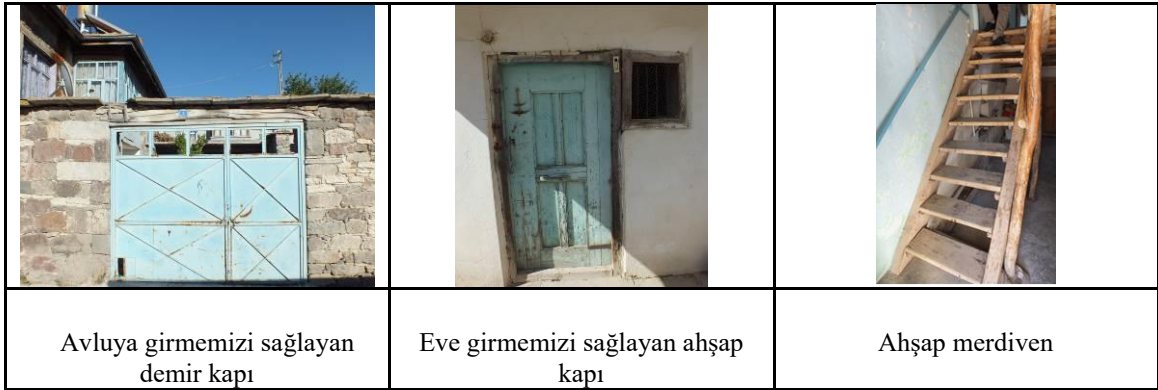
Şekil 4.28. Giriş kapıları ve 1. kata çıkmayı sağlayan ahşap merdiven
