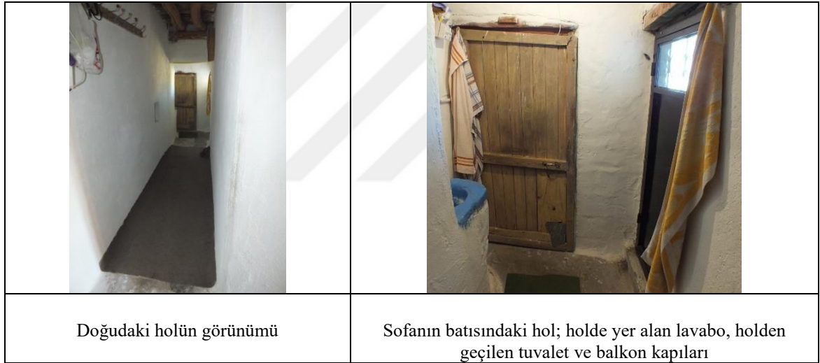
Şekil 4.101. Bekir Demirtaş evi lavabo, tuvalet ve balkon
