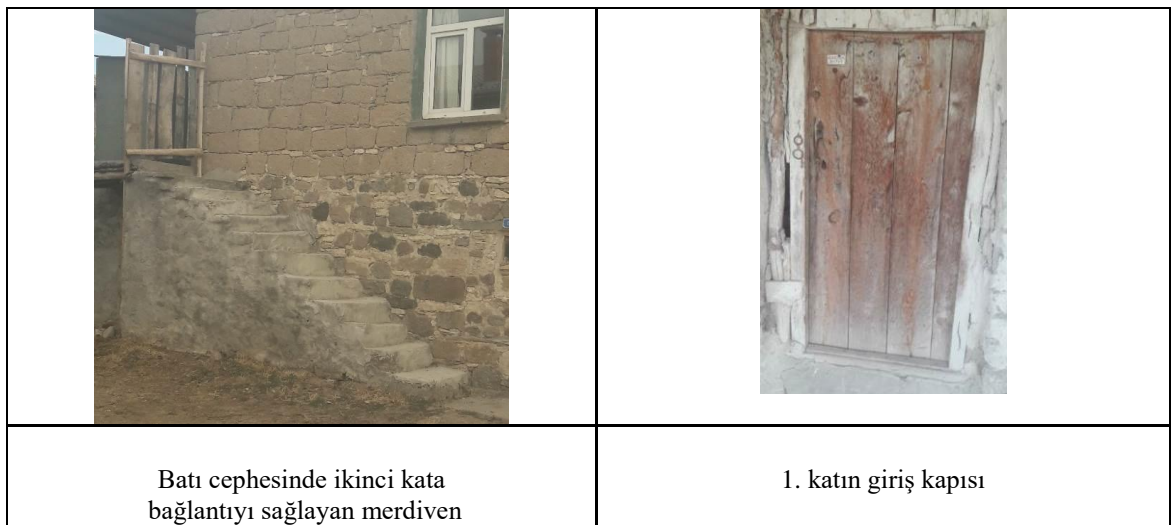
Şekil 4.75. Hüseyin Güroğlu evinin merdiveni ve 1. kat giriş kapısı
