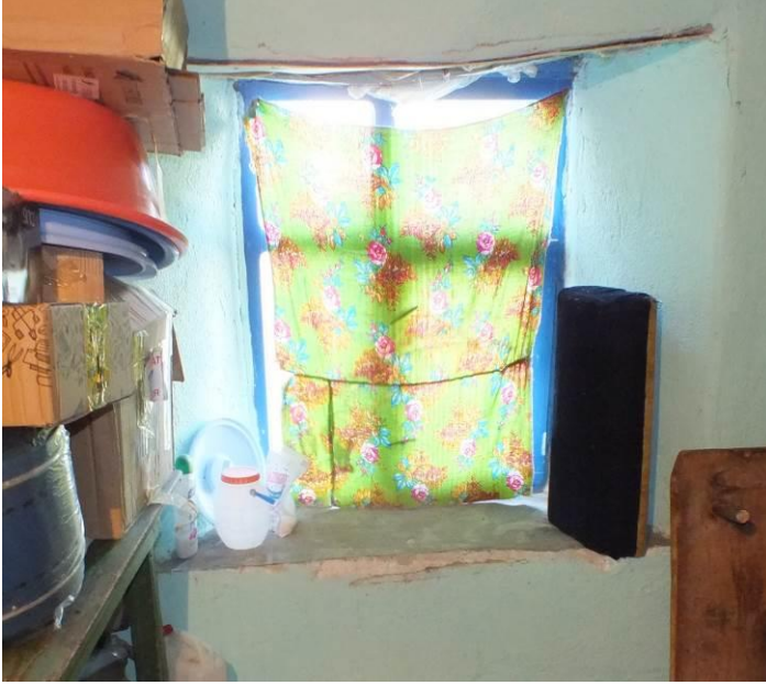
Şekil 4.130. Ü21 odası kuzeydeki ahşap tek kanatlı pencere
