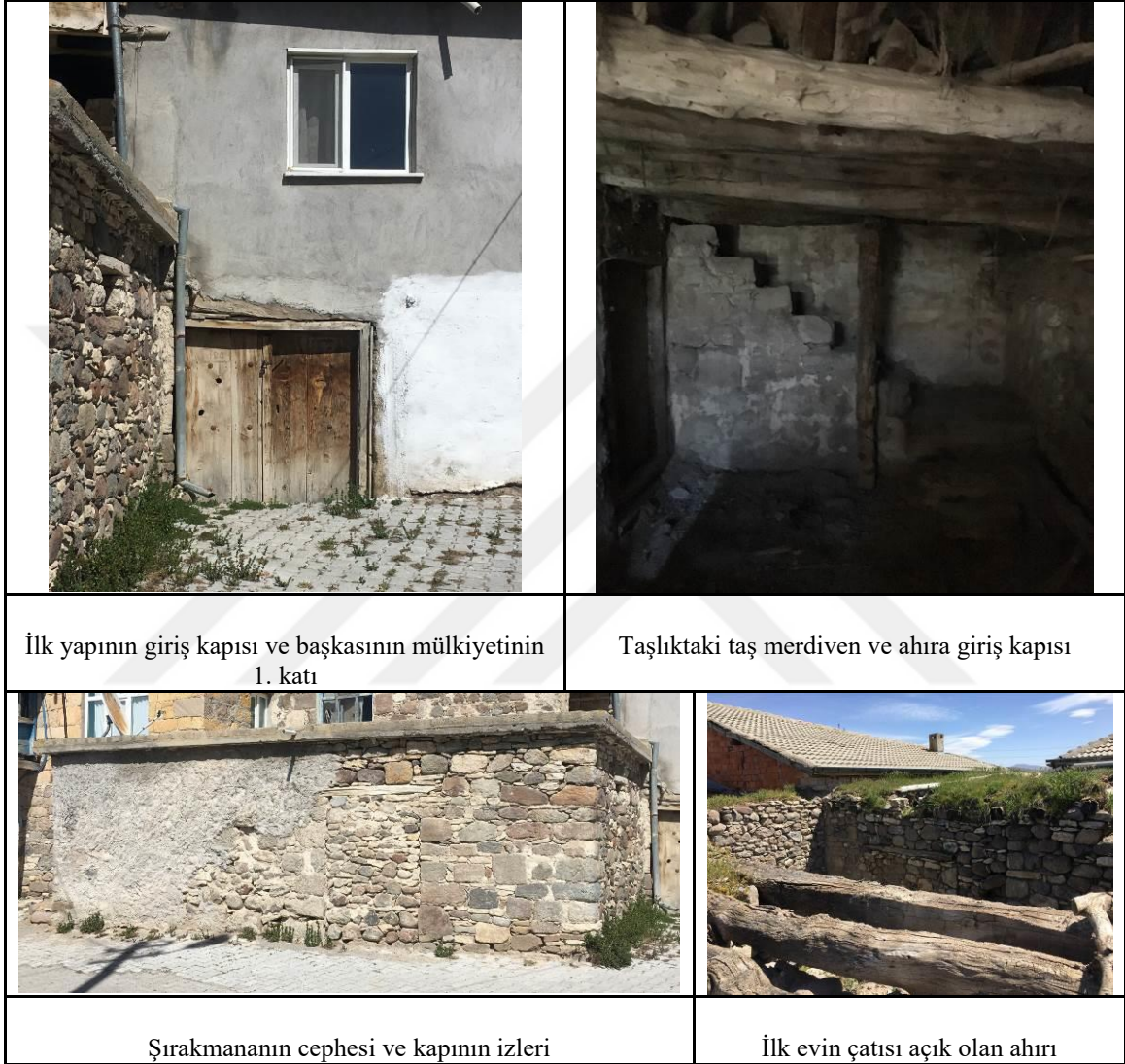
Şekil 4.114. Sadık Kaya evi 1890 yılında yapılan zemin katı
