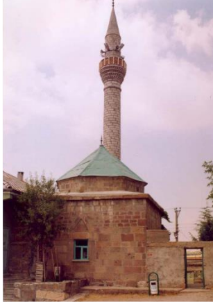
Şekil 3.17. Doğu cephesi (Danışık, 2007)
