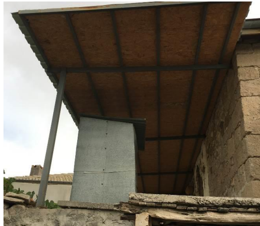
Şekil 4.79. Teras, üstünde yer alan tuvalet, sundurma çatı
