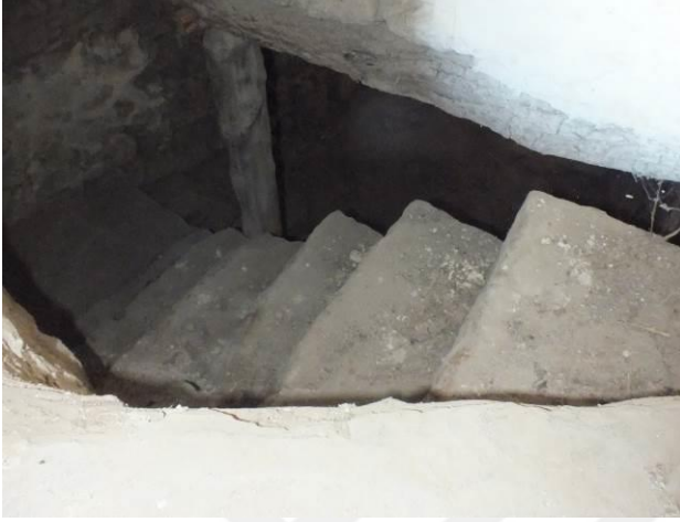
Şekil 4.116. Taş merdiven 1. kattan görünüş
