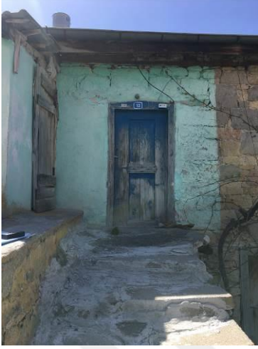
Şekil 4.135. İkinci yapının 1. kat giriş kapısı
