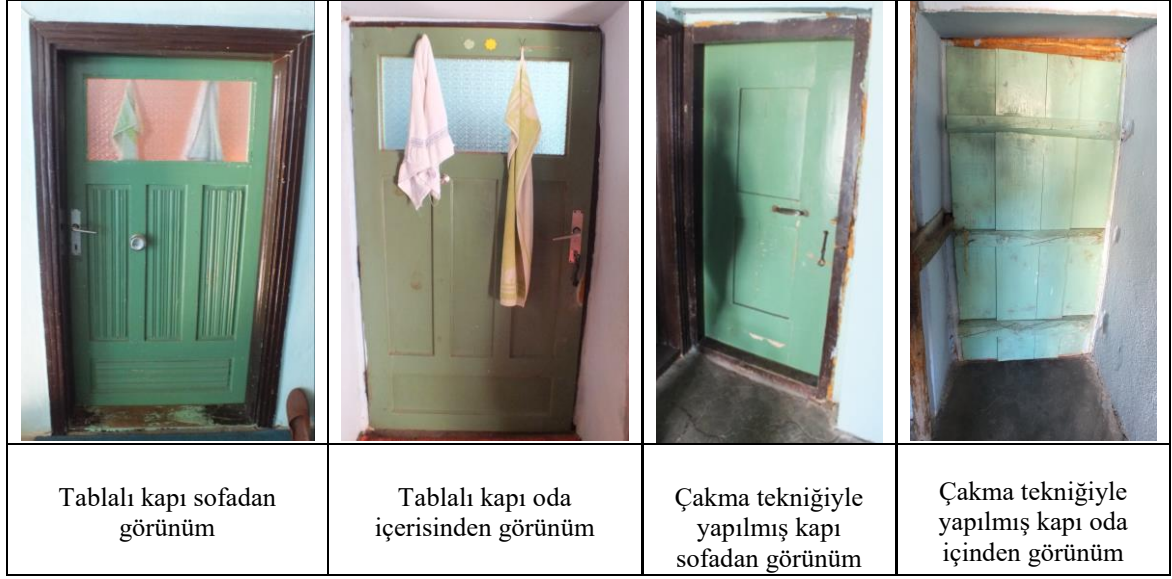
Şekil 4.44. Mehmet Kavalcı çakma ve tablalı kapılara örnek
