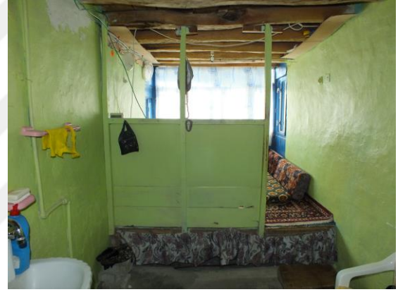
Şekil 4.148. Cumba raf ve askılıkları, ahşap bölme ve basamak
