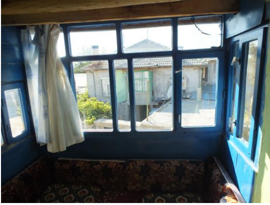
Şekil 4.147. Cumba korkulukları ve penceresi
