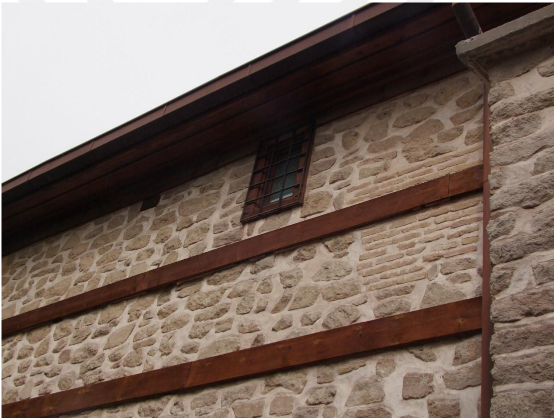
Şekil 5.2. Cami güney (kıble) cephe duvarında tuğla malzeme uygulaması
