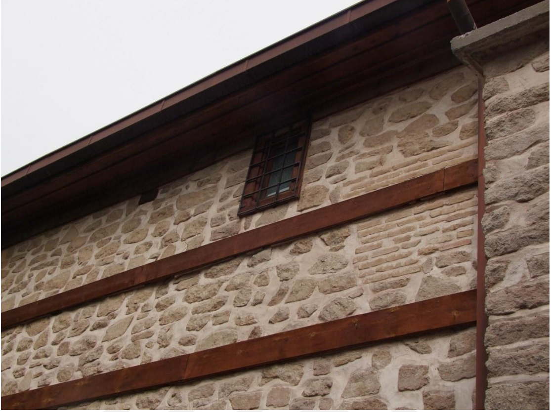
Şekil 5.63. Cami güney cephesinde, mihrap nişi çıkıntısının batısında görülen tuğla örgü
