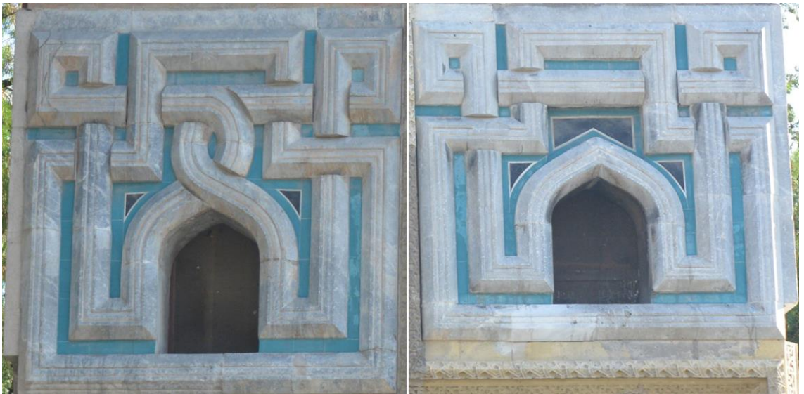
Şekil 5.39. Taç kapının doğu ve batı kısımlarındaki sivri kemerli açıklıkların detaylı görünüşleri
