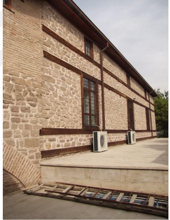
Şekil 5.4. Cami doğu cephesi görünüşü
