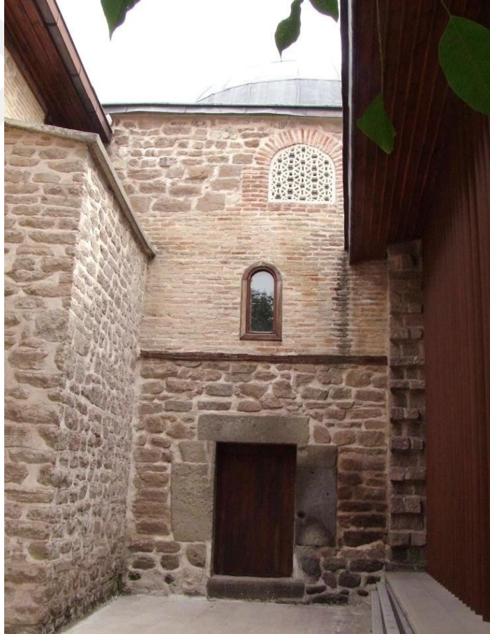
Şekil 4.4. Türbenin batı cephesinde moloz taş ve tuğla malzeme görünümü
