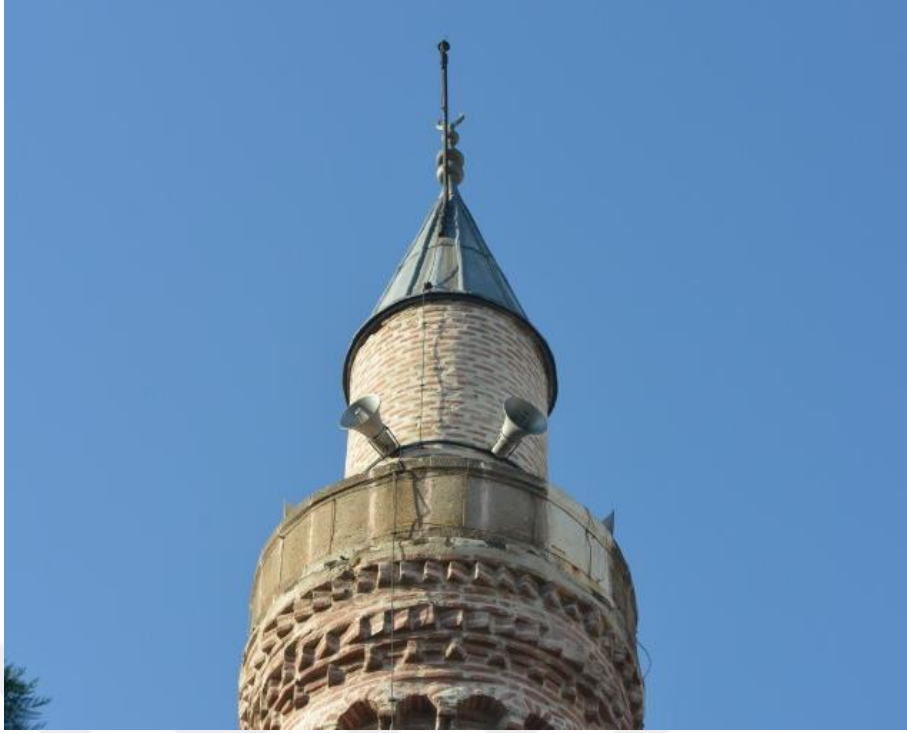
Şekil 5.53. Taç kapı minaresinin şeref, petek ve külâh kısımları güney cephe görünüşü
