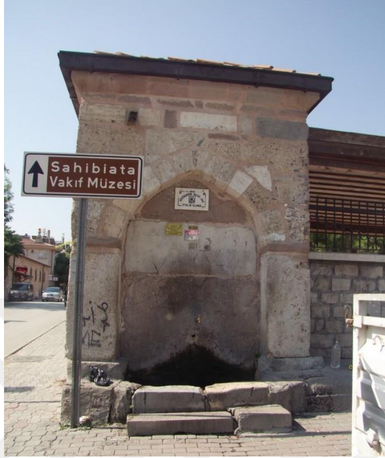
Şekil 4.21. Çeşme kuzey cephe görünüşü
