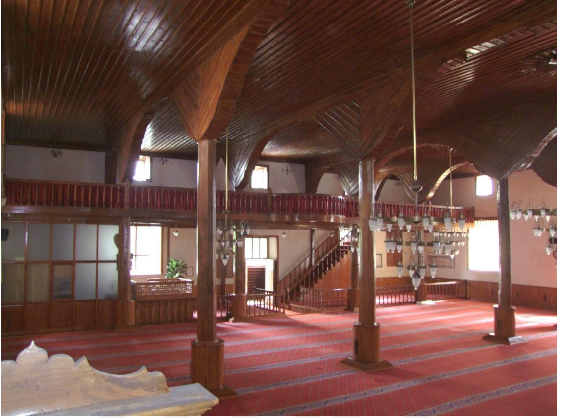
Şekil 5.11. Harim genel görünüşü (güneybatıdan)
