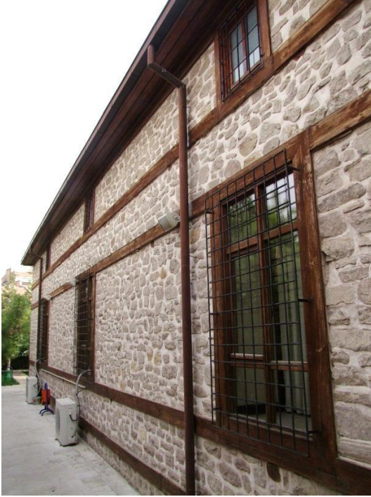
Şekil 5.3. Cami batı cephesi görünüşü
