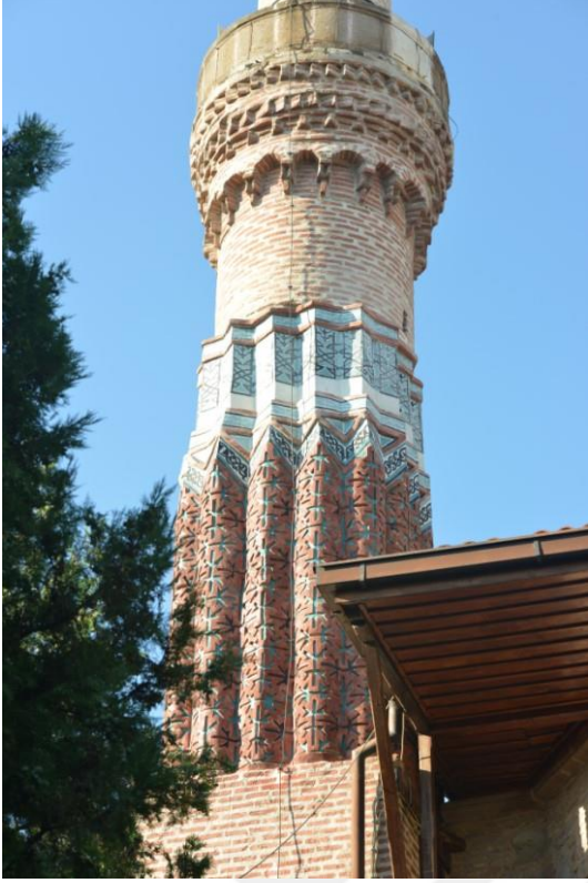
Şekil 5.49. Taç kapı minaresi güney cephesi
