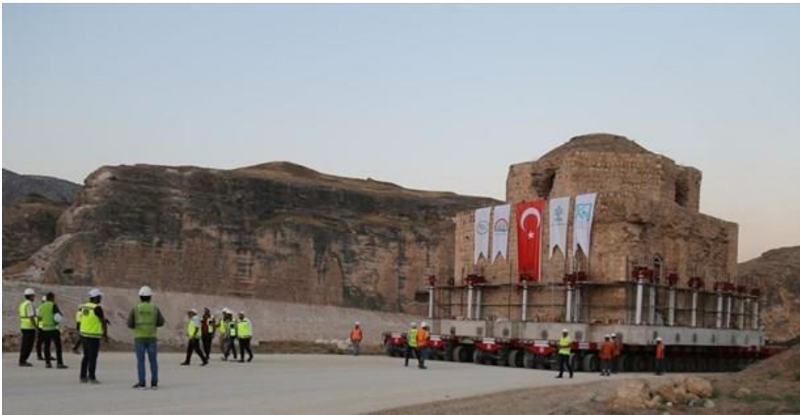
Şekil 5.1. Artuklu Hamamının SPMT Kullanılarak Taşınması.
