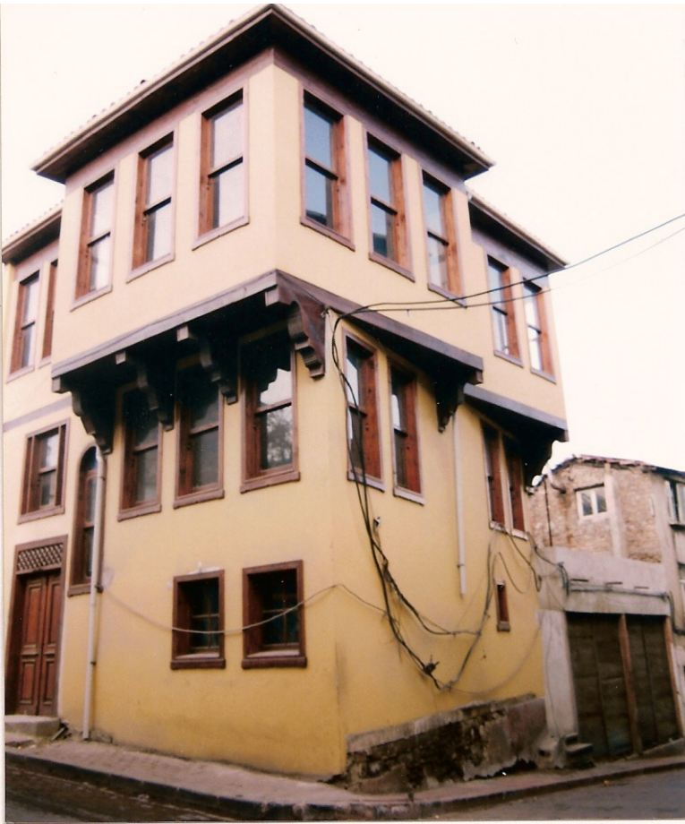
Fotoğraf 63: Cibali’de Aynı Evin Restorasyon Sonraki Hali
