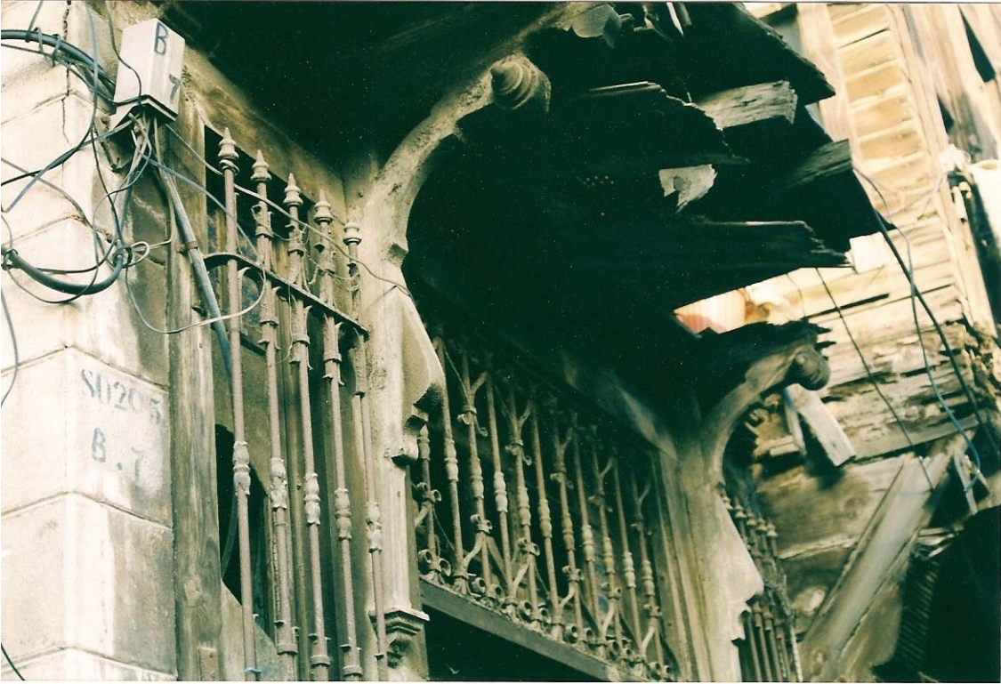
Fotoğraf 43: Aynı Konaktan Görünüş
