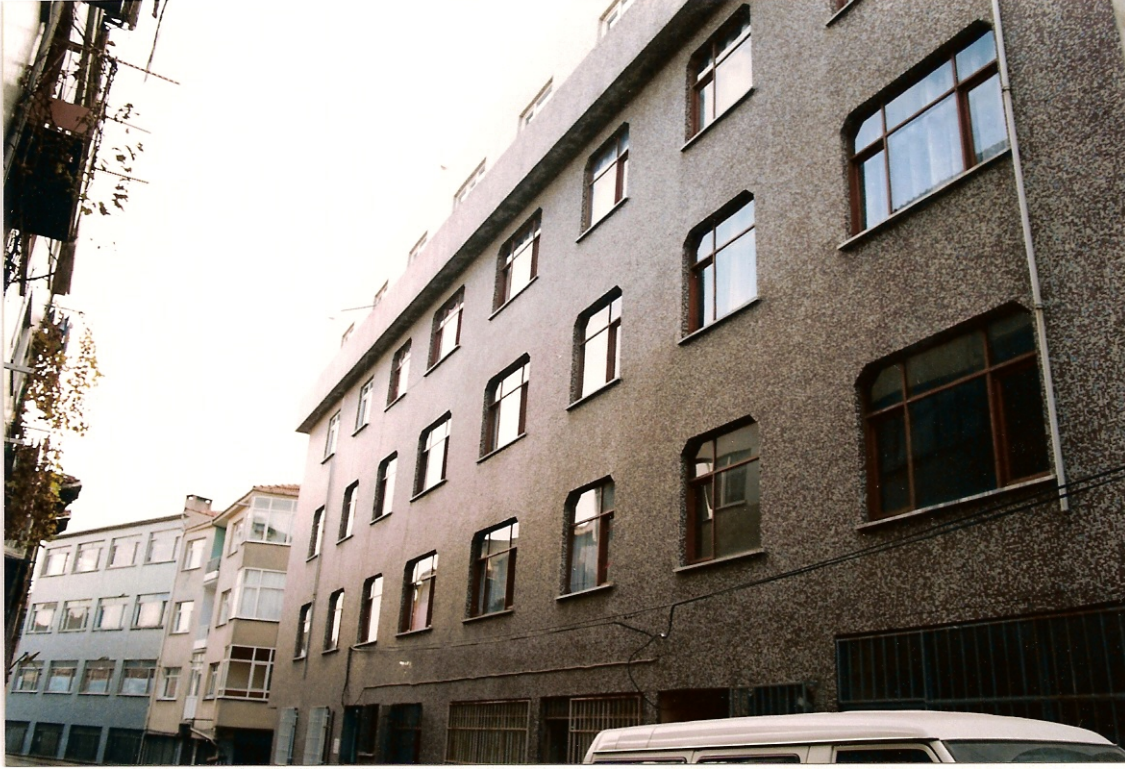
Fotoğraf 78: Cibali’de, Salih Paşa Caddesinde Yeni Bir Yapı
