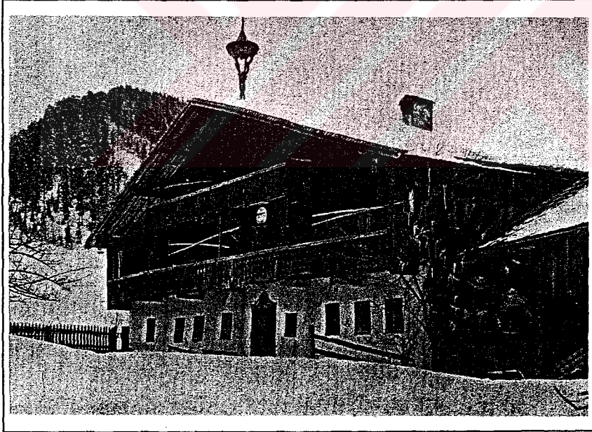
Foto: 4.23. Salzburg'ta ahşap yığma yapı (Kaynak: Hermann Phleps)
