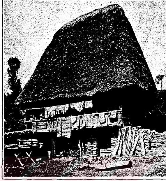
Foto. 4.25. Almanya üst Bavyera'da iklimine uygun sıkıştırılmış ot ve toprak çatı (Kaynak: Hermann Phelps)
