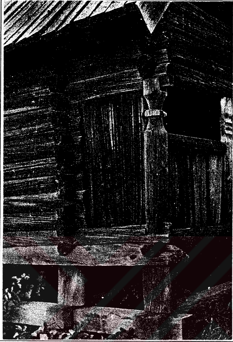
Foto 4.27. İsveç, Stockholm'de ortaçağda yığma konstrüksiyonla dikme sisteminin kullanıldığı karma sistem detayı Kaynak: (Hermann Phleps)
