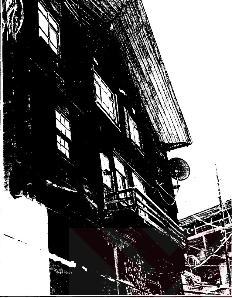
Foto 2.10. Ahşap dikme ve taş temel üzerine yapılan yığma ahşap konutta saçak ve balkon detayı (Suat Çakır)
