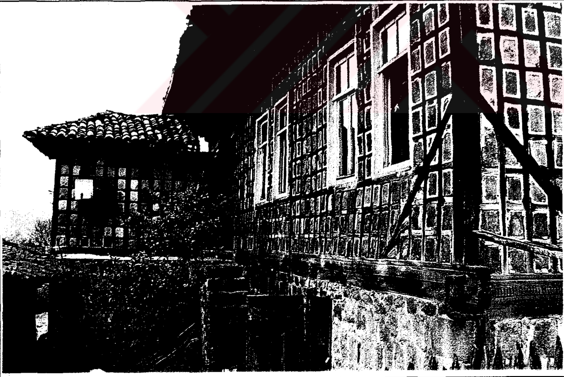
Foto 2.23. Sürmene-Karacakaya Köyü, göz dolma tekniği ve köşe birleşmesi (Suat Çakır)
