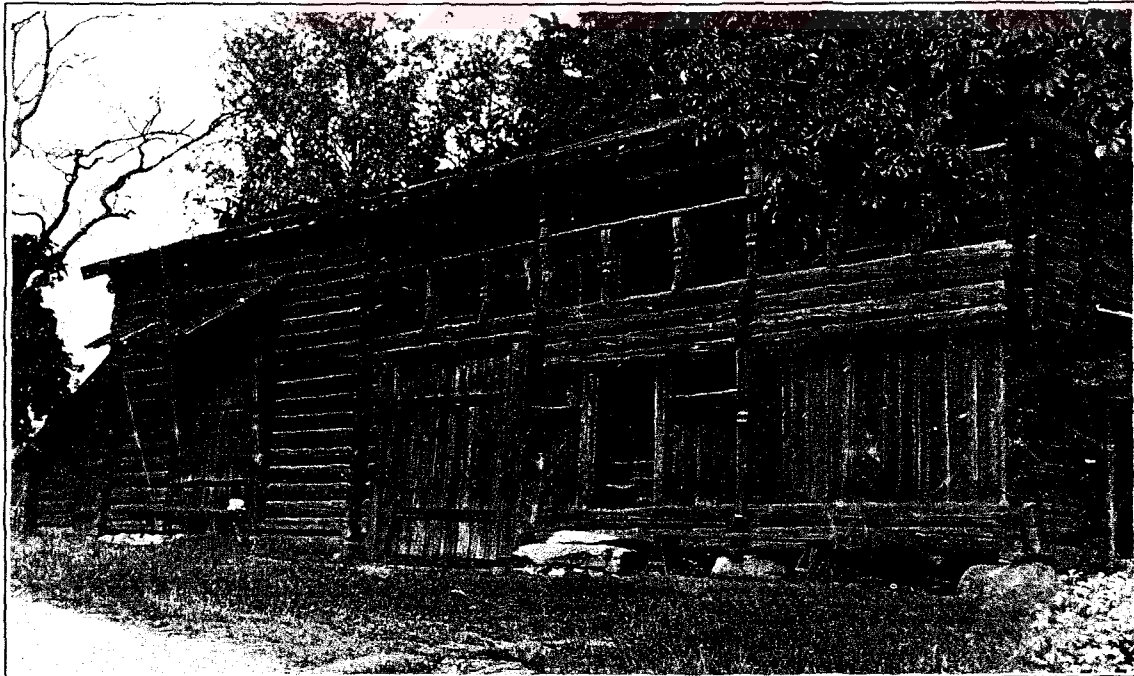
Foto 4.26. İsveç, Stockholm'de 1566 tarihli bir depo, yığma ahşap sistemde yapılmıştır Kaynak: (Hermann Phleps)
