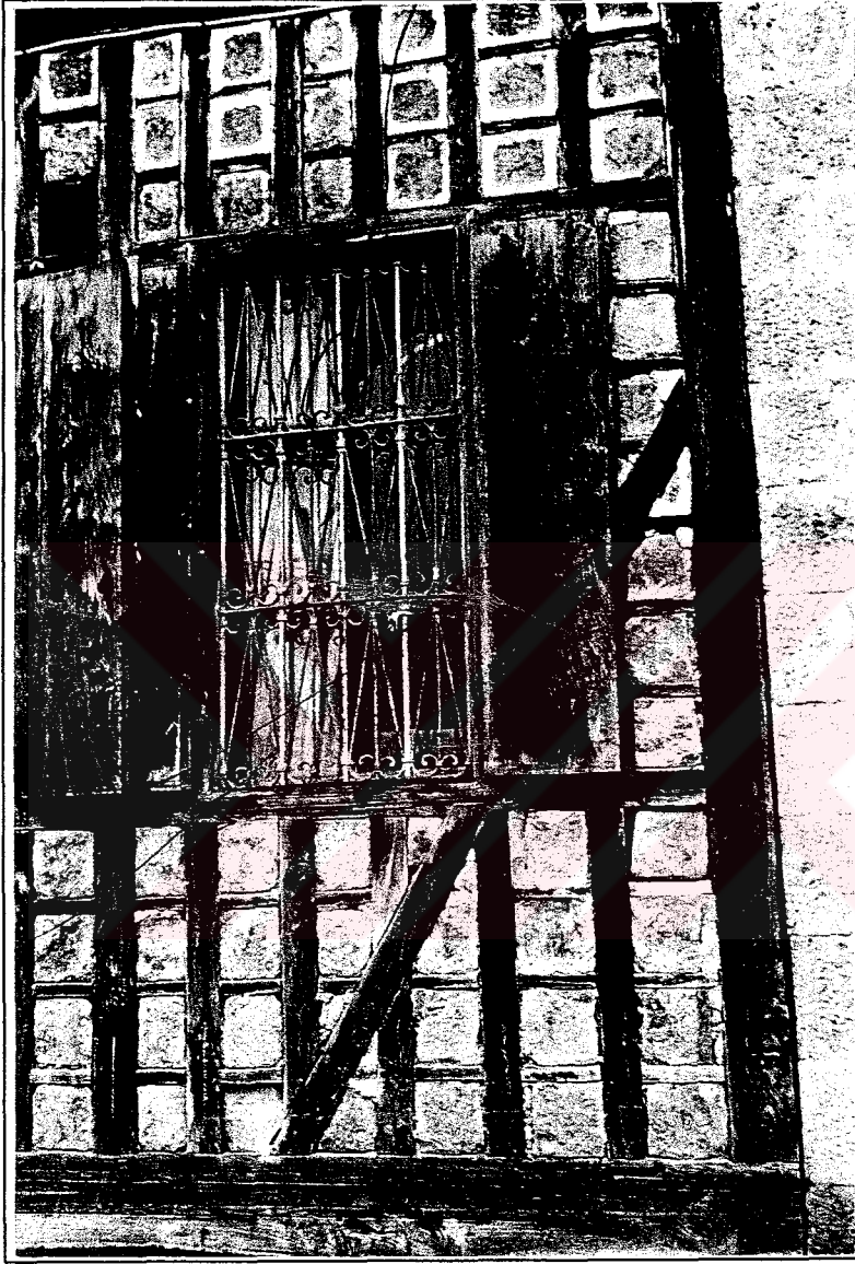
Foto 2.25. Sürmene-Gültepe Guzara Köyü, 99 pencere köy konağı, Ahşap taş birleşmesi pencere detayı (Suat Çakır)
