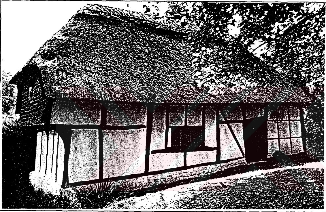
Foto 4.13. Karma çerçeve sistem, Kent (Kaynak: Eric Mercer)
