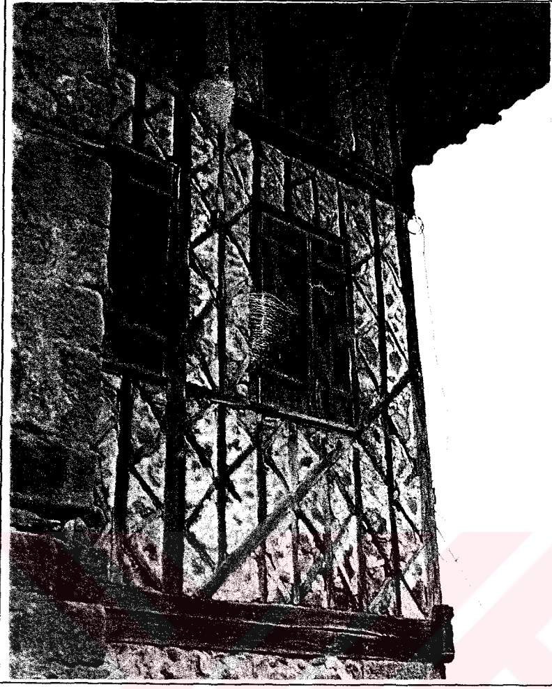
Foto 2.30. Aynı konağın taban, köşe ve tepe penceresi detayı (Suat Çakır)
