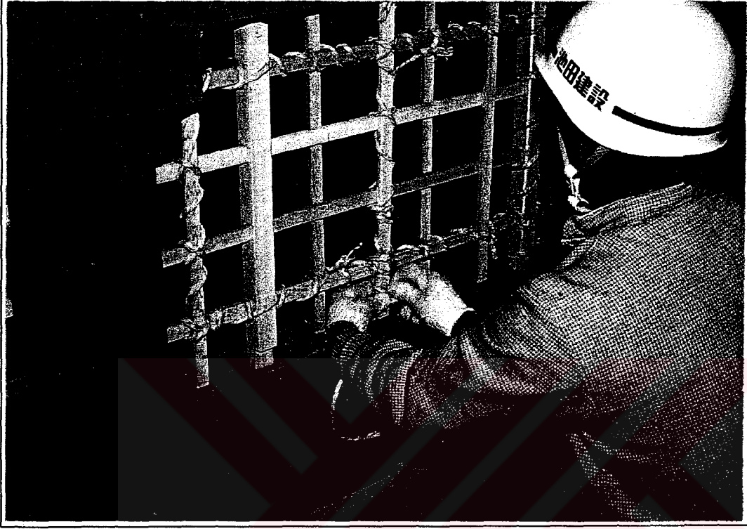
Foto 4.15. İnce ahşap latalar ahşap ip ve şeritlerle bağlanır (Kaynak: Azby Brown)
