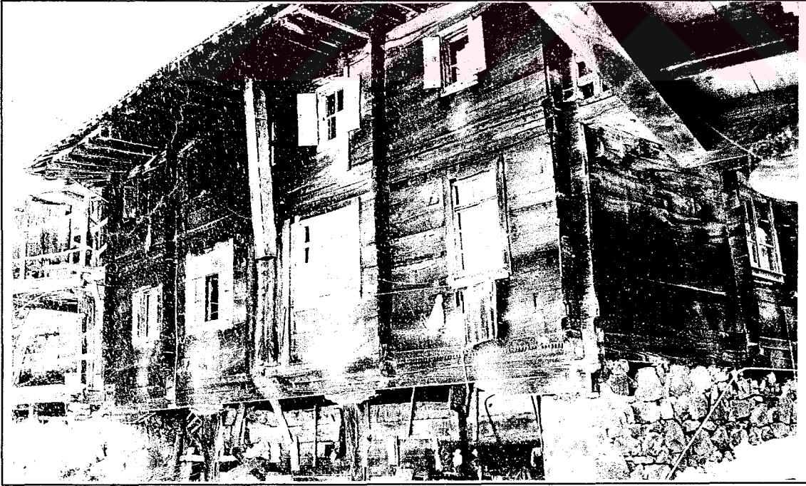
Foto 2.11. Yığma ahşap sistemde köşe detayı (Suat Çakır)
