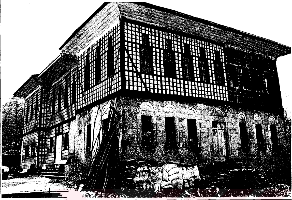
Foto 2.22. Sürmene-Gültepe (Guzara Köyü), 99 pencere köy konağı, göz dolma sistem (restore ediliyor) (Suat Çakır)
