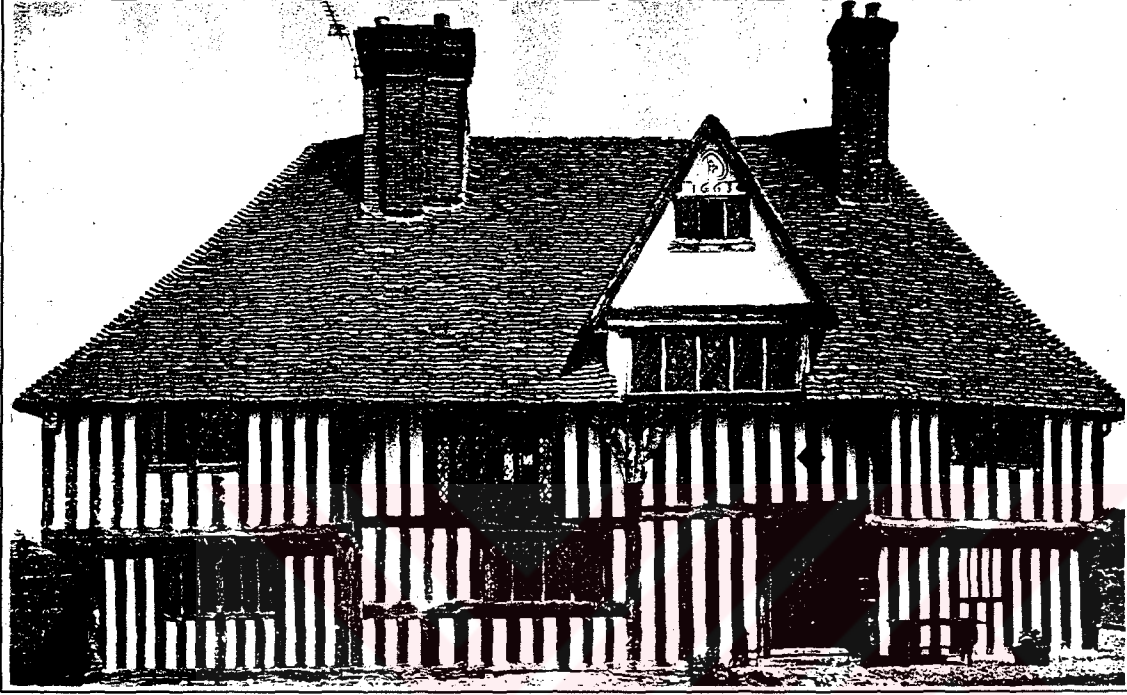
Foto 4.5. Sık dikmeli çerçevlendirme, Kent. (Kaynak: Eric Mercer)
