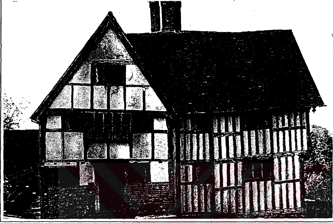
Foto 4.7. Orta kuşaklı-sık dikmeli çerçvelendirme, Kent, Chiddigstonn (Kaynak: Eric Mercer)
