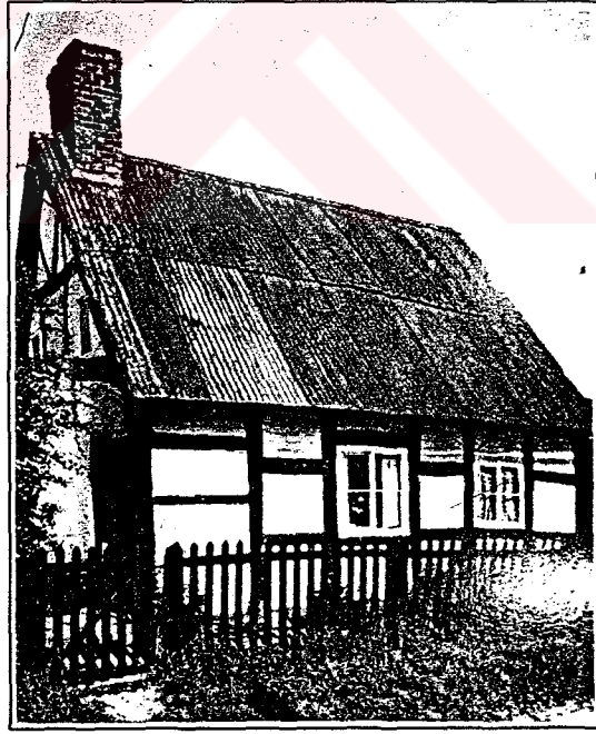
Foto 4.4. Cruck-konstrüksiyonla yapılmış küçük çerçvelendirme (Kaynak: Eric Mercer)
