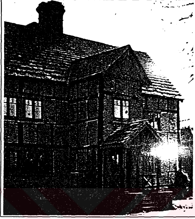
Foto 4.14. Kısa çerçeve + sık panel, Sussex (Kaynak: Eric Mercer)
