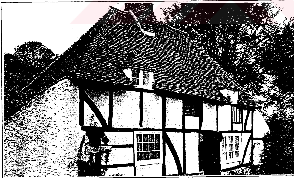
Foto 4.2. Geniş çerçevlendirme, Kent (Kaynak: Eric Mercer)
