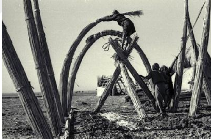
Şekil 3.37 El Mudhif'in yapı metodu (Puiu, 2019).
