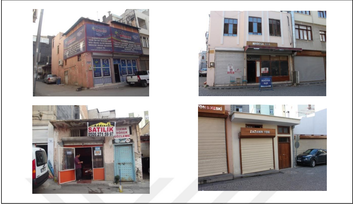
Şekil 7.20. Yeni Yapı Cephe Yenileme Öncesi Durumu 2016
