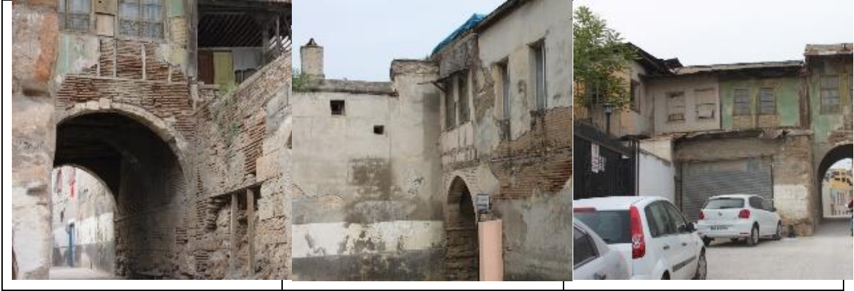
Şekil 7.23. Musa Bali Konağı Restorasyon öncesi durumu 2017
