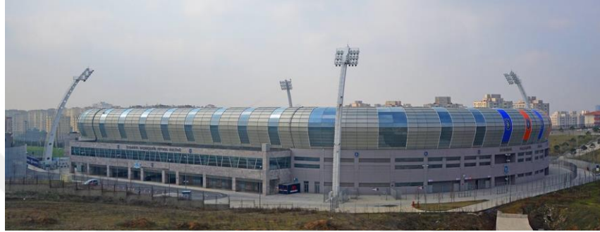
b) Başakşehir Fatih Terim Stadyumu - Cephe, (Web 25, 2019).
