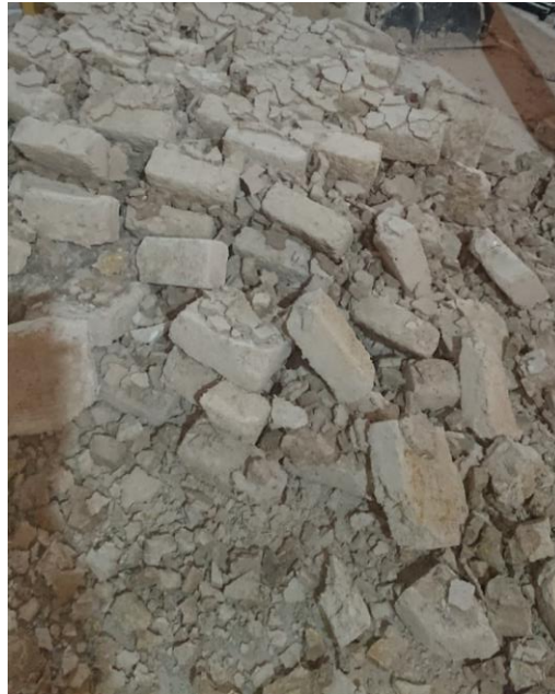
Şekil 4.1. DÇHS-1 duvar numunesinin göçmesi sonrasındaki oluşan moloz yığını
