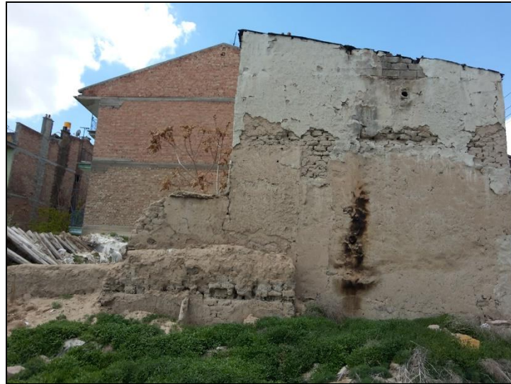
Şekil 3.39. Tescilli yığma kerpiç yapı harç numunesi alınan duvar
