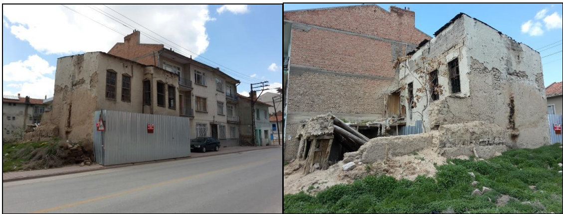
Şekil 3.26. a), b) Türbeönü semtinde yer alan kerpiç numunesi alınan tescilli yığma kerpiç yapı (Örn.-2)
