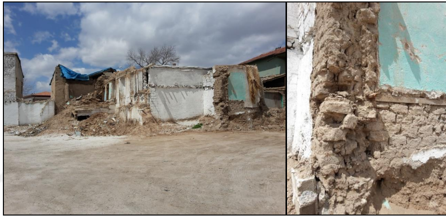
Şekil 3.25. a), b) Türbeönü semtinde yer alan kerpiç numunesi alınan tescilsiz yığma kerpiç yapı (Örn.-1)
