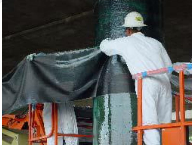
Şekil 2.16. Kolonları CFRP ile sararak güçlendirme örneği (Sipahioğlu, 2006)
