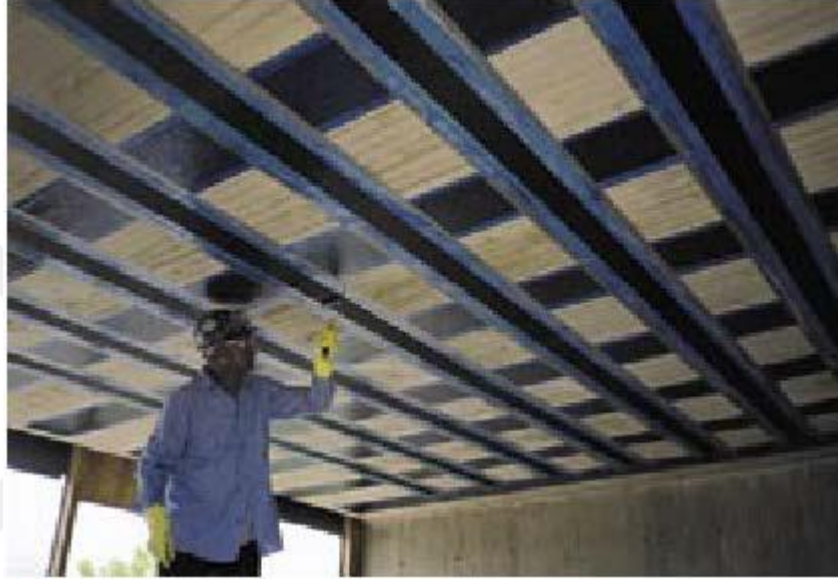
Şekil 2.33. Döşemeleri lifli polimerler kullanılarak güçlendirme (Sipahioğlu, 2006)
