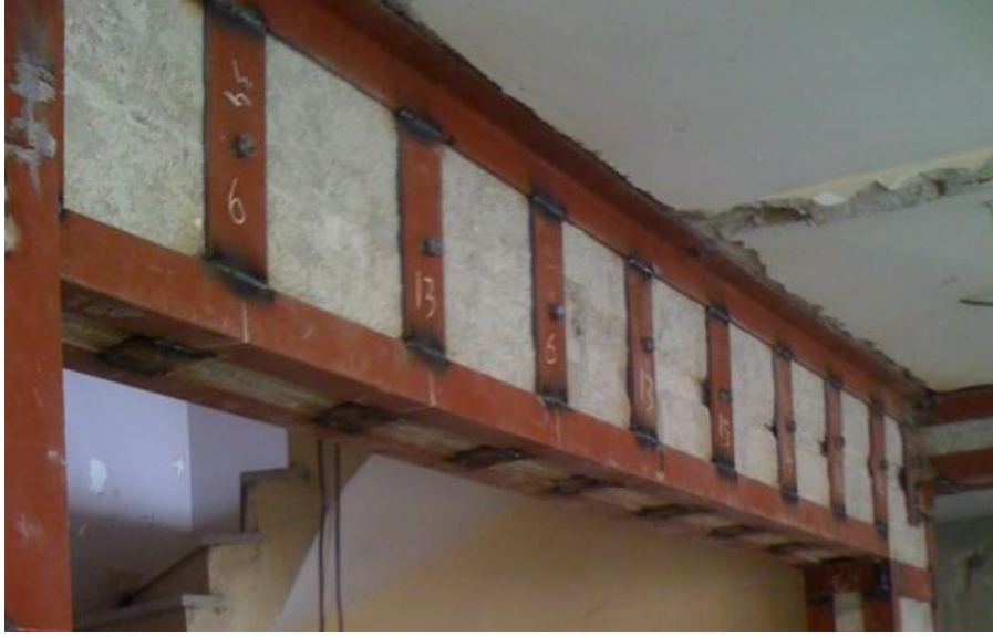
Şekil 2.21. Kirişleri çelik levhalar ile sararak güçlendirme örneği (Şik, 2014)
