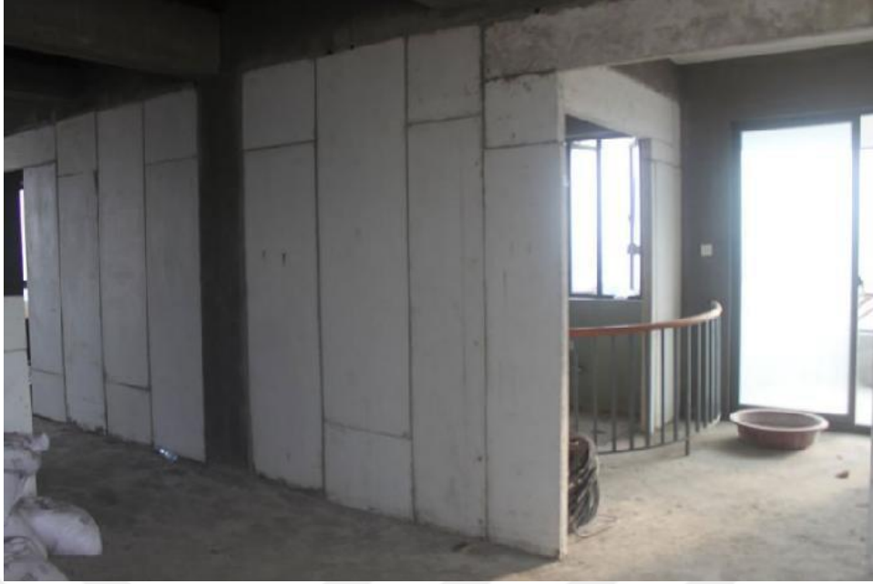
Şekil 2.53. Çerçeveleri hazır dökülmüş panolar ile güçlendirme örneği (Şik, 2014)
