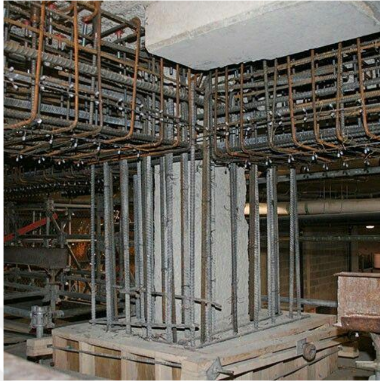
Şekil 2.26. Birleşim bölgesini mantolama ile güçlendirme örneği (Web6)
