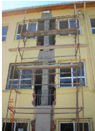
Şekil 3.11. Kolonların mantolanması sırasında cephe (Nuhoğlu ve ark., 2009)
