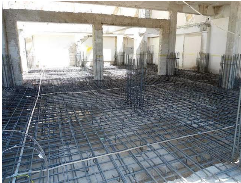
Şekil 2.32. Döşemenin üstten kalınlığını arttırarak güçlendirme (Web9)
