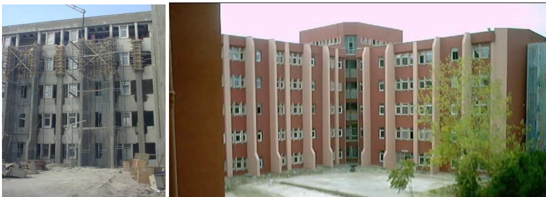
Şekil 2.56. Yapıya dış perde ekleme (Ören, 2010) (Şik, 2014)
