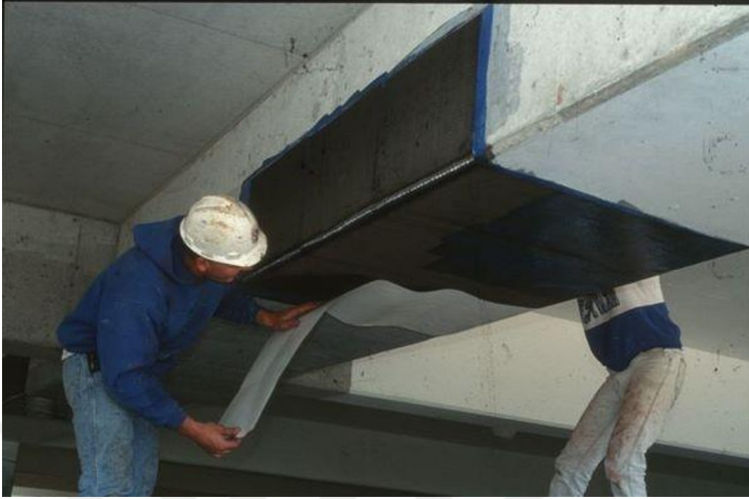
Şekil 2.22. CFRP ile kiriş sargı yöntemi (Web5)
