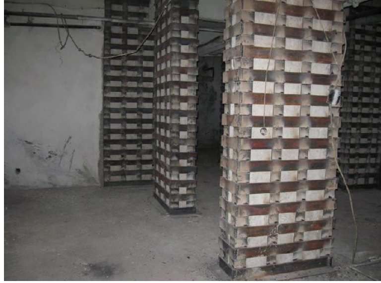
Şekil 2.14. Kolonları çelik levhalar ile güçlendirme örneği (Şik, 2014)
