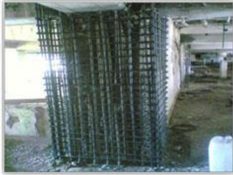
Şekil 2.12. Kolonları kanat ekleyerek güçlendirme örneği (Web4)
