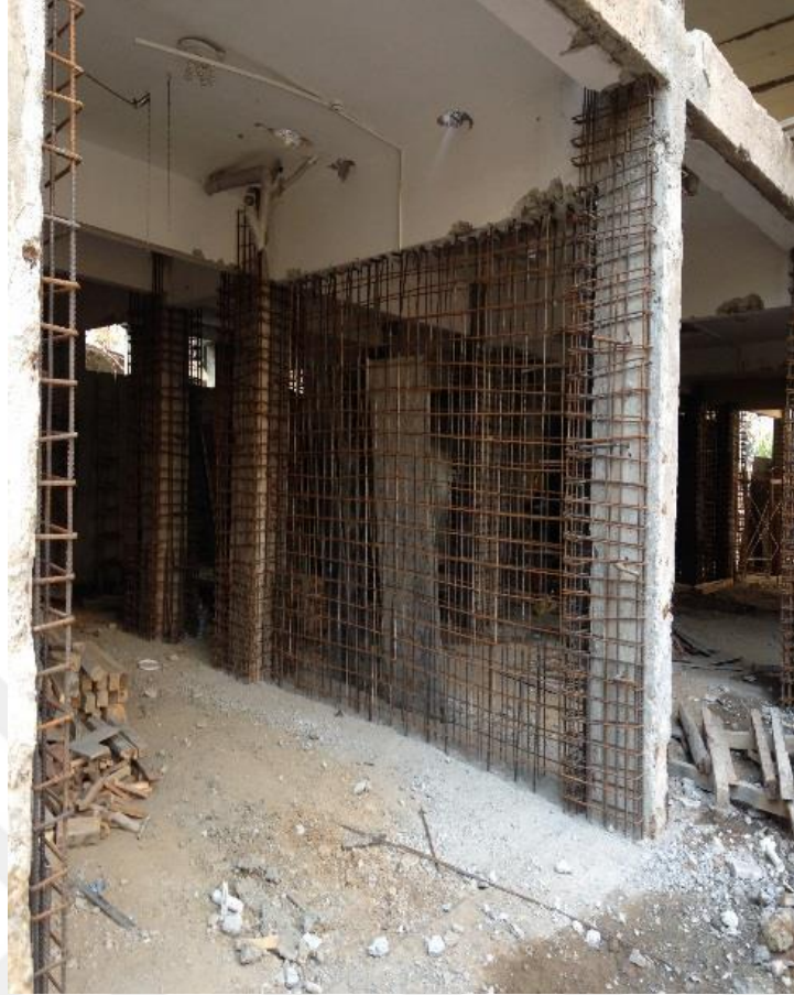
Şekil 2.45. Çerçeve düzlemi içerisinde betonarme perde eklenmesi (Bawary, 2018)
