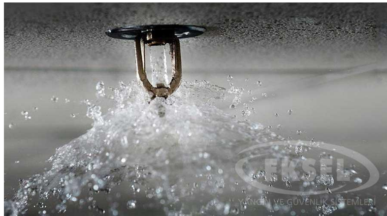
Şekil 2.3 Otomatik yağmurlama sistemi (Web adresi 1)
