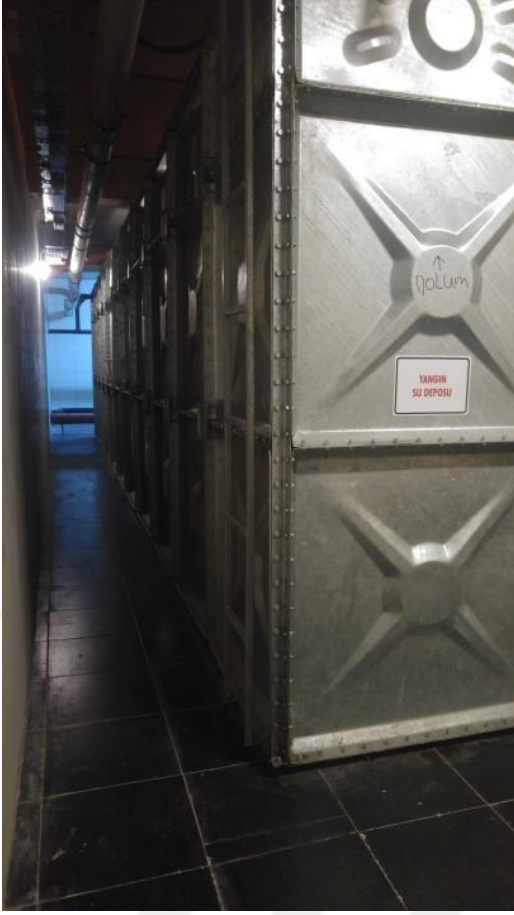
a) Yangın suyu deposu
