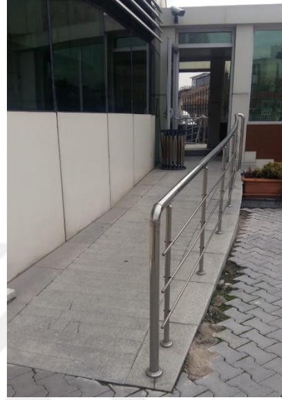
b) Rampada kaymayı önleyici engelleyici yüzey
