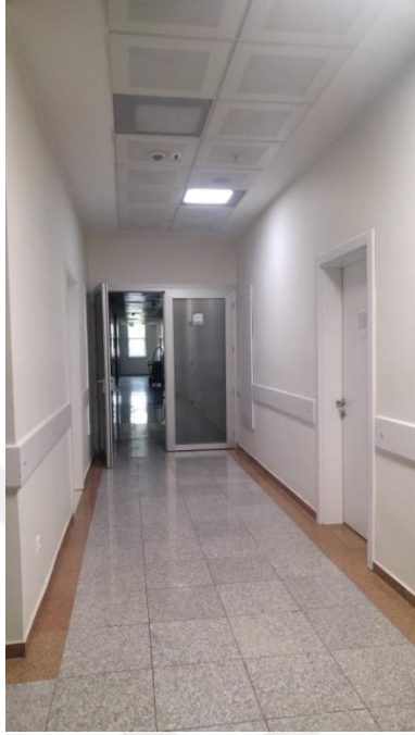
a) Korunumlu iç kaçış koridoru kapısı
