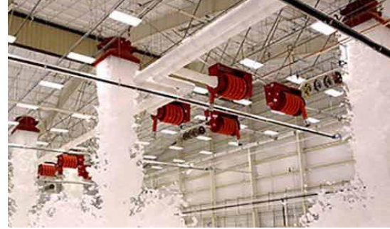
b) Köpüklü söndürme sistemleri
