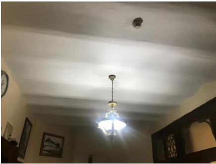
Şekil 4.34. Bağdat Oteli Volta Döşeme
