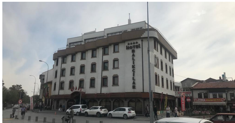
Şekil 4.126. Balıkçılar Otel dış cephe görünümü
