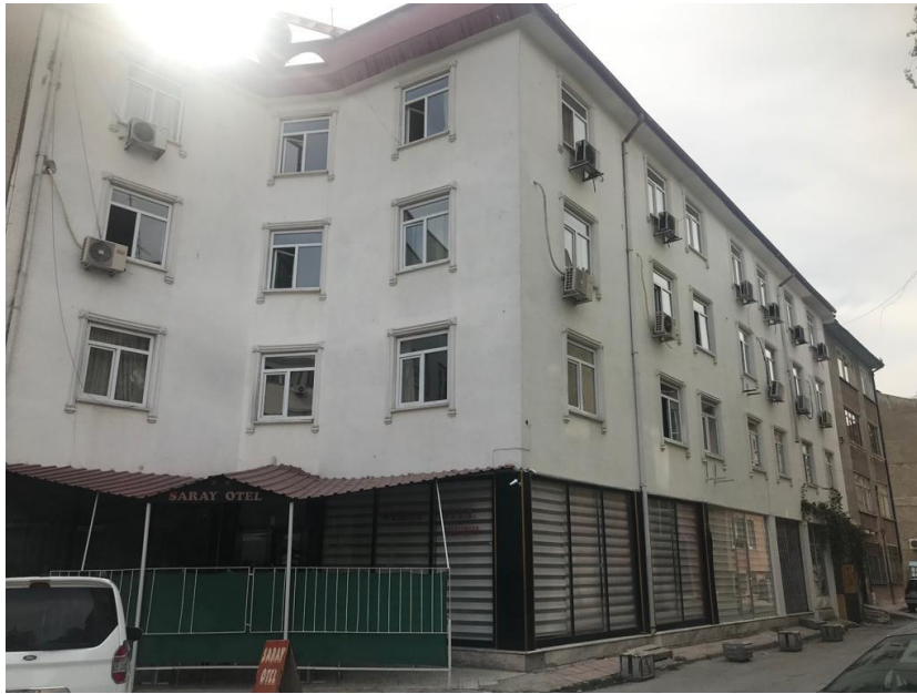
Şekil 4.104. Saray Otel Dış Cephe Görünüm
