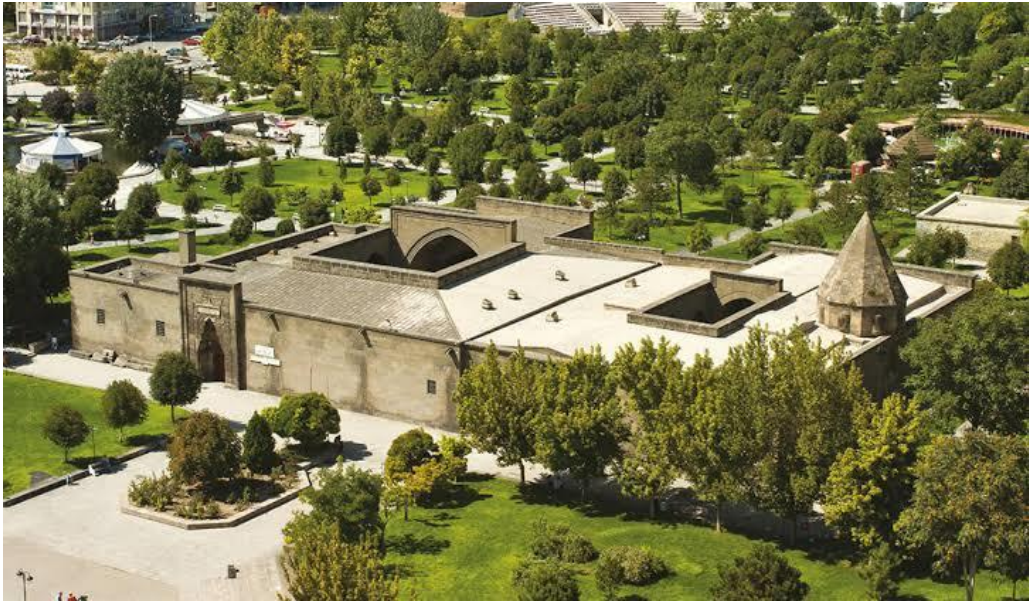
Şekil 2.9. Kayseri Gevher Nesibe Darüşşifası görünüşü (www.kayseri.bel.tr)
