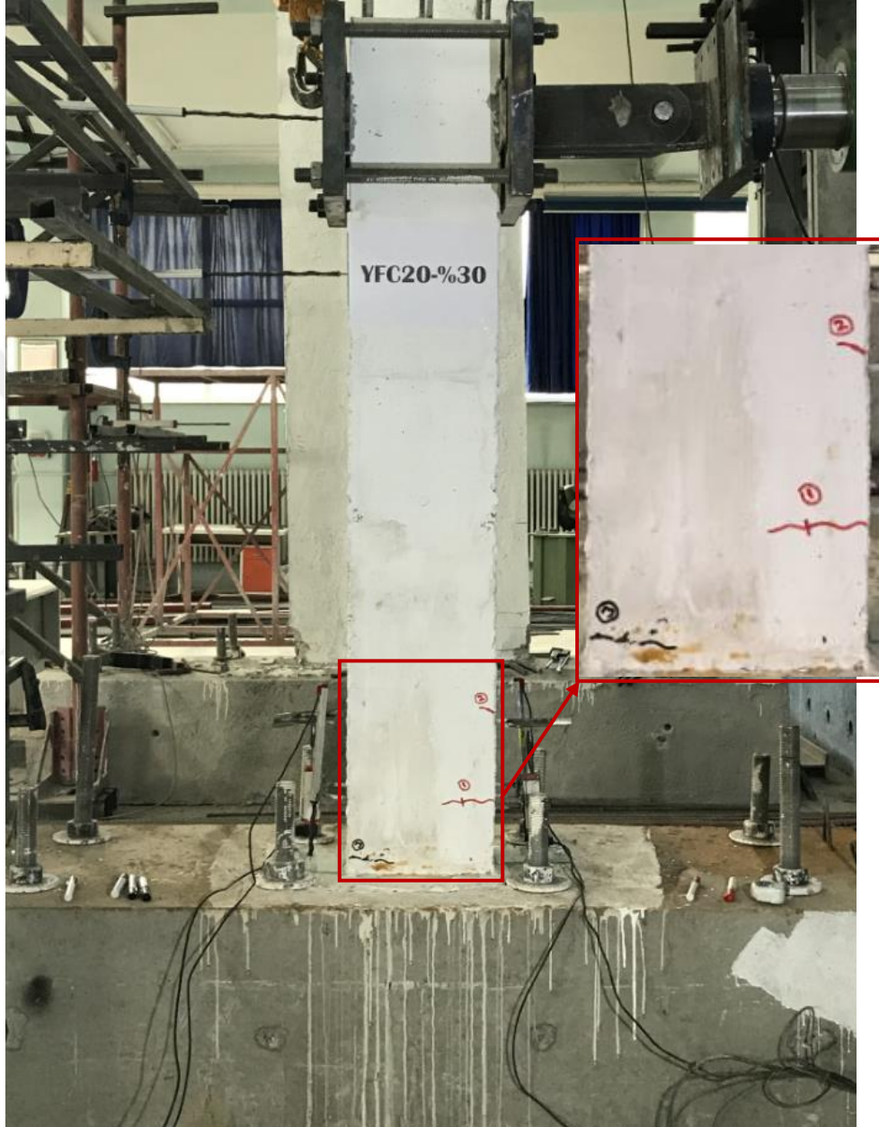
Şekil 4.150. YFC20-%30 deney numunesinde oluşan ilk çatlaklar
