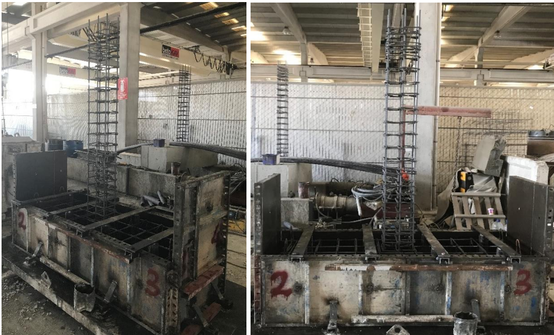
Şekil 3.7. Numune kalıplarına donatıların yerleştirilmesi
