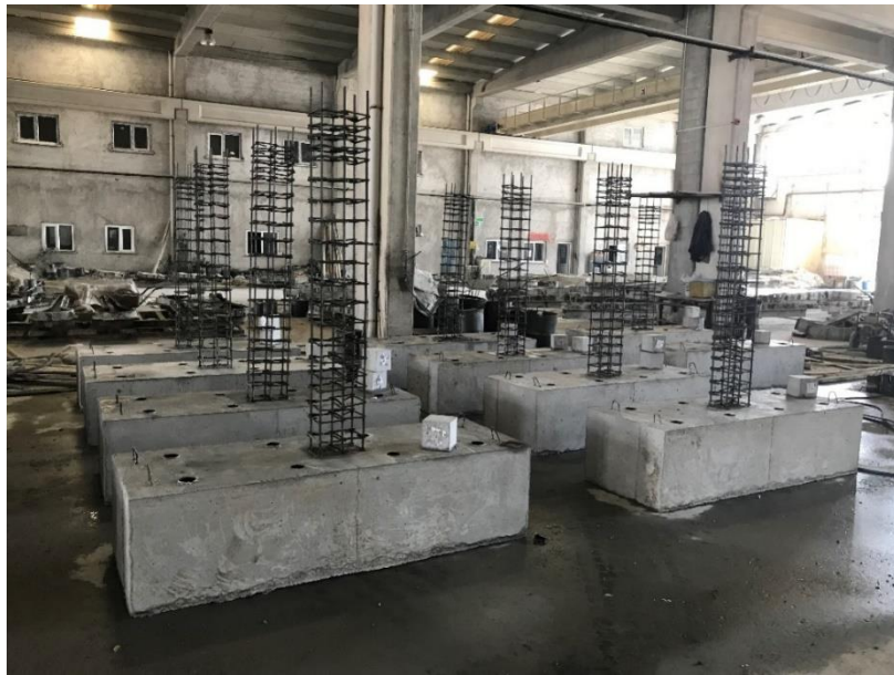
Şekil 3.9. Temel kalıpları söküldükten sonra numunelerin durumu
