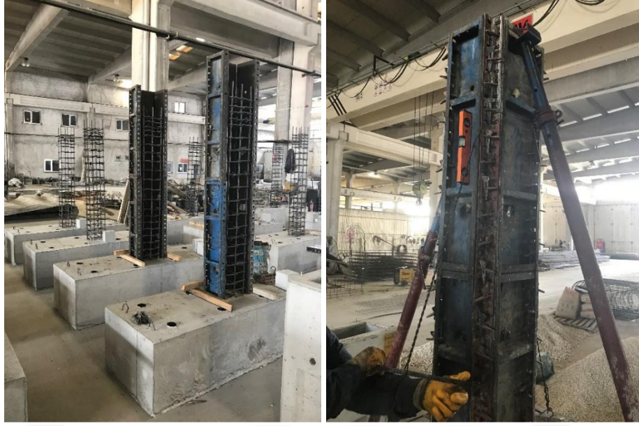
Şekil 3.11. a) Kolon kalıp imalatı b) Düşey terazinin ayarlanması
