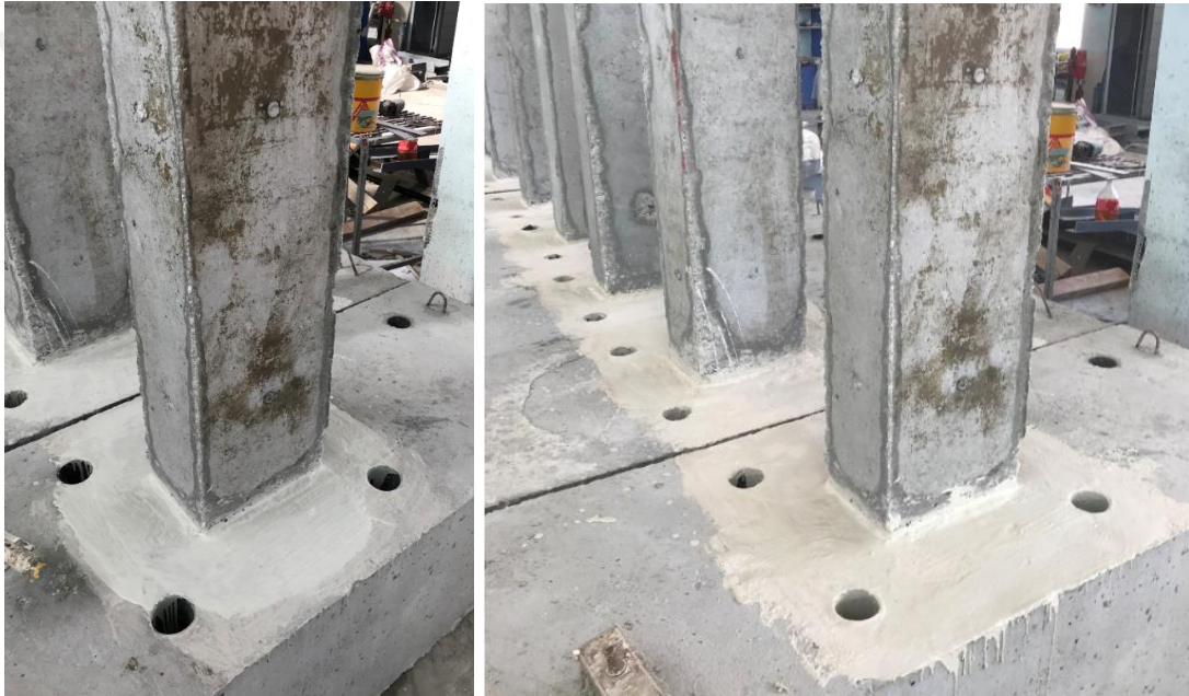
Şekil 3.22. Su yalıtım malzemesinin uygulanması
