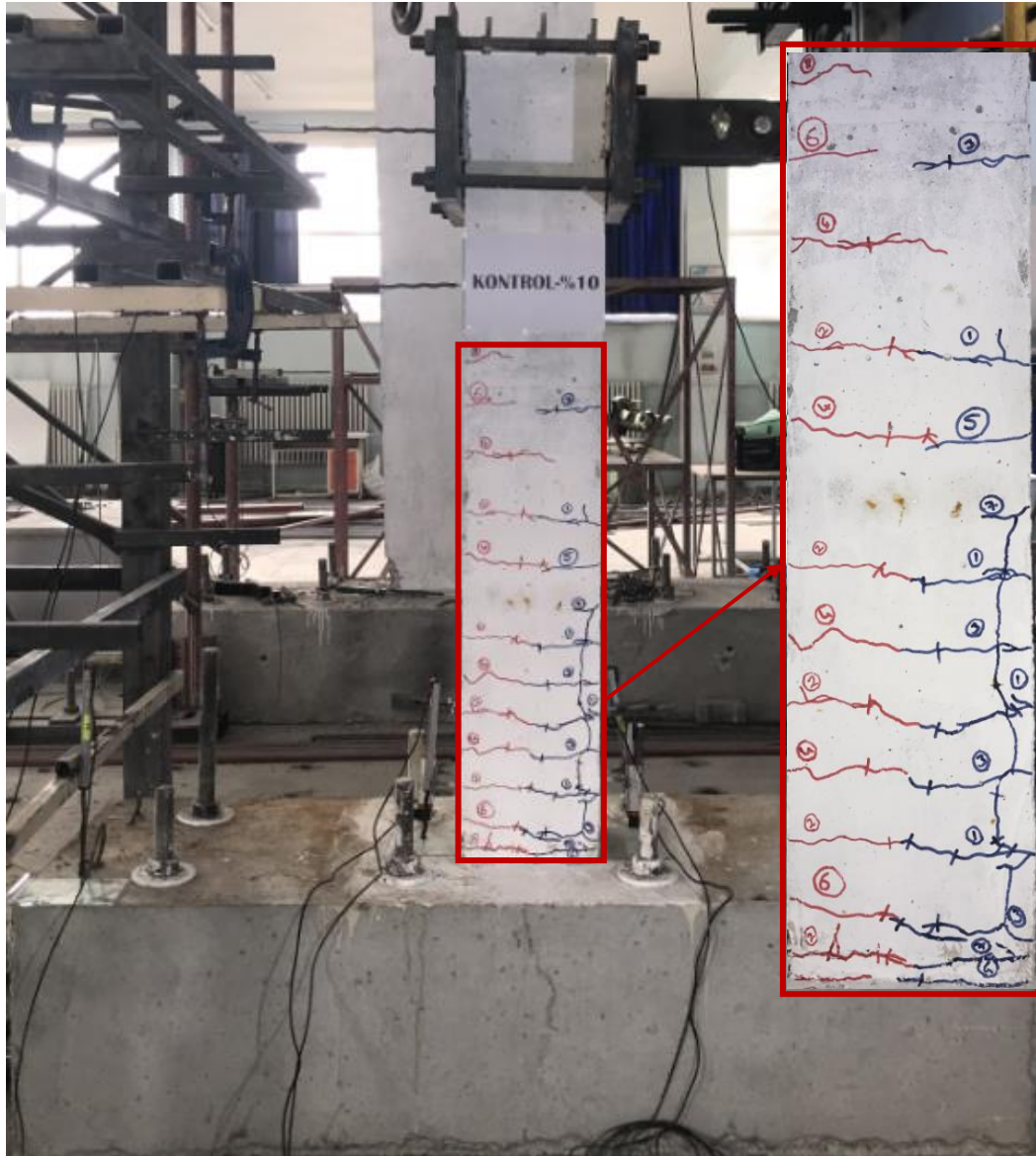
Şekil 4.65. Kontrol-% 10 deney numunesinde akma konumunda gözlenen çatlaklar
