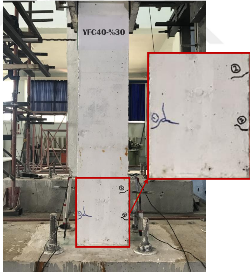
Şekil 4.162. YFC40-%30 deney numunesinde oluşan ilk çatlaklar
