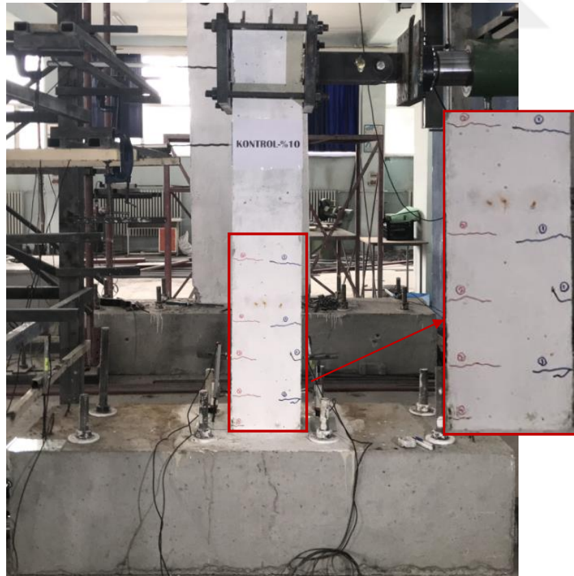
Şekil 4.64. Kontrol-%10 deney numunesinde oluşan ilk çatlaklar
