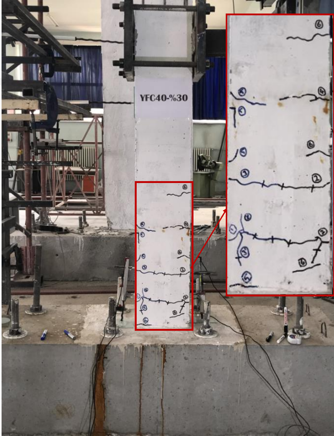
Şekil 4.163. YFC40-%30 deney numunesinde akma konumunda gözlenen çatlaklar
