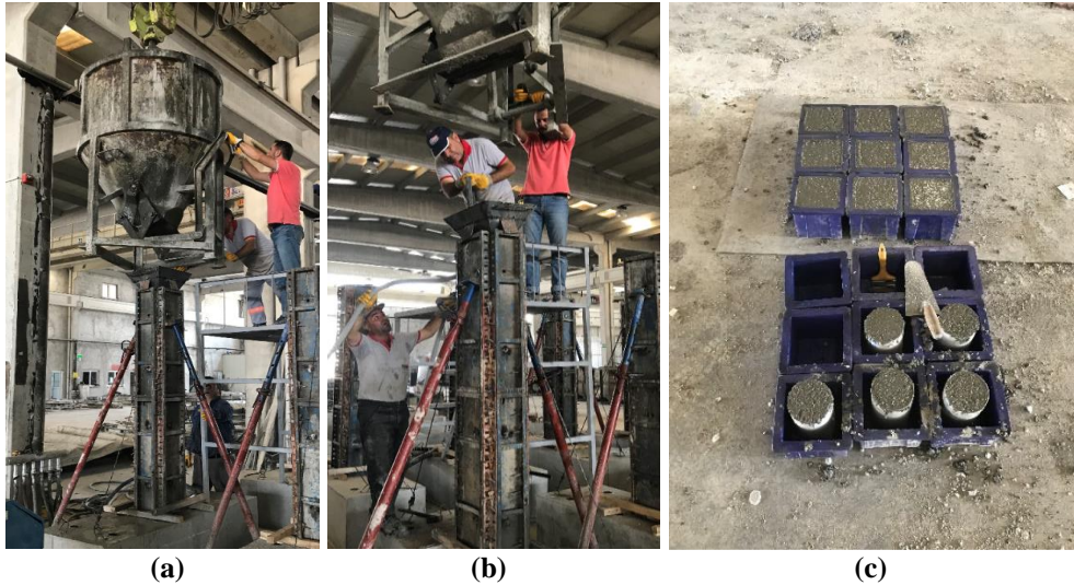
Şekil 3.12. a) Kontrol serilerin kolon beton dökümü b) Vibrasyon işlemi c) Küp numune örneklerinin alımı
