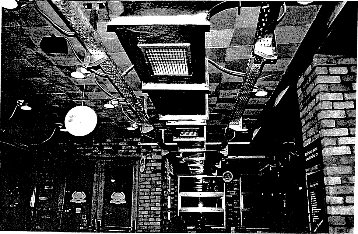
Şekil 108. İç Mekan Örneği
