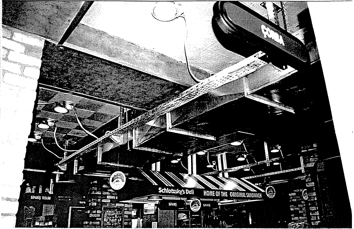
Şekil 103. Havalandırma Kanalları Şekil 104. Havalandırma Kanalları
