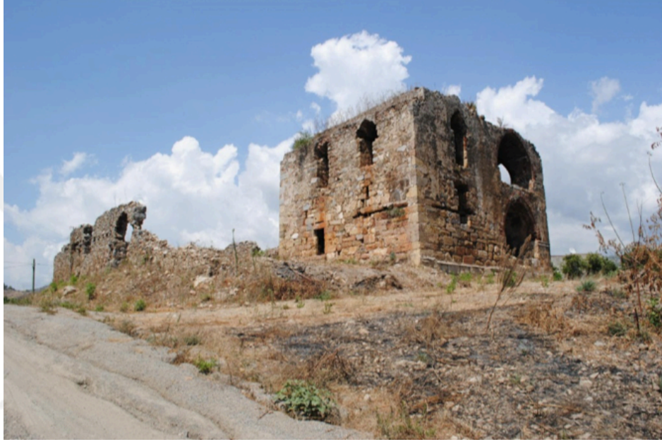
Şekil 4.5. Sedre Av Köşkü Restorasyon öncesi durumu(Restitütisyon Raporu; 2011)
