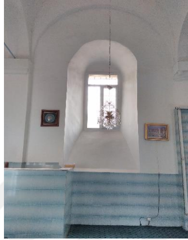
Resim 4.69. Taşlık Agios Georgios Kilisesi, güney cephe penceresi ve duvar yüzeyindeki seramikler (2019)
