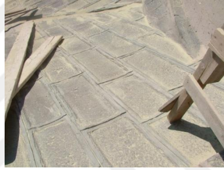
Resim 4.100. Tablakaya Panagia Kilisesi, çatı döşemesi restorasyon sonrası durumu (2019)
