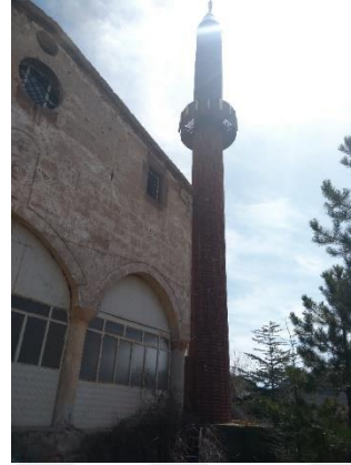
Resim 3.117. Yeşilhisar Başköy Hidrellez Kilisesi, cami işleviyle eklenen minare (2019)
