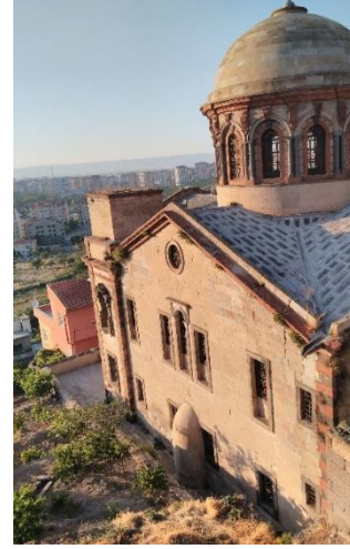
Resim 3.97. Tablakaya Panagia Kilisesi, güney cephesi görünümü (2019)
