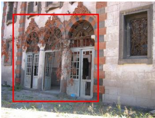
Resim 4.75. Tablakaya Panagia Kilisesi, narteks bölümü eski hali (Vakıflar arşivi, 2000)
