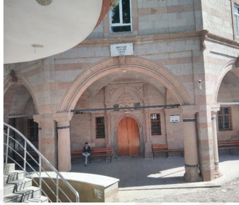
Resim 3.12. Surp Toros Kilisesi, batı cephesindeki portik (2019)
