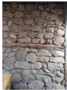
Resim 3.38. Faraşa Agios Ioannis Hrisostomos Kilisesi, kuzey apsisdeki ahşap hatıl (2019)
