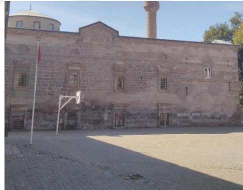
Resim 4.14. Everek Surp Toros Kilisesi, kuzey cephesi günümüz hali (2019)
