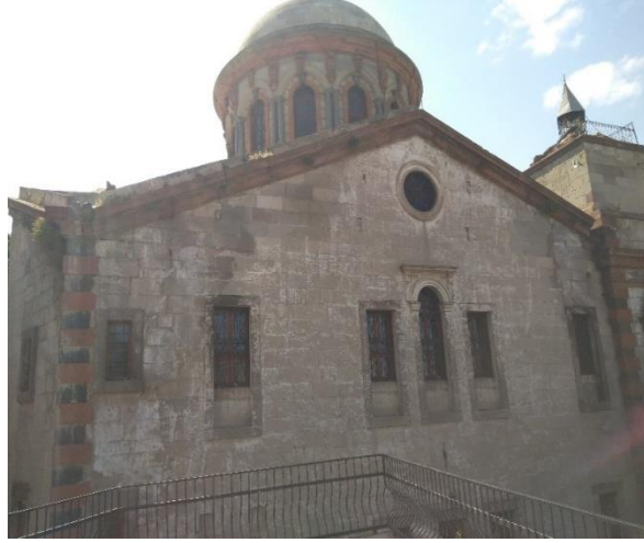
Resim 3.96. Tablakaya Panagia Kilisesi, kuzey cephesi görünümü (2019)
