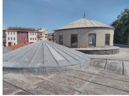
Resim 4.16. Everek Surp Toros Kilisesi, çatı döşemesi günümüz hali (2019)
