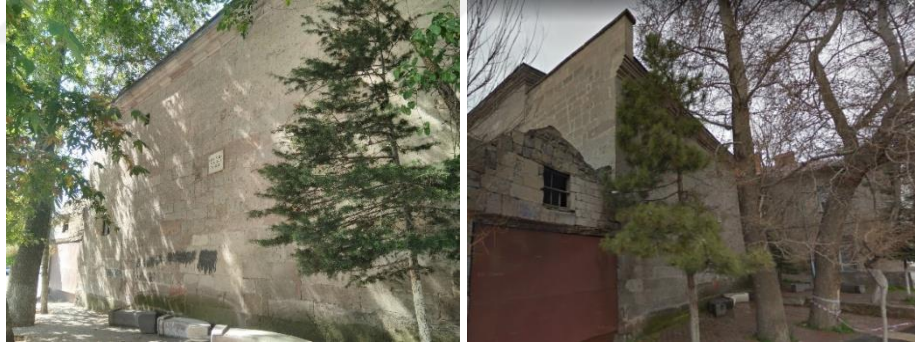
Resim 3.24. Surp Toros Kilisesi, doğu cephesindeki apsis kapatan duvar (2019)
