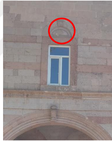
Resim 4.21. Everek Surp Toros Kilisesi, batı cephesindeki pencere üzerindeki haç simgesi günümüzdeki izi (2019)
