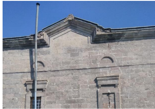
Resim 3.23. Surp Toros Kilisesi, güney cephesi alınlığı (2019)
