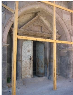
Resim 4.101. Tablakaya Panagia Kilisesi, portalın restorasyon öncesi vaziyeti (Vakıflar arşivi, 2003)
