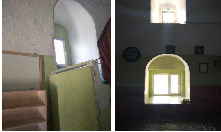
Resim 4.42 Faraşa Agios Ioannis Hrisostomos Kilisesi, kuzey cephesi pencere (2019)
