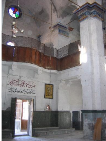
Resim 4.81. Tablakaya Panagia Kilisesi, batı iç mekân duvarının eski hali (Vakıflar arşivi, 2000)
