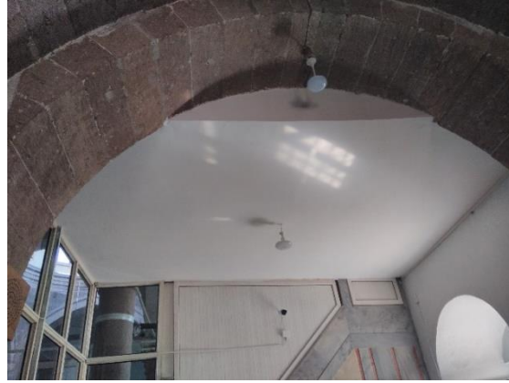
Resim 4.4. Everek Surp Toros Kilisesi, güney narteks mekânına eklenen beton üst döşeme-kemer ilişkisi (2019)
