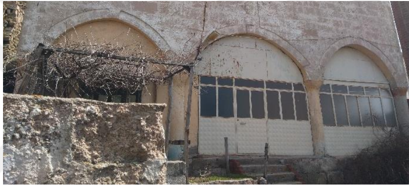
Resim 4.111. Başköy Hidrellez Kilisesi, doğu cephesindeki sonradan kapatılan narteks (2019)
