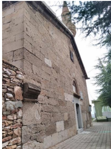
Resim 3.53. Kavaklı Agios Basileos Kilisesi, giriş cephesi (2019)
