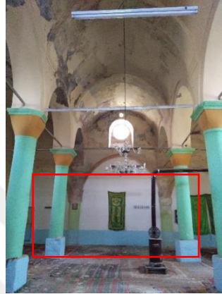
Resim 4.107. Başköy Hidrellez Kilisesi, apsisi kapatmak amacıyla eklenen duvar (2019)
