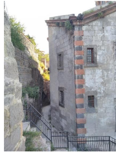
Resim 3.99. Tablakaya Panagia Kilisesi, doğu cephesindeki apsise ulaşan açılı cephe yüzeyi (2019)
