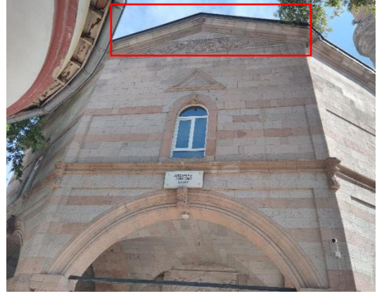
Resim 4.19. Everek Surp Toros Kilisesi, batı cephesi günümüz hali (2019)
