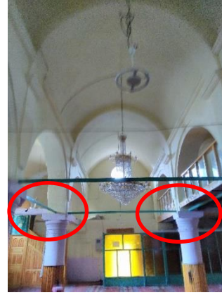
Resim 4.53. Kavaklı Agios Basileos Kilisesi, günümüze ulaşan özgün ahşap kirişler (2019)
