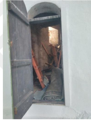
Resim 3.9. Surp Toros Kilisesi, apsis ile doğu duvarı arasındaki dar koridor (2019)
