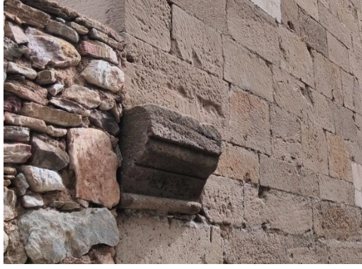
Resim 3.55. Kavaklı Agios Basileos Kilisesi, giriş cephesi kuzey yönündeki çıkma yapan taş (2019)
