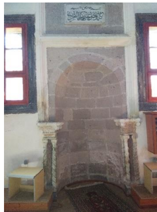
Resim 4.114. Tablakaya Panagia Kilisesi, mihrap (2019)
