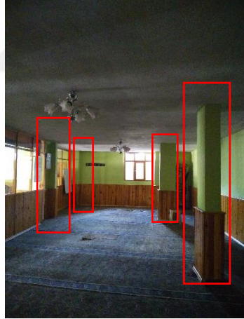
Resim 4.32. Faraşa Agios Ioannis Hrisostomos Kilisesi, zemin kattaki betonarme kolonlar (2019)
