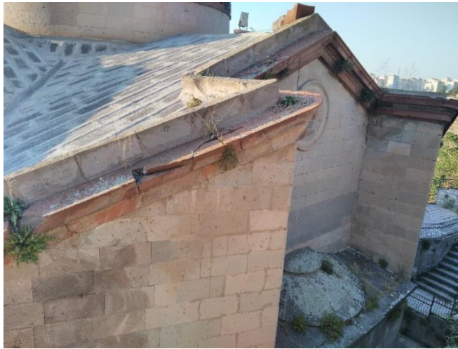
Resim 3.98. Tablakaya Panagia Kilisesi, doğu cephesine güney doğu yönünden bakış (2019)
