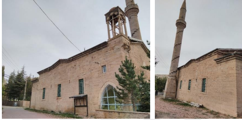
Resim 3.73. Taşlık Agios Georgios Kilisesi, kuzey cephe (2019)
