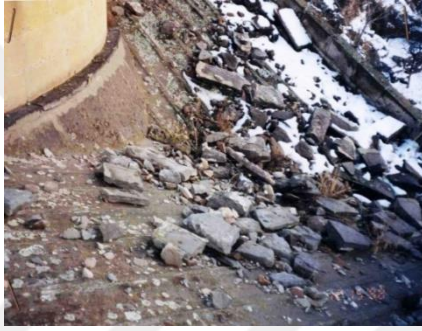
Resim 4.99. Tablakaya Panagia Kilisesi, çatı döşemesi restorasyon öncesi durumu (Vakıflar arşivi, 2003)
