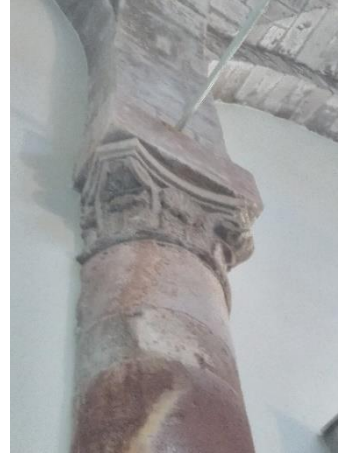
Resim 3.7. Surp Toros Kilisesi, kuzey beden duvarına gömülü sütun (2019)
