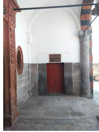
Resim 4.88. Tablakaya Panagia Kilisesi, güney narteks duvarının günümüz hali (2019)
