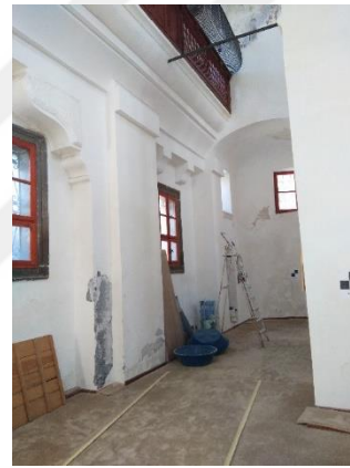
Resim 3.91. Tablakaya Panagia Kilisesi, kuzey duvarındaki galeri döşemesi taşıyıcıları payanda ve plastırlar (2019)
