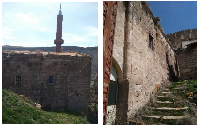
Resim 3.114. Yeşilhisar Başköy Hidrellez Kilisesi, kuzey cephesi (2019)
