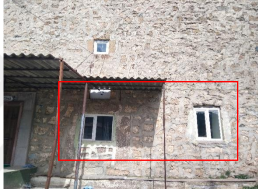
Resim 4.44. Faraşa Agios Ioannis Hrisostomos Kilisesi, batı cephesindeki yatay dikey pencere görünümü (2019)
