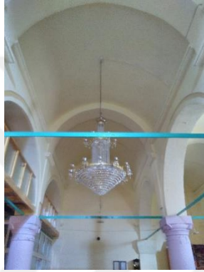
Resim 3.43. Kavaklı Agios Basileos Kilisesi, orta nefteki beşik tonoz ve enlemesine kemerler
