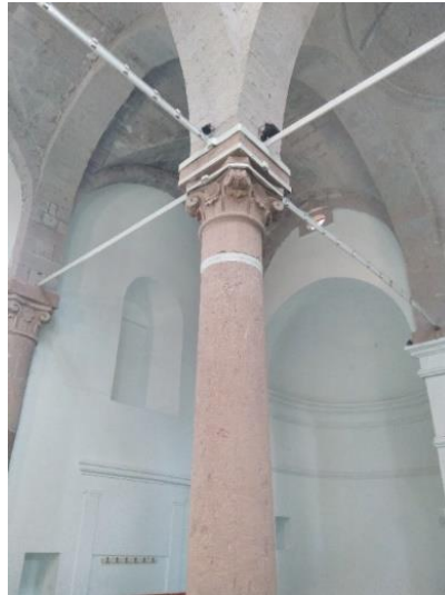
Resim 3.27. Sütunlardaki demir kullanımı
