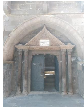
Resim 4.102. Tablakaya Panagia Kilisesi, portalın restorasyon sonrası vaziyeti (2019)
