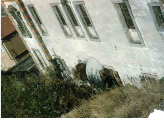
Resim 4.91. Tablakaya Panagia Kilisesi, güney cephesinin geçmiş vaziyeti (Vakıflar arşivi, 2000)
