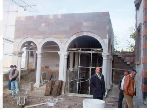
Resim 4.106. Tablakaya Panagia Kilisesi, papaz evi restorasyon aşaması (Vakıflar arşivi, 1995)
