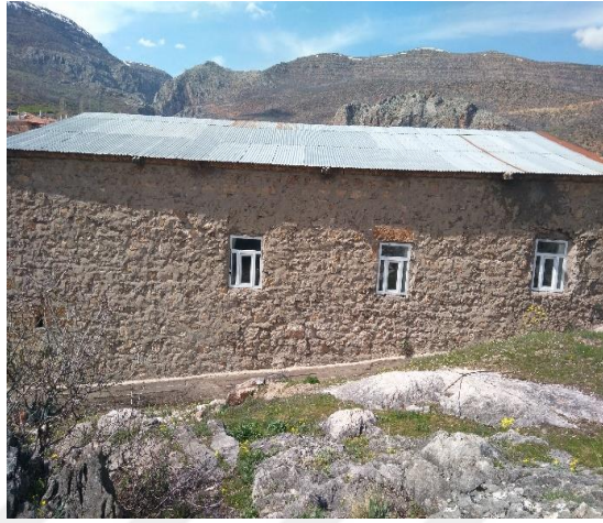
Resim 4.38. Faraşa Agios Ioannis Hrisostomos Kilisesi, çatı kaplama malzemesi sac
