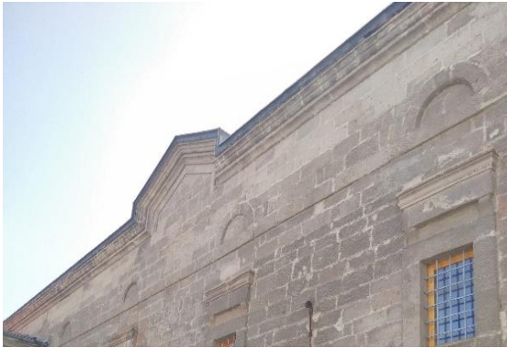
Resim 3.19. Surp Toros Kilisesi, kuzey duvarına eklenen 3,5 metrelik duvar (2019)
