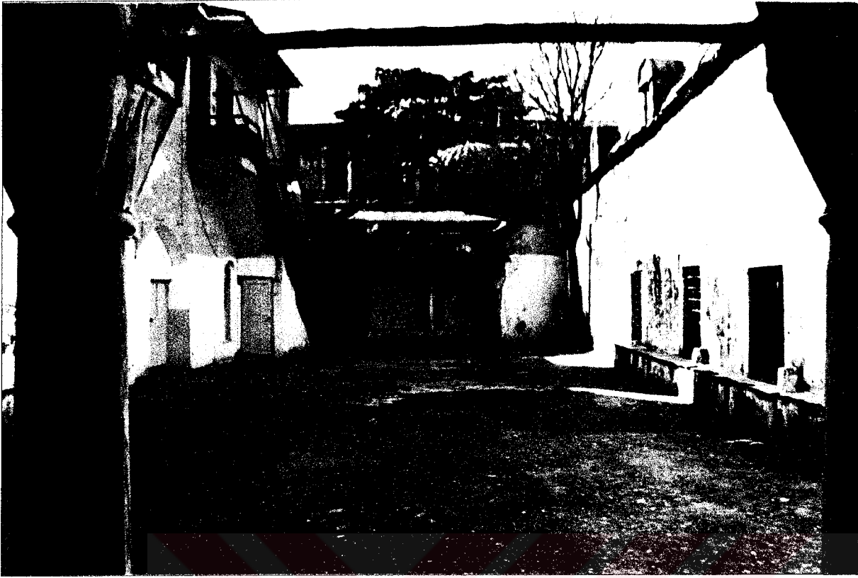
Res-32- Tabhane avlusu kervansaray cephesi
