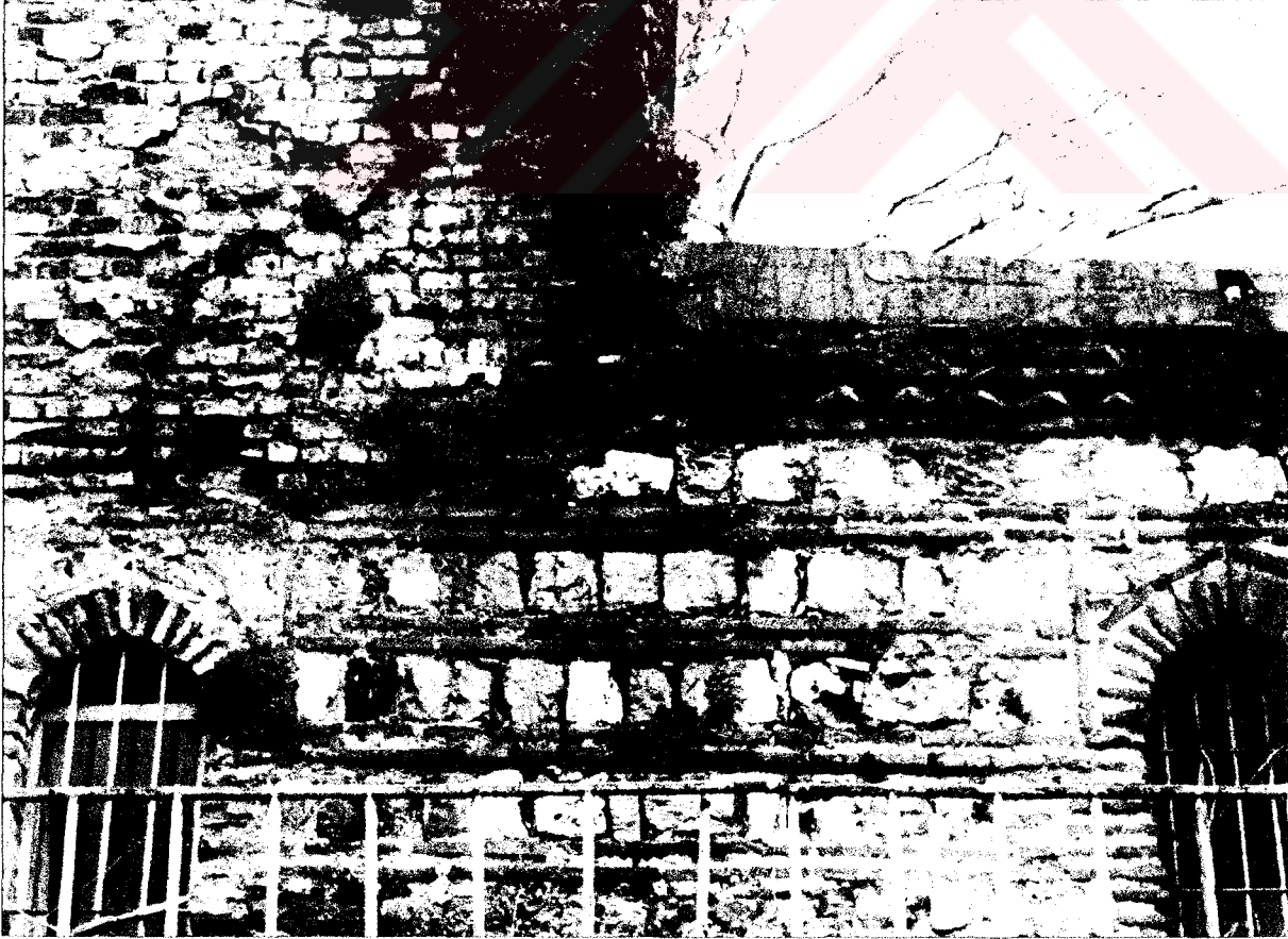
Res -8- Darulhadis-Mekteb geçiři ve darulhadisin kırı saćak izeri
