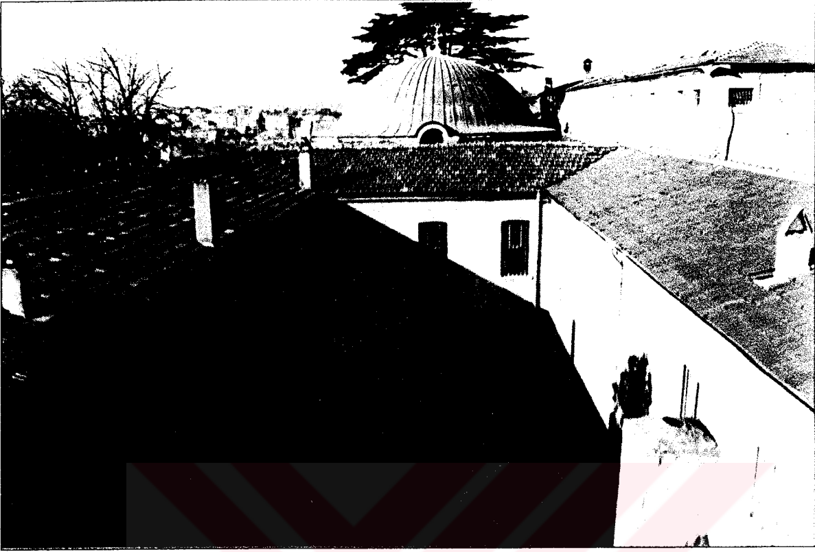
Res-22- Kervansaray güneydoğu kanadı, XIX.yüzyılda avlu haline getirilmiş ve kat ıkılmıştır.
