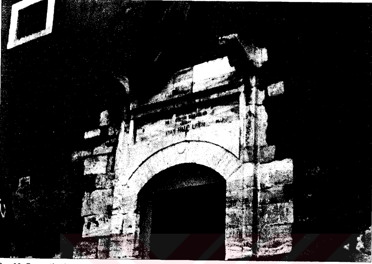
Res-36- Darüşşifa girişi ve giriş saçağı kalıntıları
