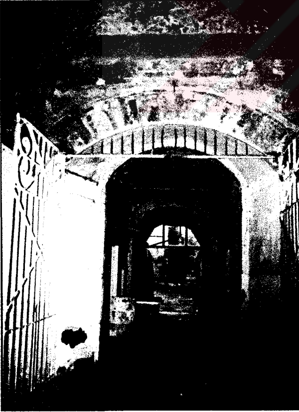
Res- 20-Kervansaray ahır kantları giriş kapısı
