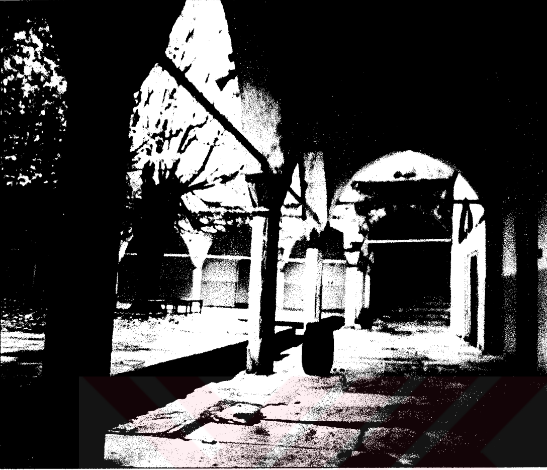
Res-28- İmaret orta avlusu revakları
