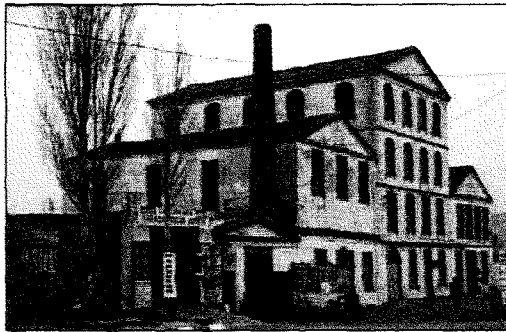
Resim 5-40. Ayvalık, Madra Zeytinyağı Fabrikası.
