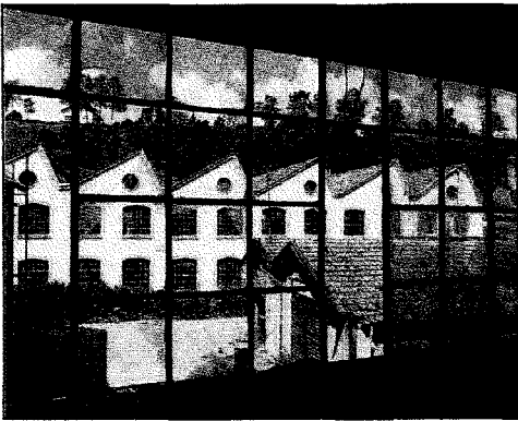
Resim 2-19. Şed çatılı fabrika örneği.
