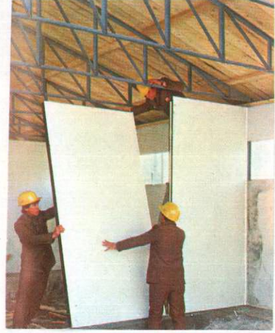
12-13 İç tavan panoları ve iç duvar panoları monte edilirler
