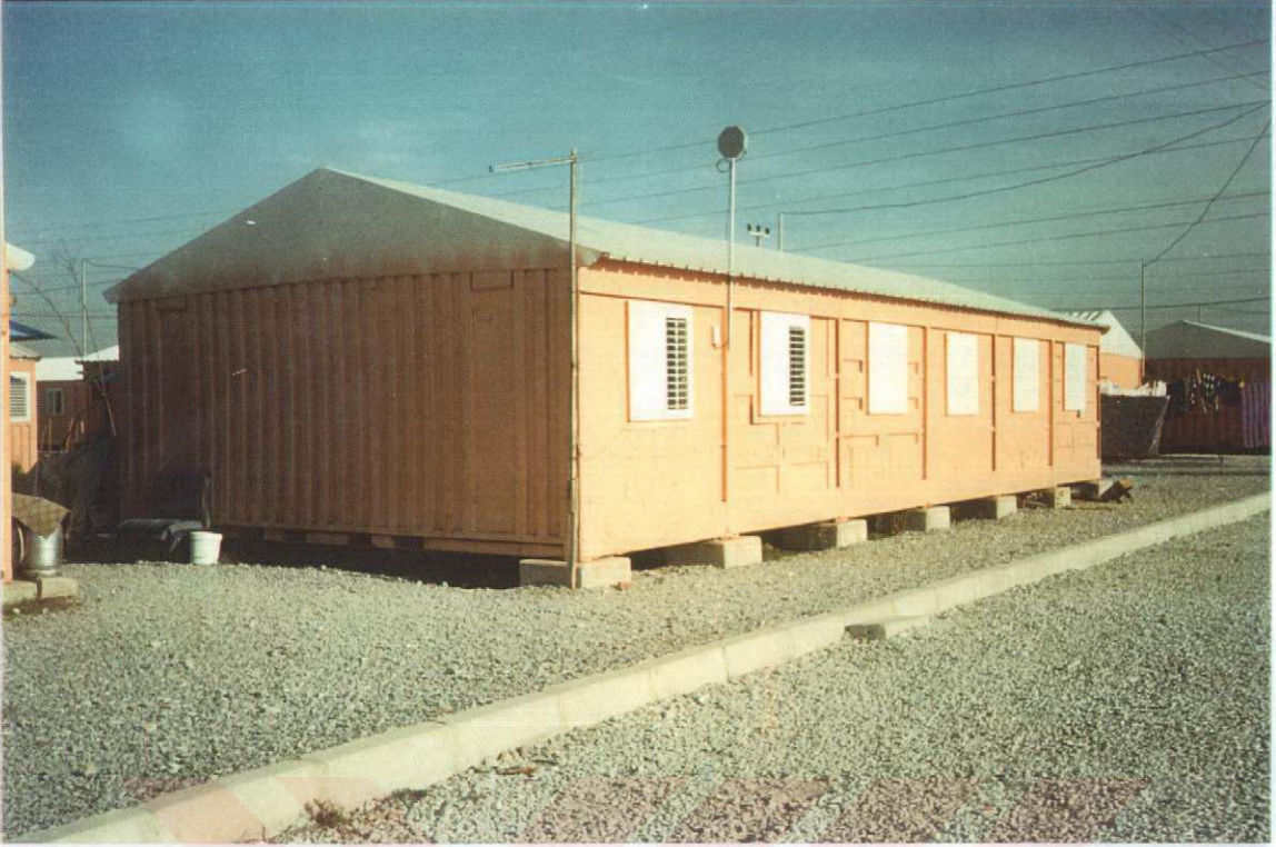
RESİM 16: İsrail Evi. Metal İskelet ve Metal Kaplamalı Sadwich Pano. Tasarım Alanı Yeterli Eklenti Yok
