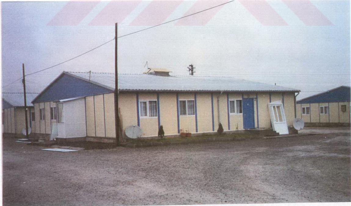
RESİM 21: Alman Evi ~ 55 m 2 ~ 2 Oda, Salon, Mutfak Nişi, WC-Banyo. Ancak Yine Girişe Rüzgarlık Eklenmiş
