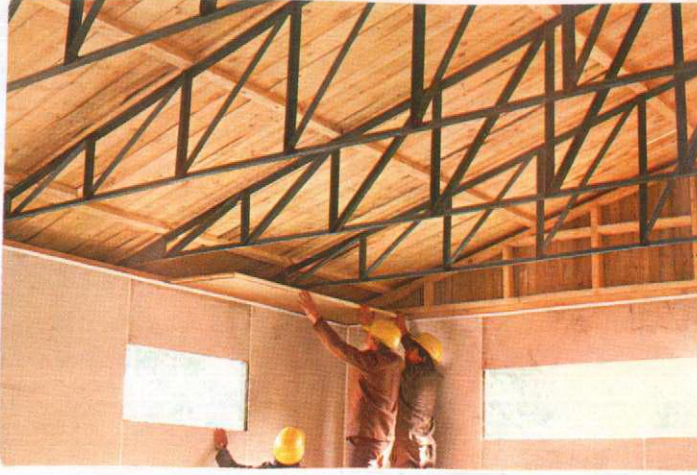
12-13 İç tavan panoları ve iç duvar panoları monte edilirler
