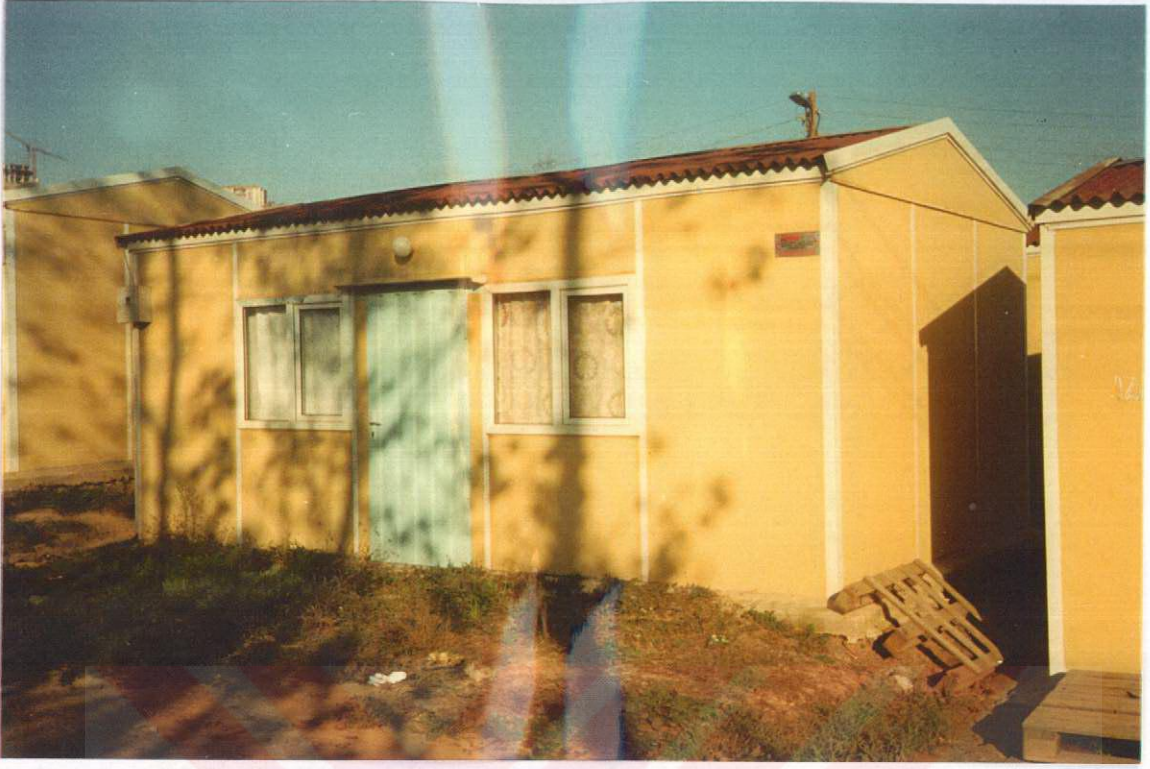
RESİM 28: Sakarya Vefa Prefabrik. Temel Toprağa Yakın. Tasarım Yetersiz
