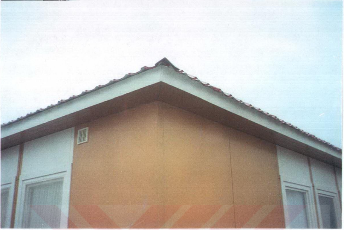
RESİM 30: Avusturya Evi Köşe Çatı
