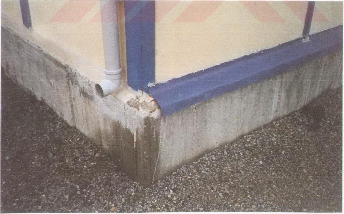
RESİM 23: Alman Evinde Pano Temel Birleşmiş. Temeller Yüksek ve Araları Dolu. Yerden Su Almıyor
