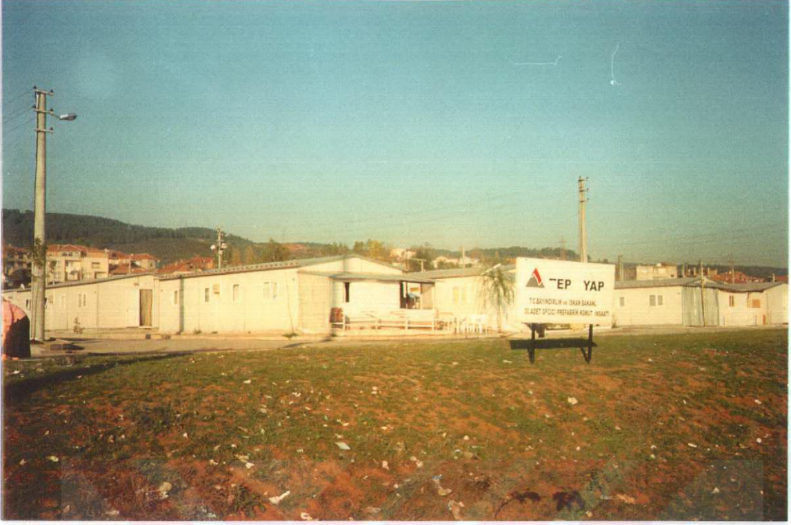
RESİM 24: Bayındırlık ve İskan Bakanlığı'nın Tepe Yapı Firması'na Yaptırıldığı Deprem Konutları. İkiz Konut 30+30 = 60m^2
