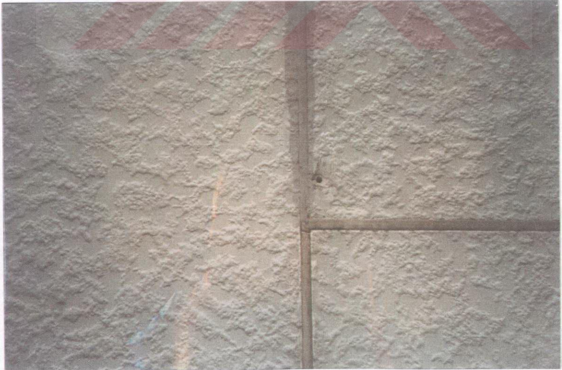
RESİM 15: Japon Evinde Panolar Arası Derz ve Elastik Macun
