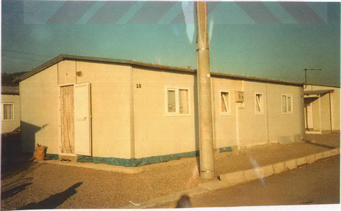
RESİM 25: Temel Alçak Olduğu İçin Yerden Su Almaya Karşı Sağlıksız. Tedbir Alınmış. Eklentiler Var.
