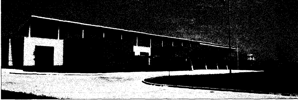
Şekil 4.30: Chilsholm Trail İlköğretim Okulu, Texas, A.B.D., Çelik İskelet Yapım Sistemi Uygulaması (Tominaga, 1996, s.67-69)
