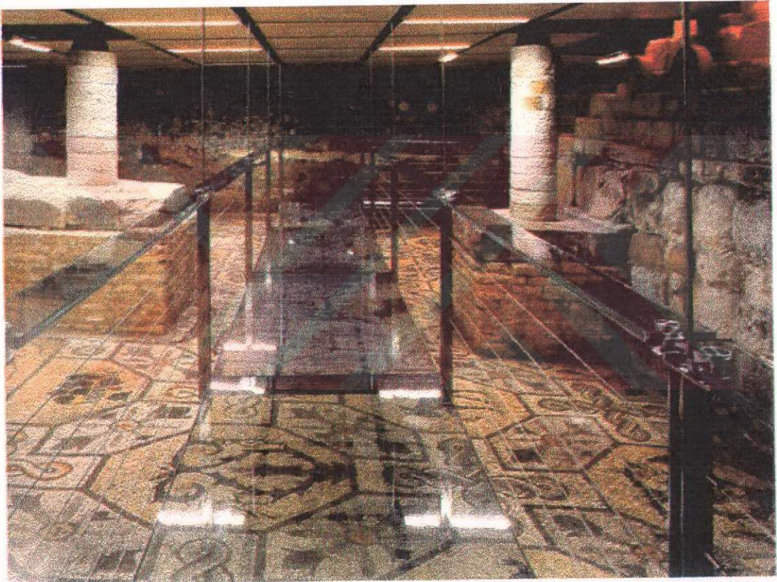
Şekil 3.35. Tasarım: Ottavio Di Blasi Associati, İtalya'daki bir bazalikada mozaiklerin ziyaretçilere açılabilmesi için camın saydamlığından yararlanılarak yapılmış olan yeni yürüme yolu (Detail, 2000, s:3, sy:364-365)
