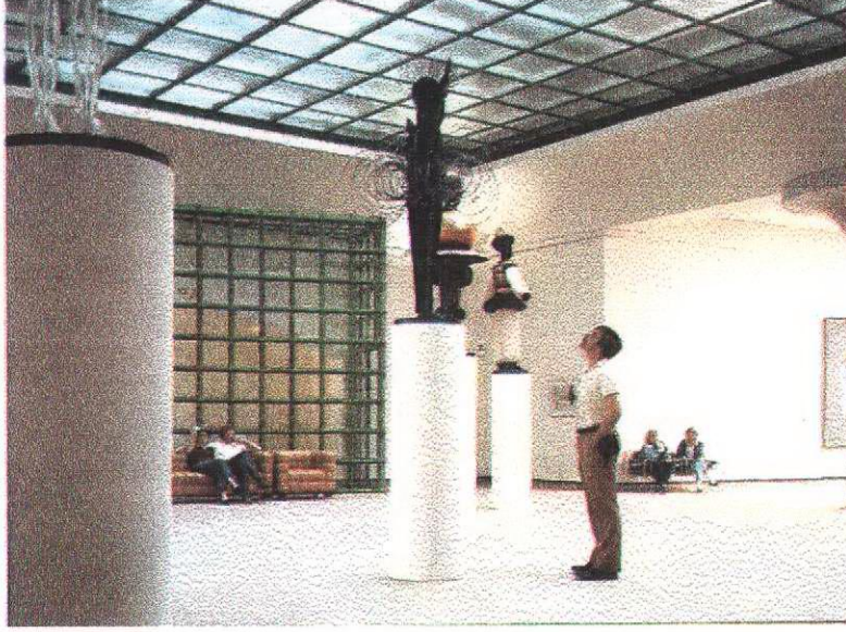
Şekil 2.8. Tasarımcı: James Stirling – Stuttgart – Almanya’da bir galeride güvenliği sağlamak amacıyla yangın kesici ara tabakalı cam kullanılarak uygulanmış tavan döşemesi (Button D. And Pye B. – 1993, Glass İn Building, Pilkington Glass Limited, Oxford, sy:309)
