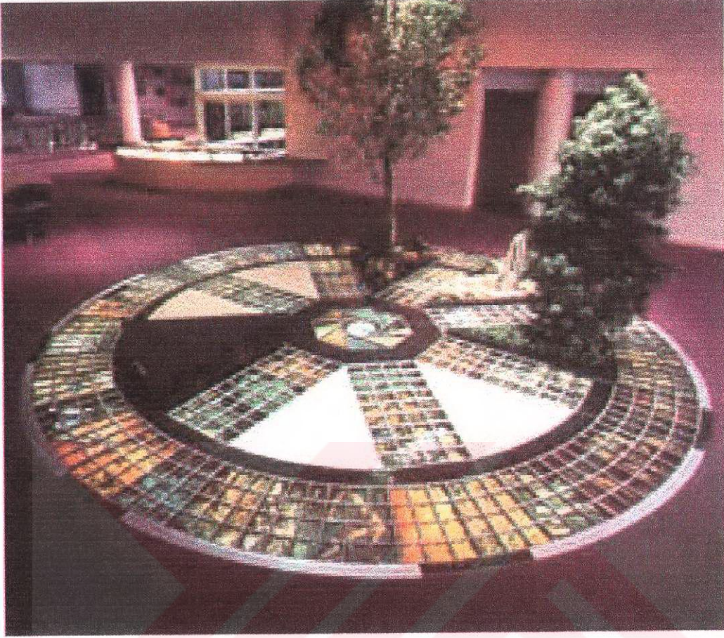
Şekil 2.19. Boşluklu cam döşeme blokları , çeşitli yöntemler ile renklendirilerek, kullanıldıkları mekana estetik etki katmakta ve görselliğin ön planda tutulduğu mekanlarda tercih edilen malzemelerden biri olmaktadır. (Circle Redmont, 2000)
