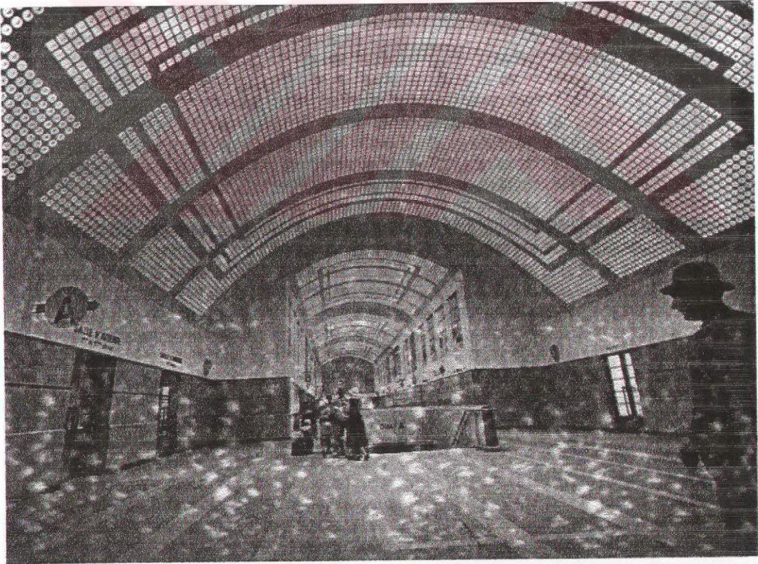
Şekil 2.21 Tasarımcı : Andre Ventre – Chantiers Tren İstasyonunda içi boşluklu cam döşeme bloklarının, parçalı yapısı sayesinde, eğrisel hatların oluşturulmasında kullanım kolaylığı getirmesi ve esnek tasarımlara olanak verebilmesinden dolayı tasarlanmış olan tonoz şeklindeki tavan döşemesi (McGrath.R- 1937,Glass in Architecture & Decoration, ACC.Press,London, sy:253)
