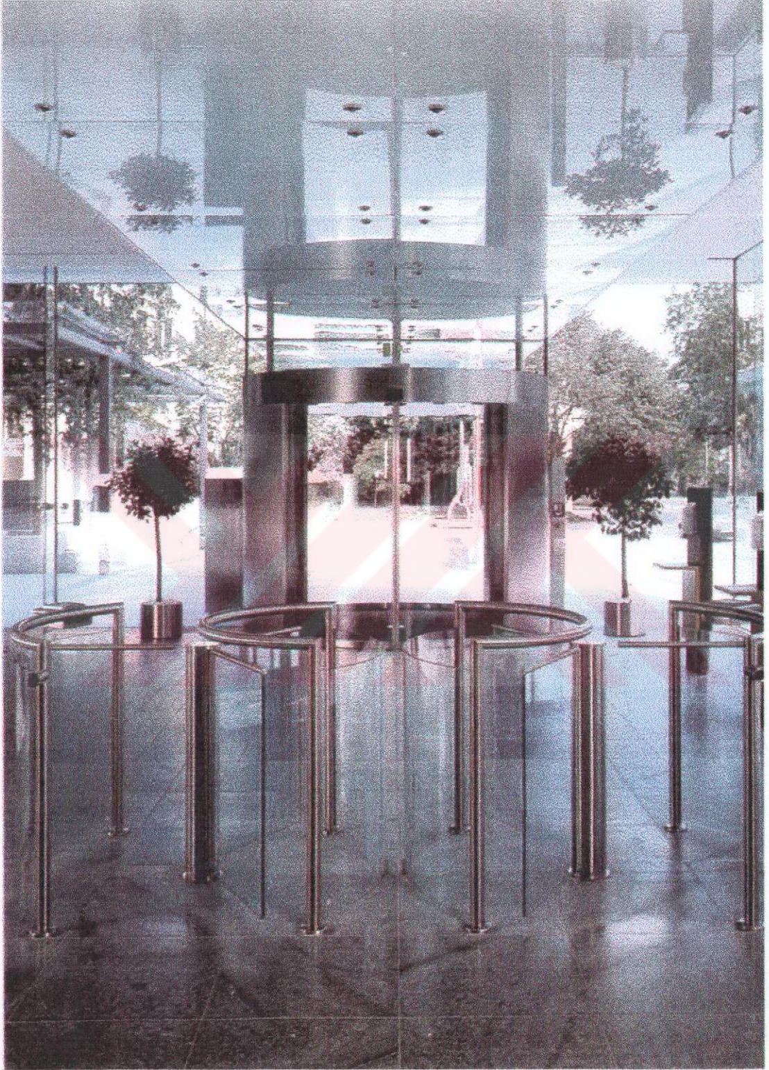
Şekil 3.22. Tasarım: Drei Architekten + Partner, Stuttgart'daki sigorta binasında mekandaki cam malzemeyi ön plana çıkarmak için noktasal tespit elemanları ile kurulmuş olan tavan döşemesi tercih edilmiştir. (Glas, October/November, 1998, sy:41)
