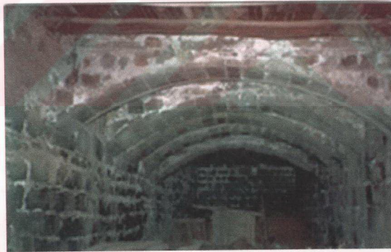
Resim 3. 5. Cemil Paşa Konağı Bodrum Kat Kemerleri
