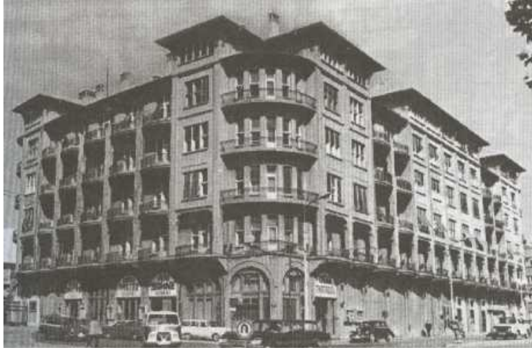
Resim 2.9 : Ankara II.Vakıf Apartmanı genel görünüşü.
