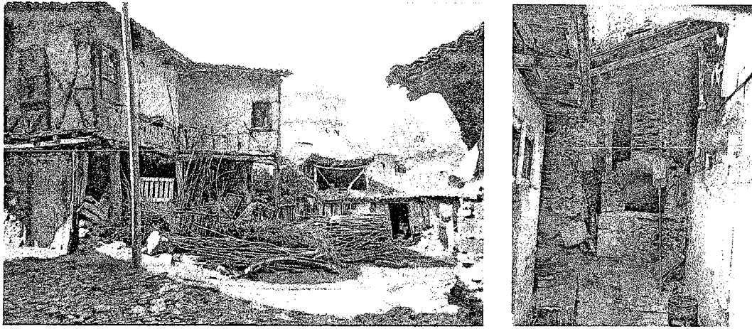
Resim 2.26, 2.27; Servis mekanlarının yer aldığı avlu ve ocak evi
