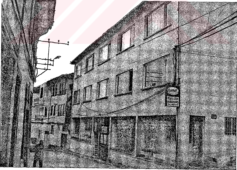
Resim 3.79, Geleneksel konutun yerine inşa edilen betonarme yapı
