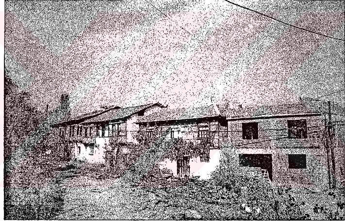
Resim 2.51; Geleneksel konutlar ve yeni yapılan betonarme ev
