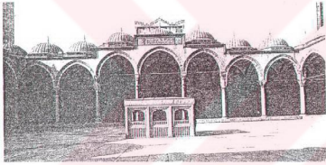
Şekil 5.12.18 Avlunun kuzey cephesi (KUBAN 2000, S. 248)
