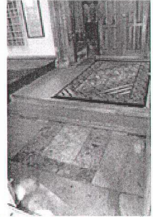
Şekil 5.3.7 Zemin döşemesi (foto. ÖZEL)
