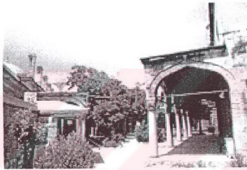
Şekil 5.14.5 Güney girişinden son cemaat yerinin görünüşü (foto. ÖZEL)
