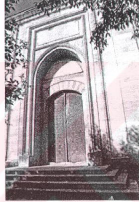
Şekil 5.13.11 Avlu yan kapısı dış görünüşü (foto. ÖZEL)
