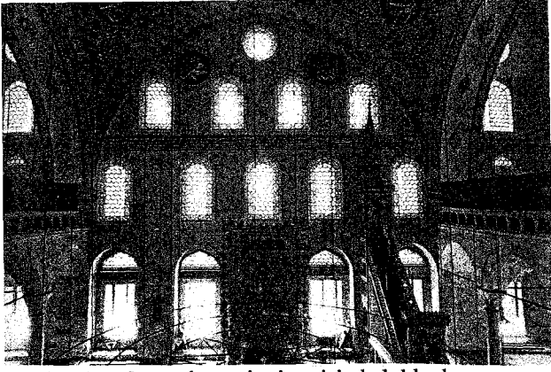
Şekil 4.22a Osmanlı cami mimarisinde kible duvarı, olabildiğince delinerek ışık içinde olması sağlanmış bir yüzey olarak ele alınmıştır. Zal Mahmud Paşa Külliyesi (KURAN 1986, şek. 221)
