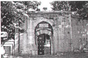
Şekil 5.5.4 Avlu kuzeydoğu kapısı (foto. ÖZEL)
