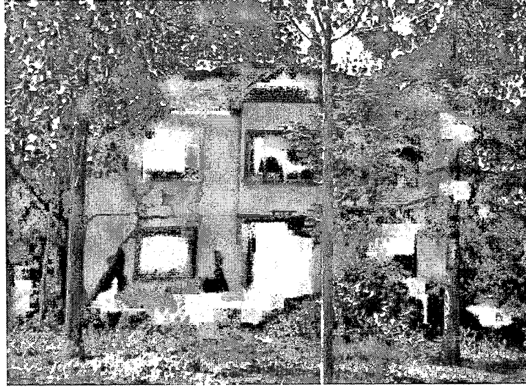
Fotoğraf 32 Düzce'de 12 Kasım depreminde zarar görmüş hımiş sistem bir yapı (Kaynak: İlgı Yüce Aşkun)
