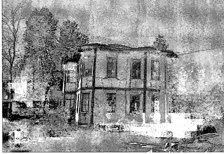
Fotoğraf 26 Düzce'de 12 Kasım depreminde zarar görmüş hımiş sistem bir yapı (Kaynak: Halûk Sezgin)
