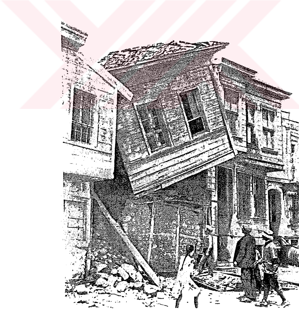
Resim 3. 2 1912 Şarköy- Mürefte depreminde zarar görmüş olan geleneksel ahşap bir konut (Cogito)
