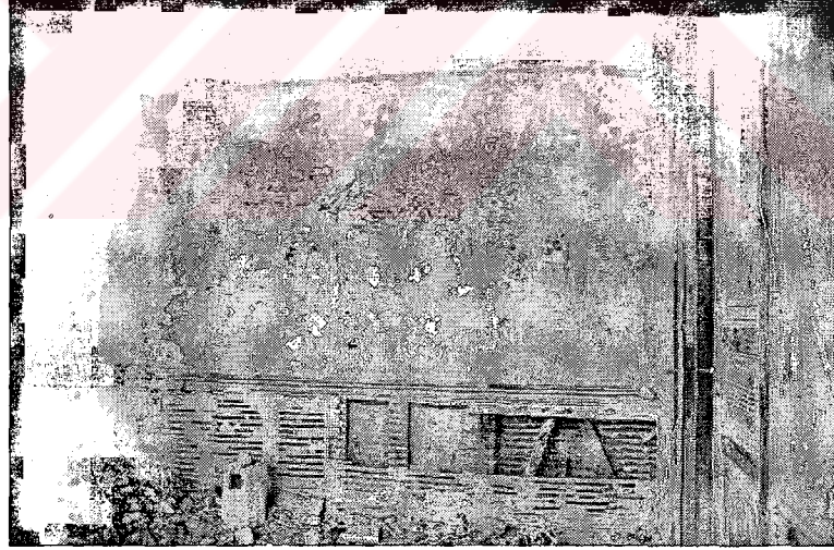
Fotoğraf 18 Bağdâdî duvarda bozulma (Fotoğraf: Dışkaya, H., Celaliye)
