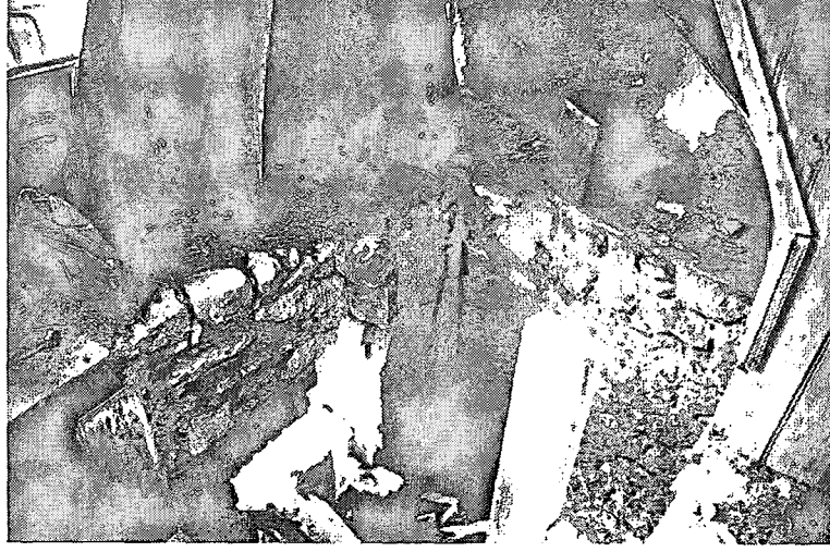
Fotoğraf 21 Ahşap karkasın oturduğu kârgir duvarda bozulmalar (Fotoğraf: Dışkaya, H., Celaliye)
