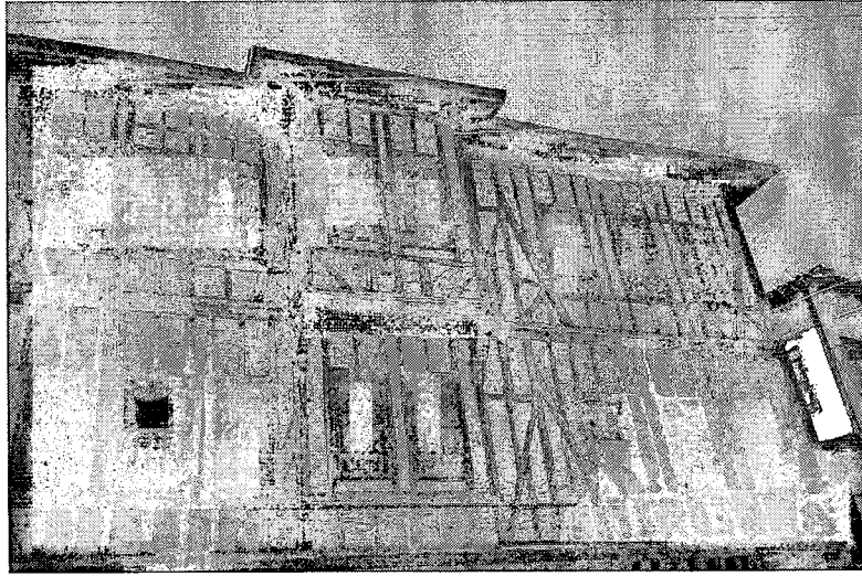
Resim 4. 2 Safranbolu'da hımiş tekniğinde ev (Çobancaoğlu, T. Arşiv)
