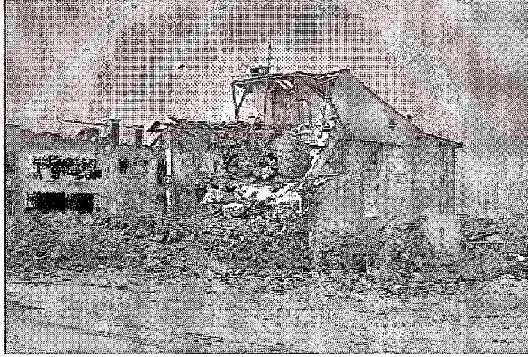
Fotoğraf 37 12 Kasım depreminde yıkılmış betonarme bir yapı (Kaynak: İlgı Yüce Aşkun)
