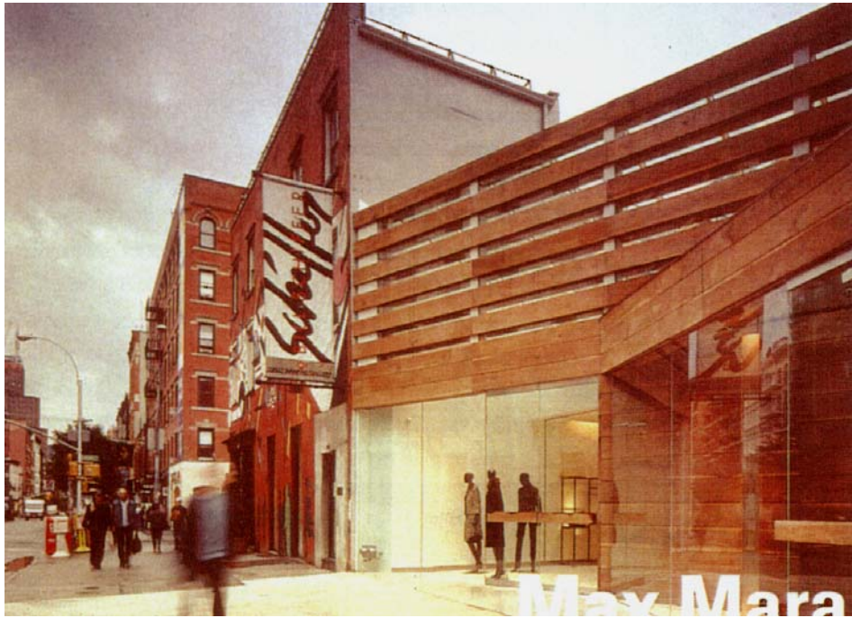
Şekil 3.10. New York'ta bulunan, Reggιο Emilio tarafından tasarlanan, Max Mara mağazasının dış cephesi ahşap ve cam malzeme ile tasarlanmıştır. İç mekanda da aynı süreklilik sağlanmıştır. (Interni, Şubat 2004)
