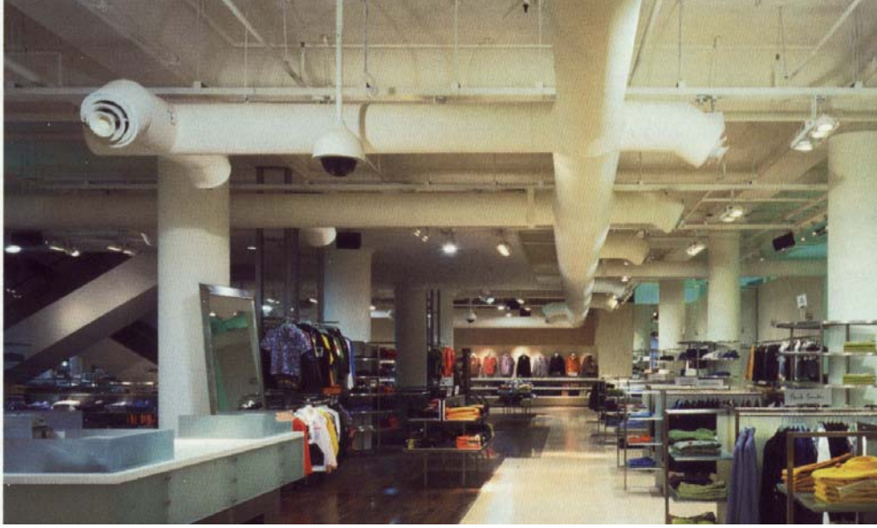
Şekil 3.55. İngiltere'nin büyük zincir alışveriş mağazalarından Selfridges'in Londra'daki mağazasında havalandırma ve aydınlatma sistemleri gizlenmemiştir. Tüm kanallar, tavan rengi ile aynı renge boyanmıştır. (S.Cliff, 1999, s. 93)
