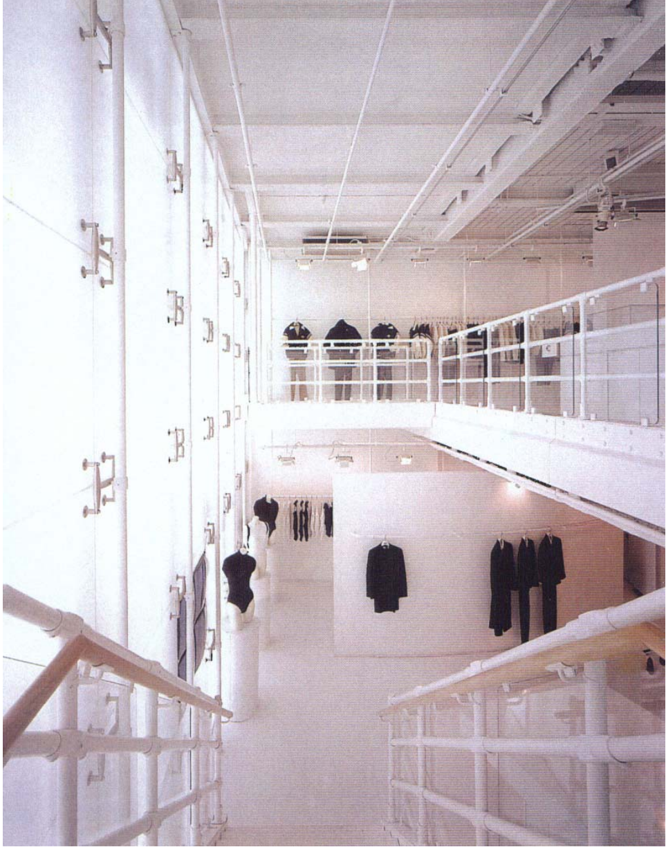
Şekil 3.11. Marino & Associates tarafından tasarlanan Londra-DKNY mağazasında cephede metal strüktürlerle desteklenen opak cam paneller kullanılarak mekanda doğal ışık kullanımı sağlanmıştır. ( Rasshied Din, 2000, s.102 )
