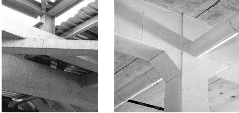
Resim 10 Levhalarla korunmuş Çelik Taşıyıcı Elemanlar[110]
