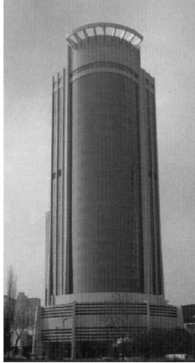
Resim 6 Yapı Kredi Plaza D Blok, İstanbul [106,s34]
