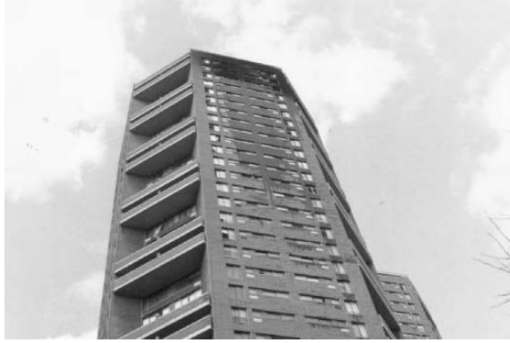
Resim 16 Schomberg Plaza Binasının Yangın Sonrası Durumu[96].
