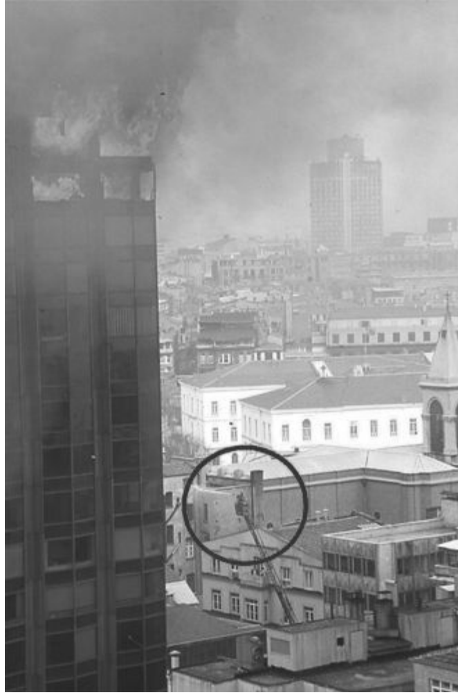
Resim 19 Odakule Binası Yangını 1991[152]
