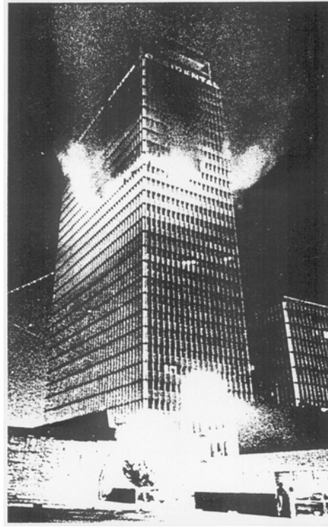
Resim 22 Occidental center tower yapısı yangını[5]
