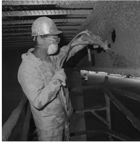
Resim 9 Çelik taşıyıcı kirişe koruma katmanının (vermikülit ve çimento karışımı)püskürtülerek uygulanması [110]
