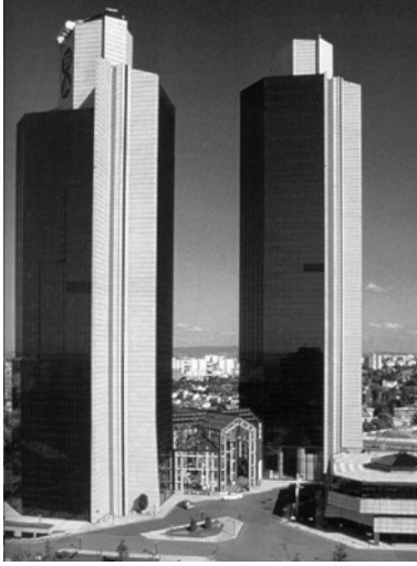
Resim 4 Sabancı Center, İstanbul [106,s34]
