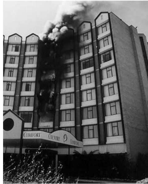
Resim 13 Otel Yangını, NSW, Australia 1999 [35] Parapetlerde kullanılan PVC malzemenin yangını desteklemesi ile üst katlara yayılan cephe yangını
