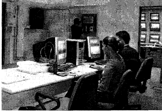
Resim 2.10 – Tekfen Tower CCTV Merkezi 37
