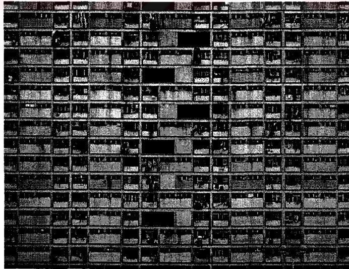
Resim 3.4 – Standartlaşmanın Yoğun Olduğu Bir Örnekte Cephede Modülasyon, Renk ve Ton Farklılıkları ile Dairelerin Ayrıştırılmaya Çalışıldığı Bir Örnek 64
