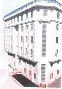
Resim 11 PU kaplama malzemesi uygulanmış yönetim binası
