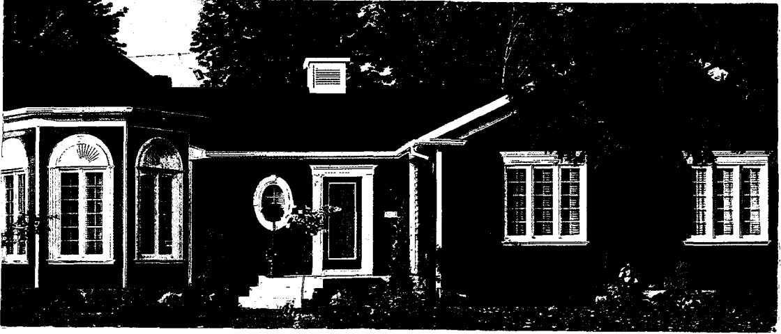
Resim 6 Ahşap kaplama malzemesinin dış cephelerde kullanımı
