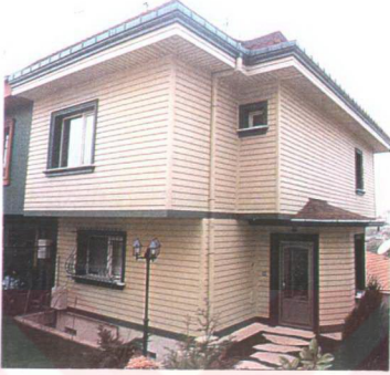
Resim 10 PU kaplama malzemesi uygulanmış konut
