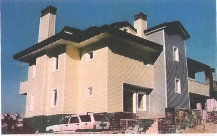
Resim 13 PVCyalı baskısı uygulaması
