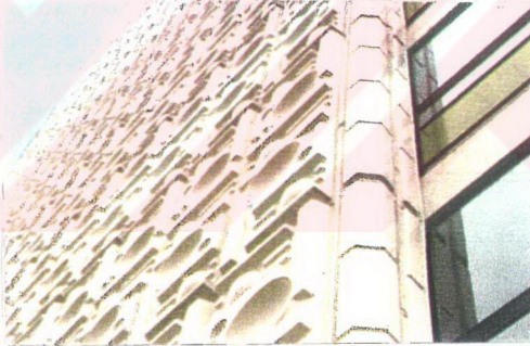
Resim 12 PVC malzeme ile cephe uygulaması [140, s.252]
